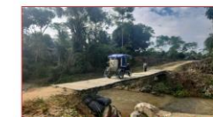
PUENTE DE CAMINO "SAYASA"
