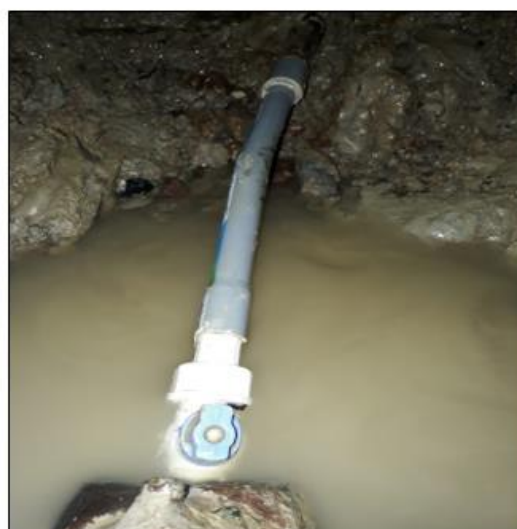
Reparación de fuga en conexiones domiciliarias de agua potable
