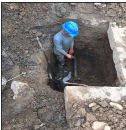
Refacción de redes de distribución de agua potable secundaria
