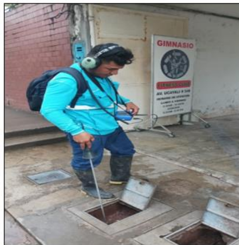
Detección de fuga en conexiones domiciliarias de agua potable con equipo Geófono acústico
