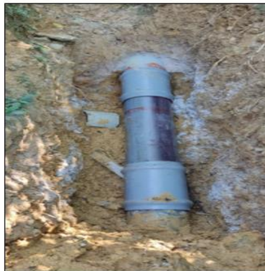
Refacción de redes de distribución de agua potable primaria
