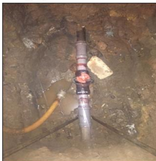
Refacción de redes de distribución de agua potable secundaria
