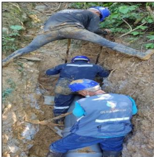
Refacción de redes de distribución de agua potable primaria
