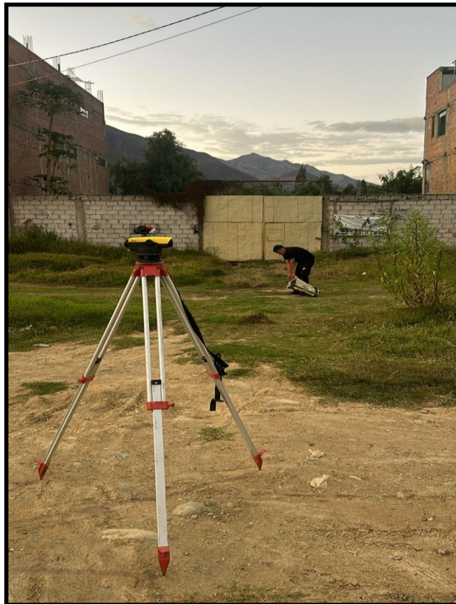
Realizando el levantamiento topográfico
