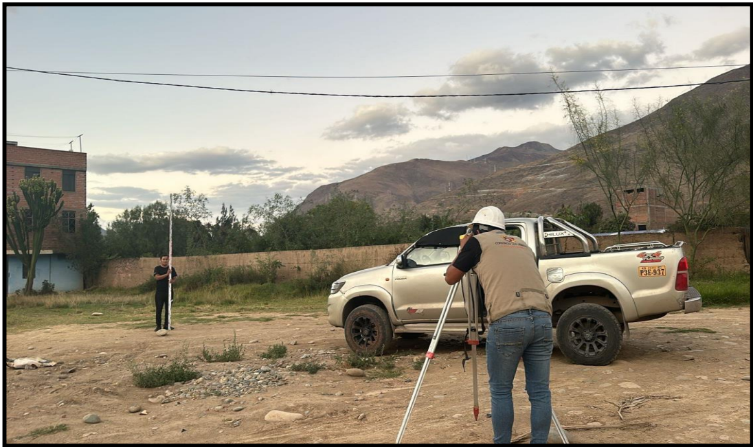
Realizando el levantamiento topográfico
