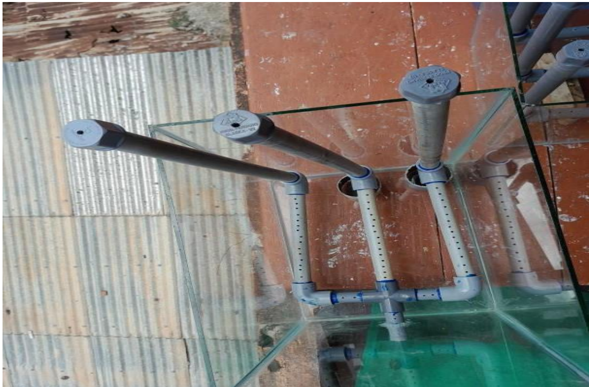
Imagen 07: Con los recipientes de vidrios ya mandados a hacer para el lombrifiltro y el humedal artificial con sus respectivas medidas, se procedió a hacer la instalación de las tuberías por donde se filtrará el agua y se realizará la ventilación del sistema.
