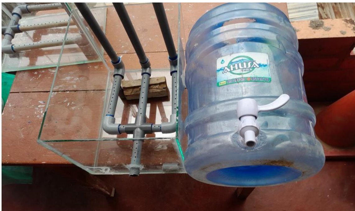
Imagen 08: También se procedió a instalar las cañerías, esto con la finalidad de poder controlar el flujo del agua.
