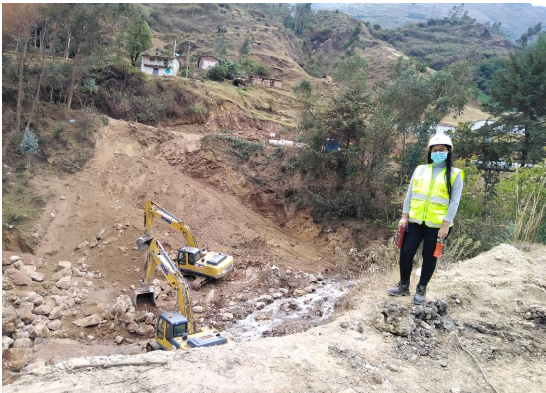
Nota: Participación del bachiller en el movimiento de tierras en campo para la carretera Huánuco – La Unión – Antamina
