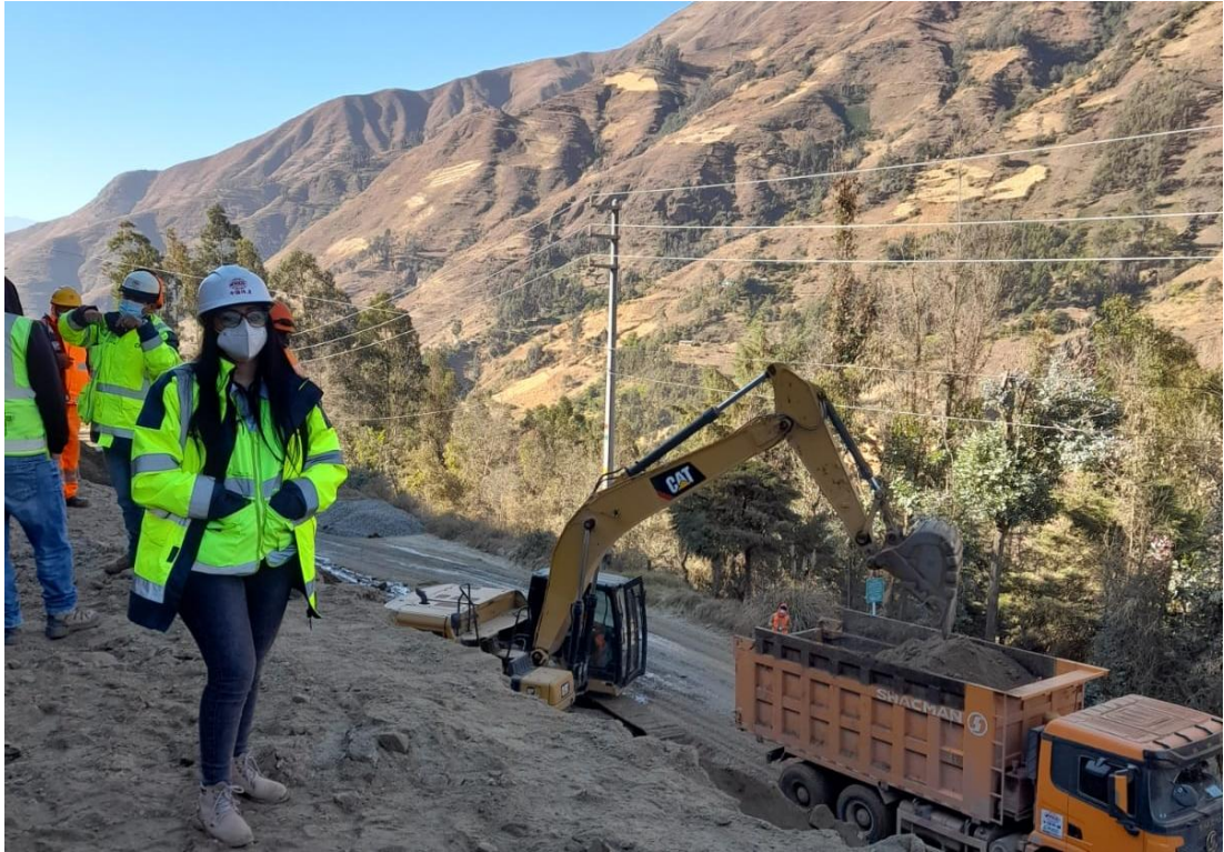
Nota: Supervisión de obra para la carretera Huánuco – La Unión – Antamina
