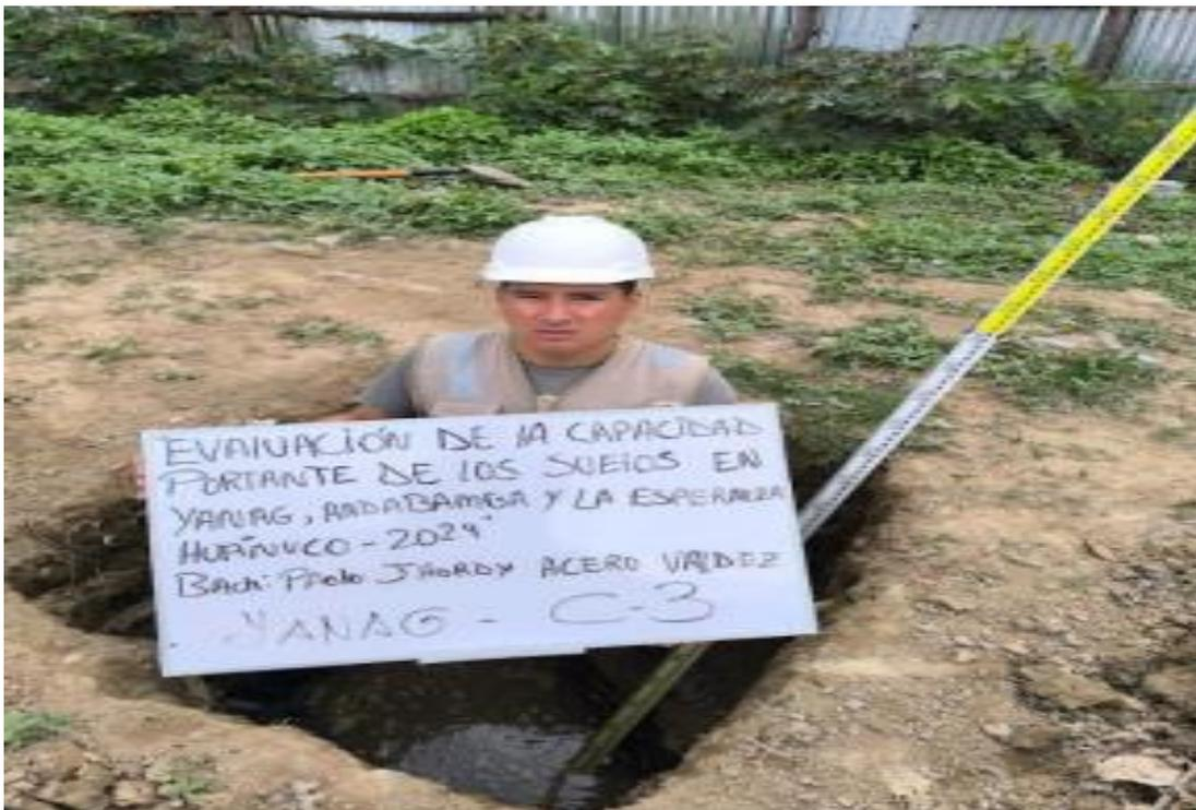
*Nota: Excavación y extracción de la muestra del suelo de la localidad de Yanag C-3 a 2.10 m.*
