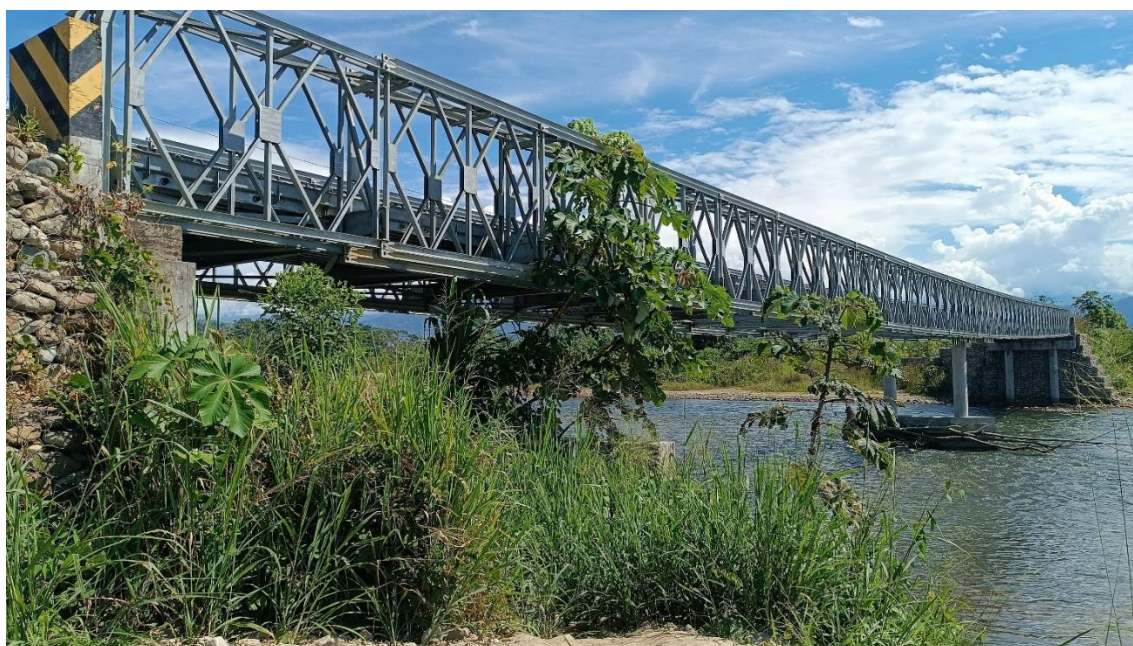
Descripción: Se aprecia el puente existente en el Margen Derecho del Rio Huamuco.
