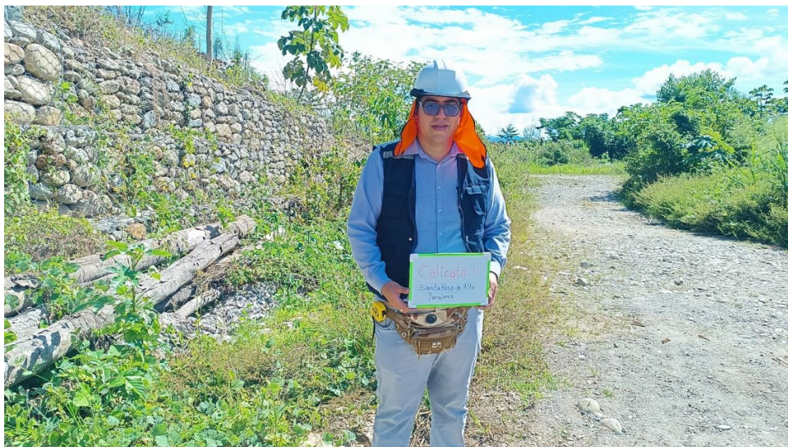
Descripción: Se aprecia la calicata 4 del área a intervenir en el Margen Izquierdo del Rio Huamuco
