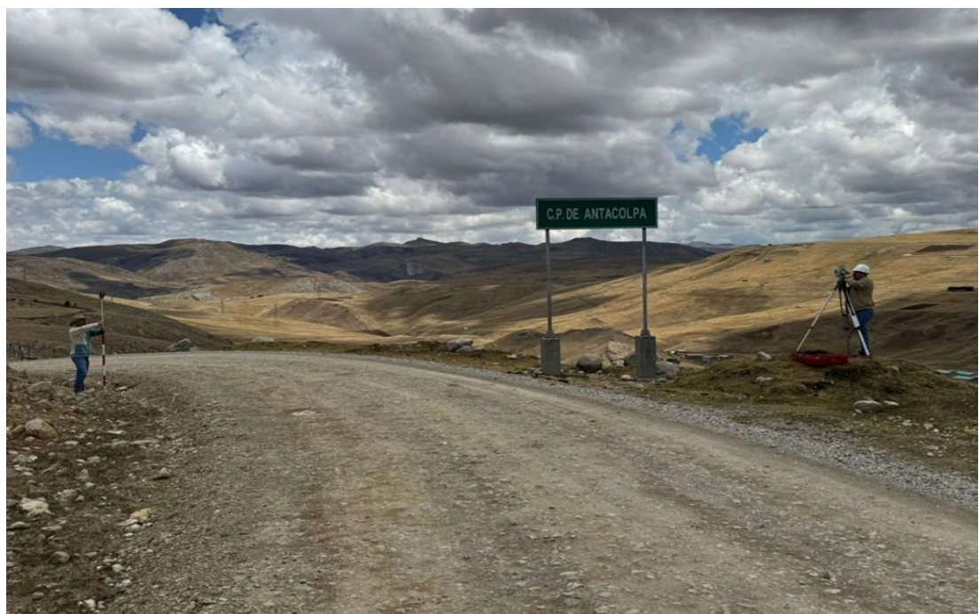
Trabajos topográficos realizados en el inicio del tramo en estudio
