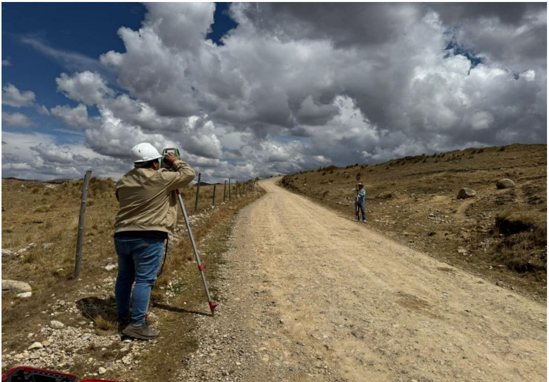
Trabajos topográficos realizados en el km. 01+700
