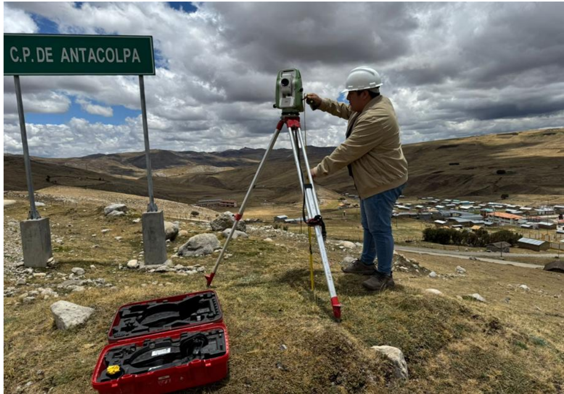
Trabajos previos realizados en el inicio del tramo km. 00+000
