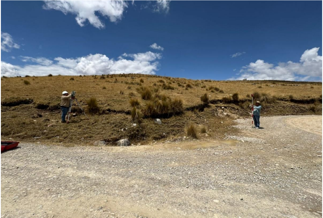
Trabajos topográficos realizados en el km. 07+110
