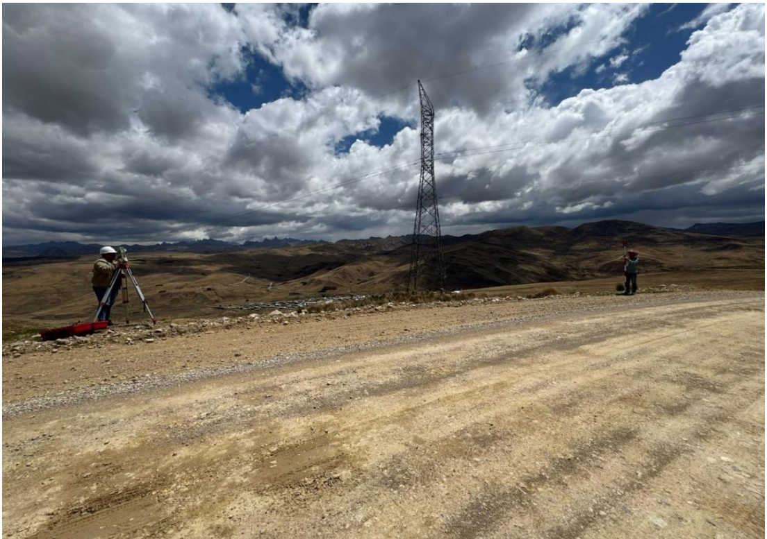
Trabajos topográficos realizados en el km. 06+490
