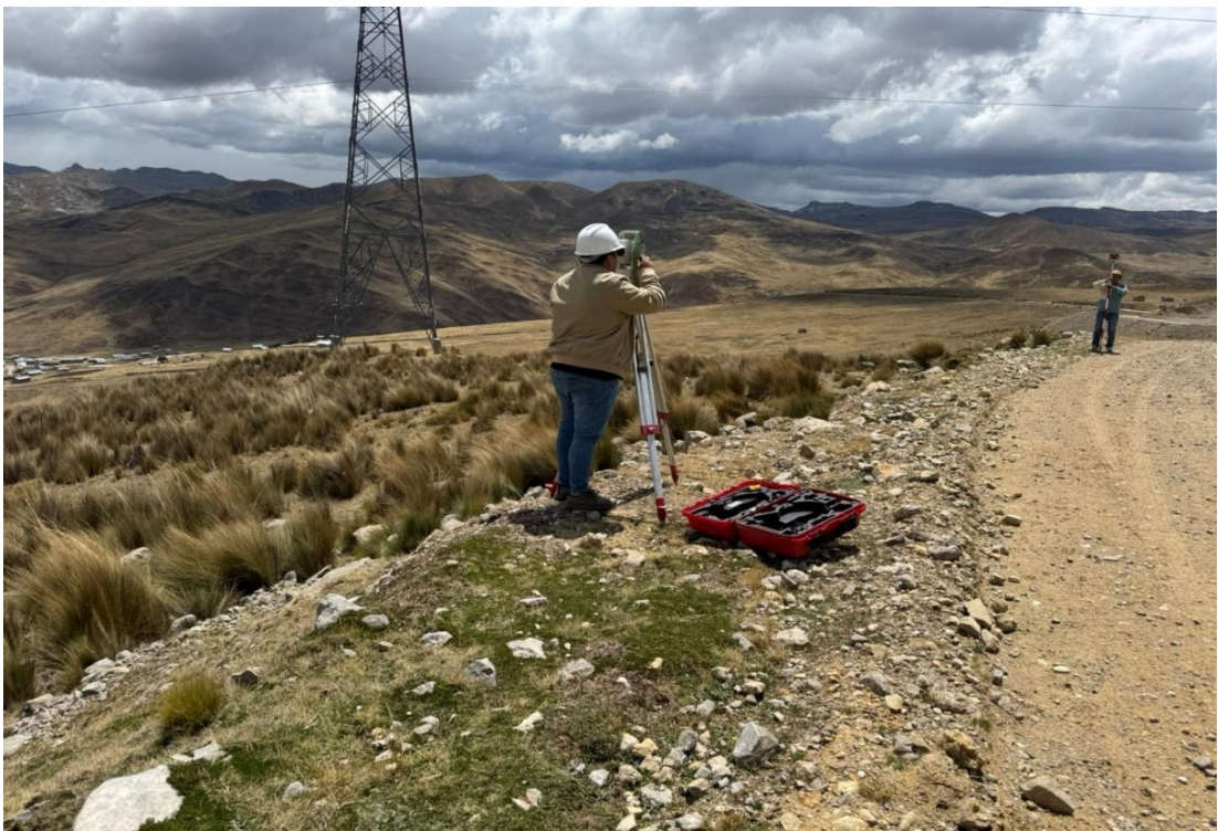
Trabajos topográficos realizados en el km. 05+930
