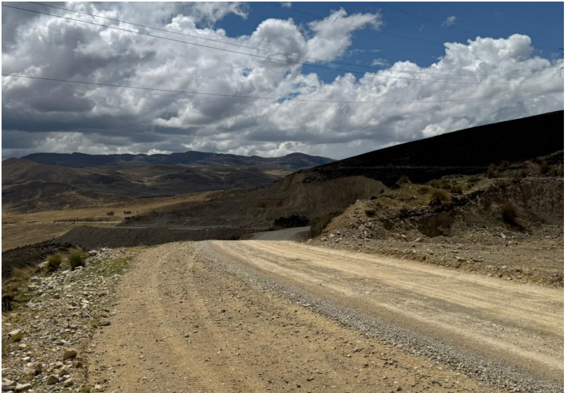
Trabajos topográficos realizados en el km. 04+880
