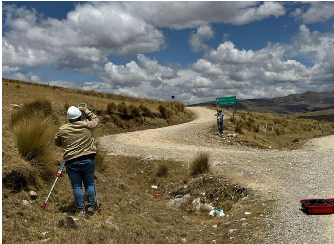
Trabajos topográficos realizados en el km. 00+150
