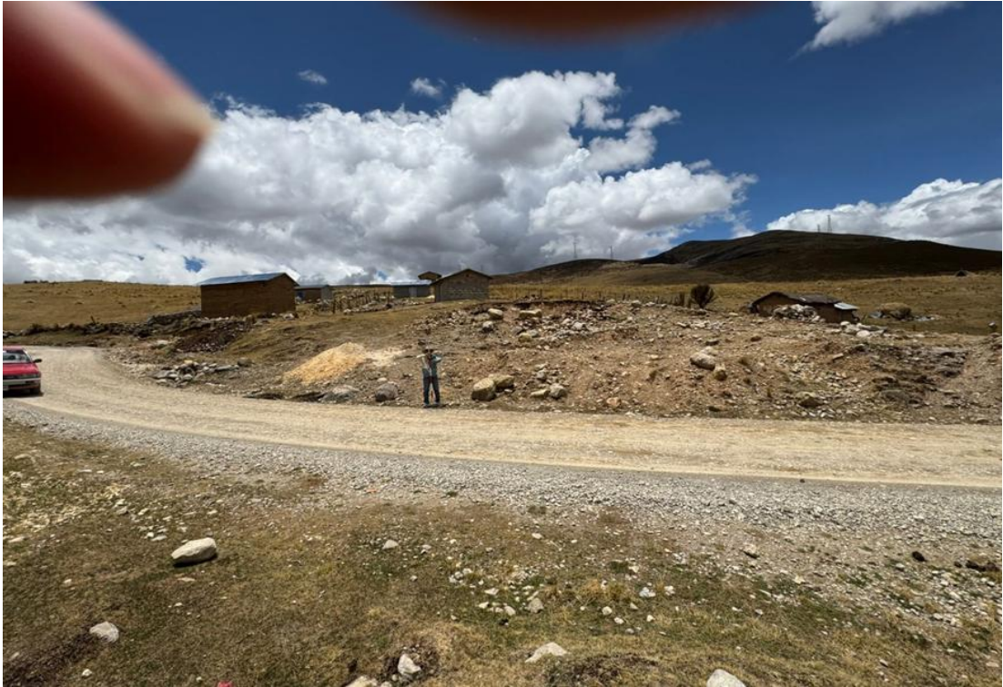
Trabajos topográficos realizados en el km. 08+310
