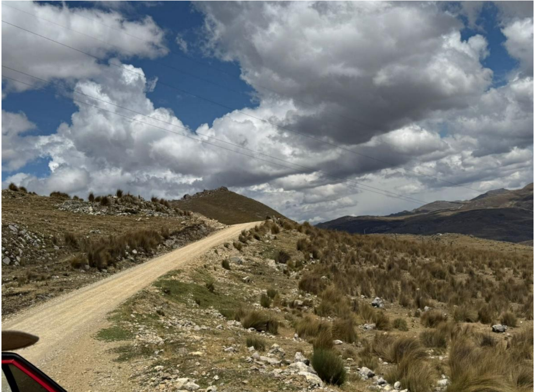
Trabajos topográficos realizados en el km. 06+330
