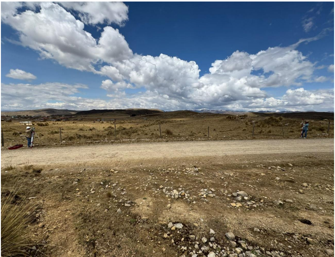
Trabajos topográficos realizados en el km. 01+800
