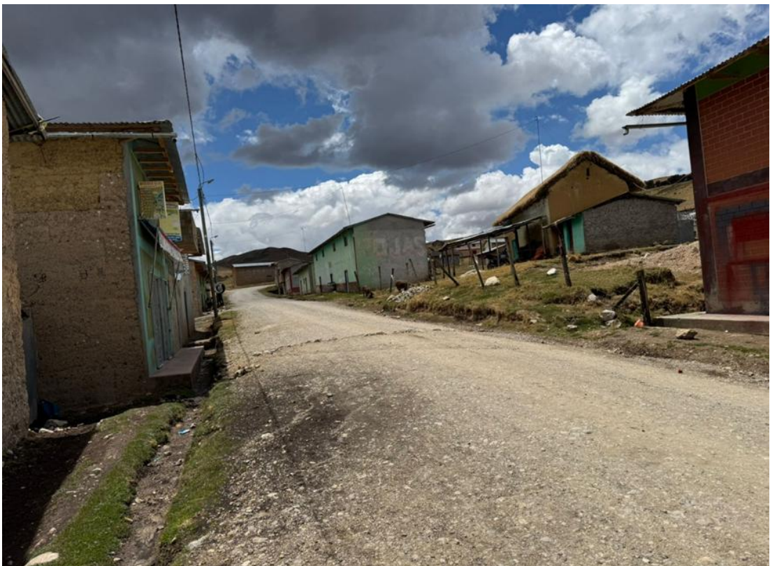
Trabajos topográficos realizados en el km. 09+630
