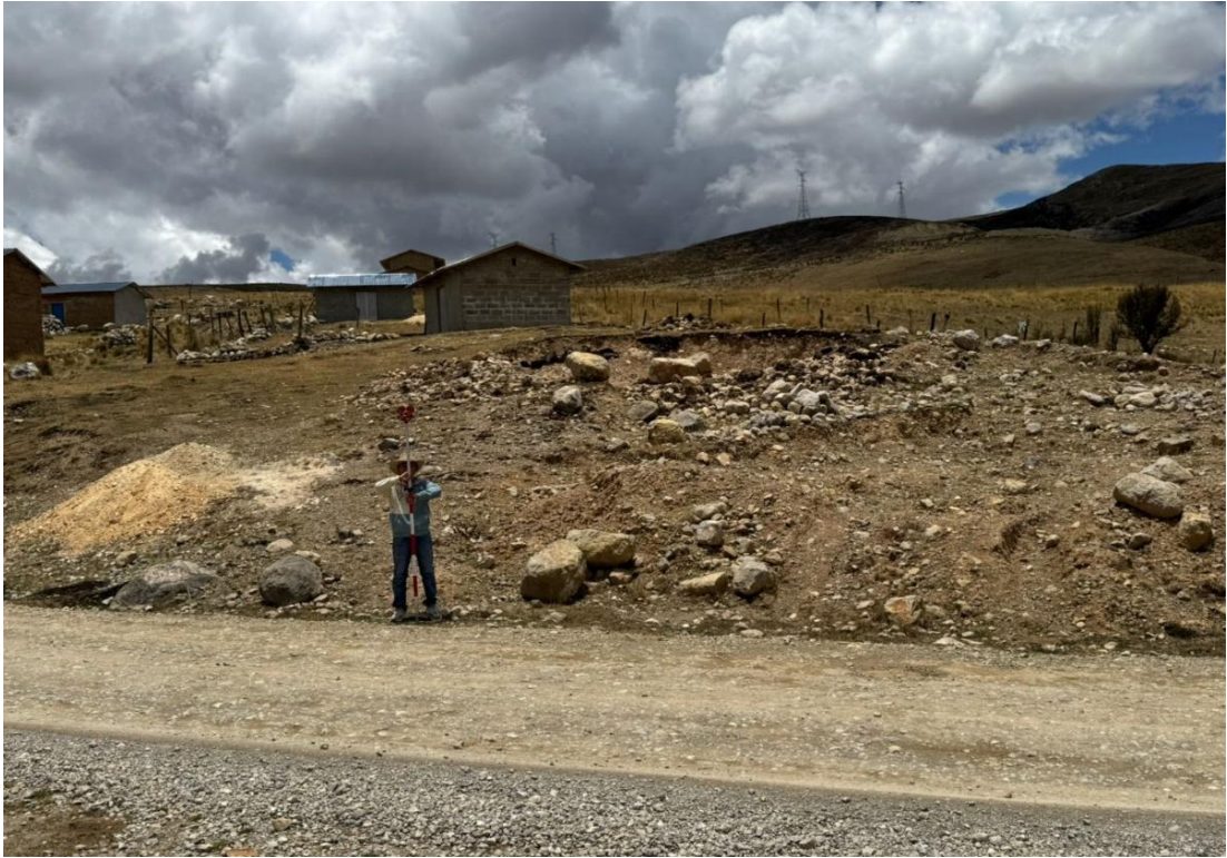
Trabajos topográficos realizados en el km. 09+180
