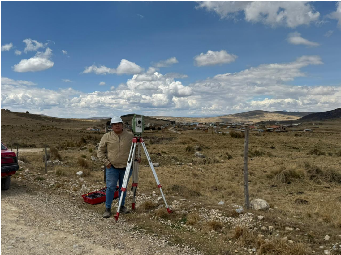
Tesista en los trabajos topográficos realizados en el km. 1+150
