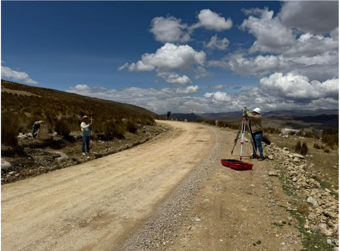
Trabajos topográficos realizados en el km. 04+270
