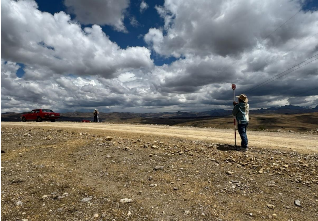
Trabajos topográficos realizados en el km. 05+220
