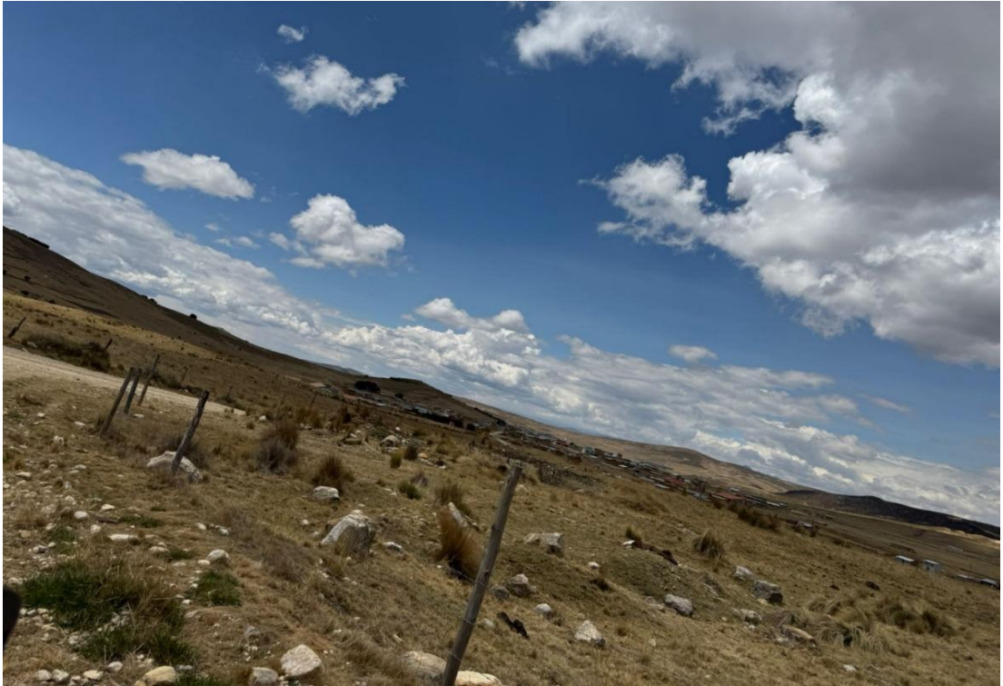
Trabajos topográficos realizados en el km. 02+350
