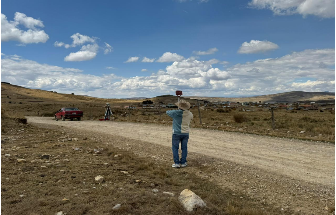
Trabajos topográficos realizados en el km. 01+450
