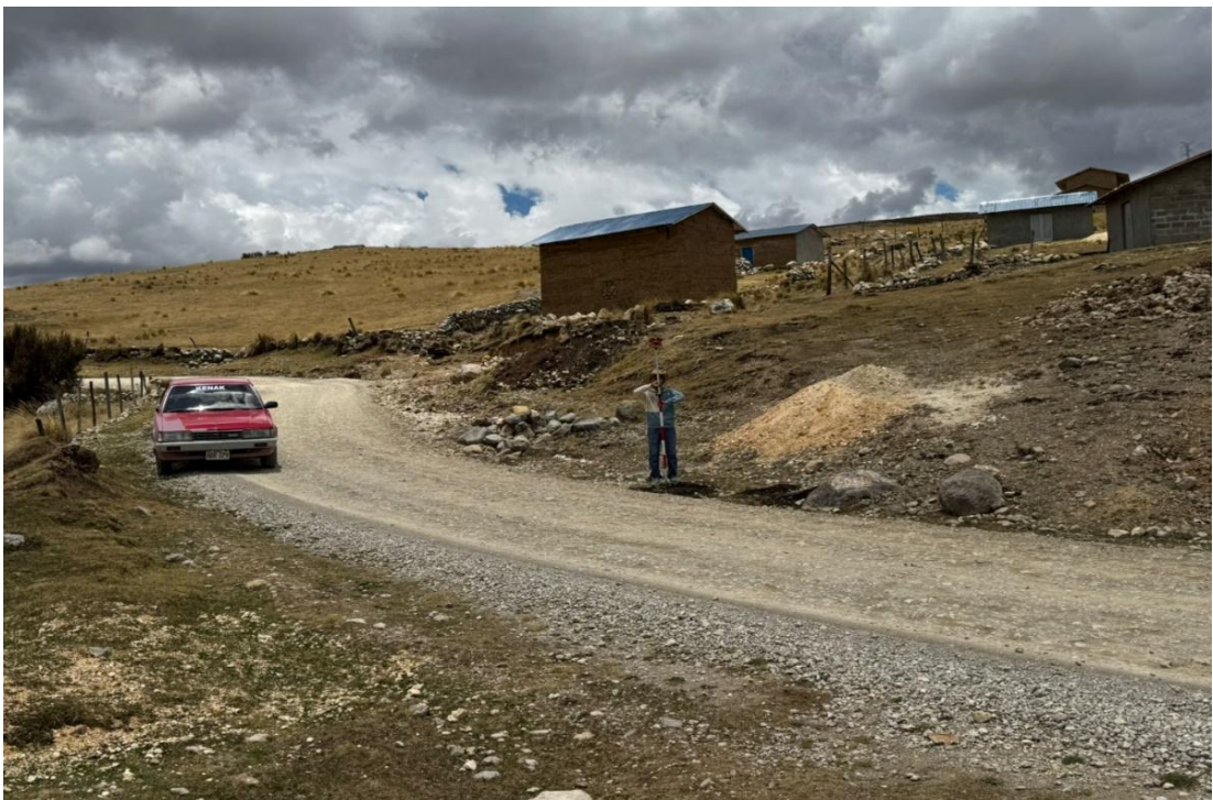
Trabajos topográficos realizados en el km. 08+870
