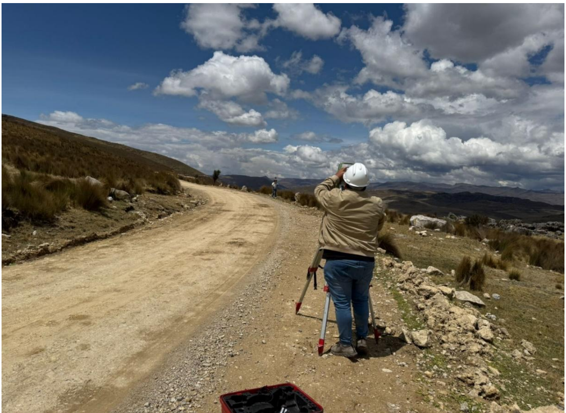
Trabajos topográficos realizados en el km. 03+940
