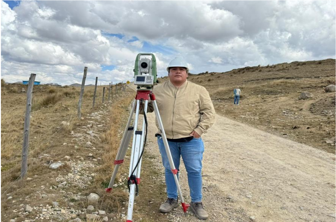
Tesista en los trabajos topográficos realizados en el km. 00+650
