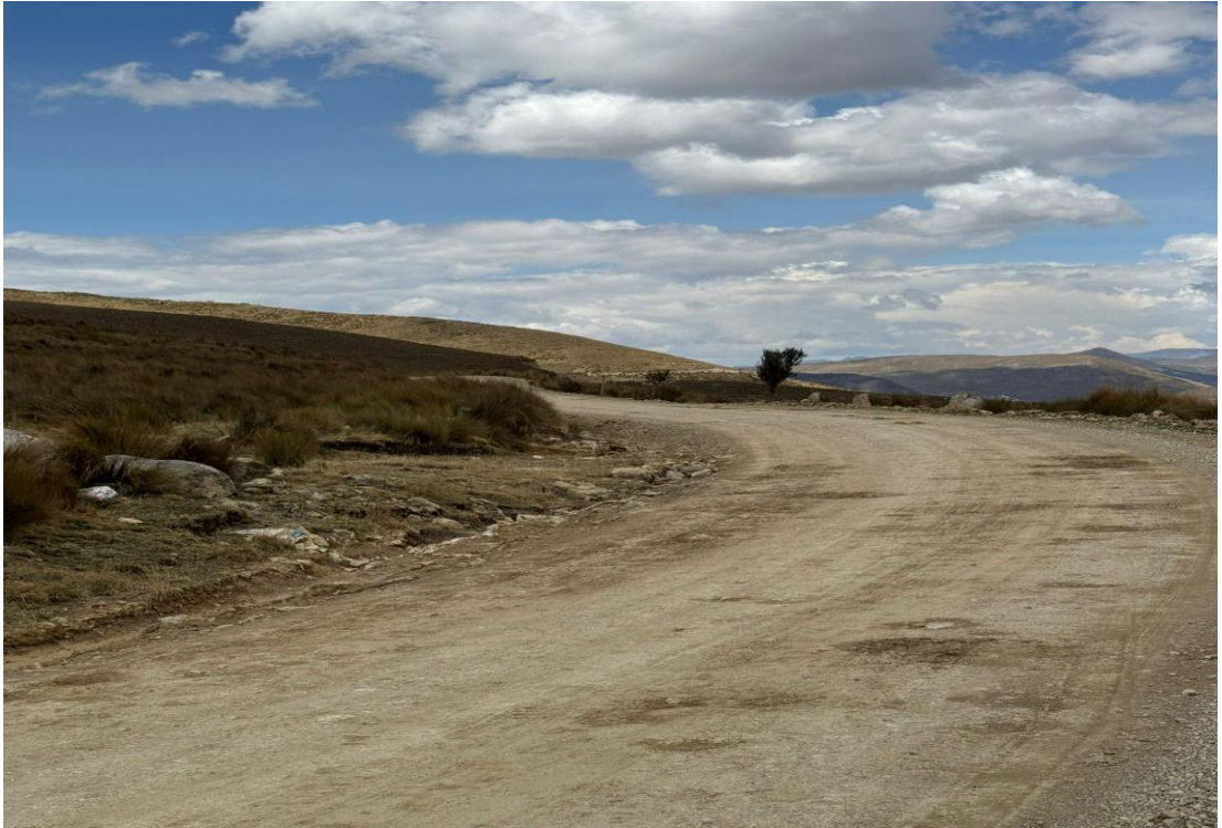
Trabajos topográficos realizados en el km. 02+450
