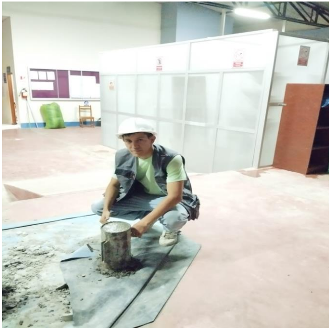
Figura 28 Desencofrado de las probetas luego de fraguado
