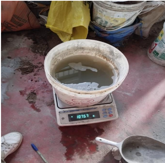
Figura 24 Elaboración de la mezcla de concreto
