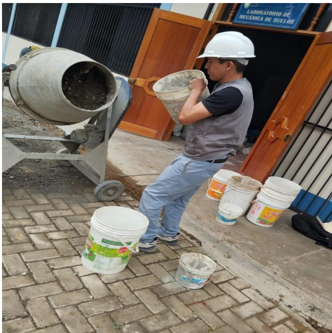
Figura 25 Mezcla de concreto con ayuda del trompo
