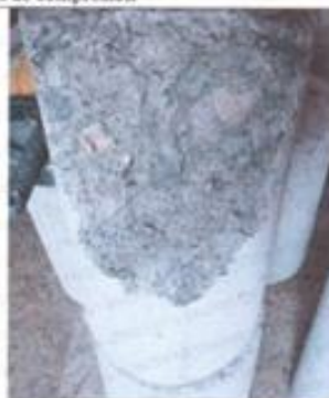
Fig. 2: Tipo de falla de la Muestra 12.
