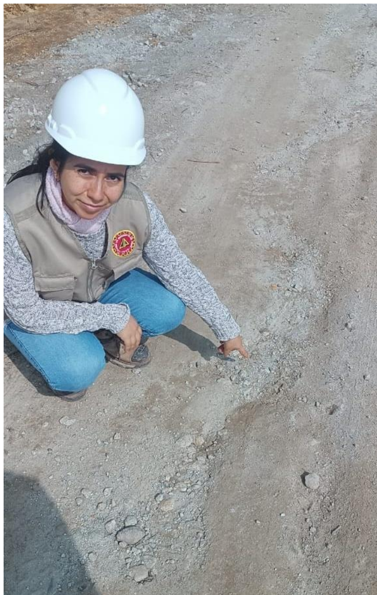
Asentamiento parcial y ondulaciones en la superficie del afirmado – Tramo 1 (EMP HU-899)
