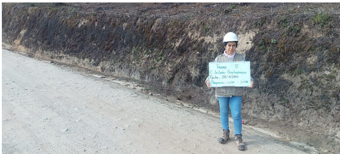
Vestigios de deformaciones superficiales en el afirmado – Tramo 5 (EMP HU-899)
