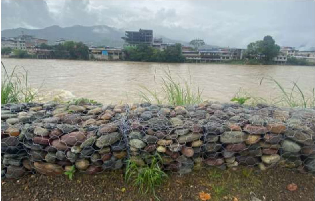
foto de la sección del rio con vista de gaviones.
