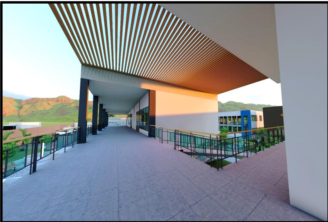
Imagen 50 Vista de área de circulación
