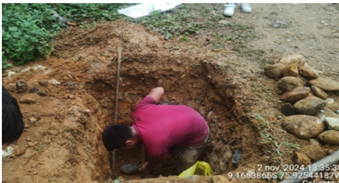
Figura 2 Excavación de calicatas
