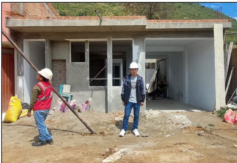
Vivienda N° 02, verificando la estructuración de acuerdo al diseño estructural realizado, en proceso de construcción
