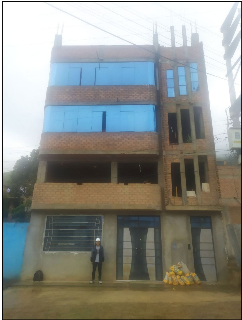
Vivienda N° 01, verificando la estructuración de acuerdo al diseño estructural realizado.
