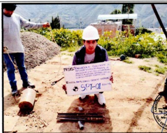
FOTO N°04: Se observa la muestra extraída después del ensayo de 1.50 m a 1.95 m. de profundidad SPT-01.
