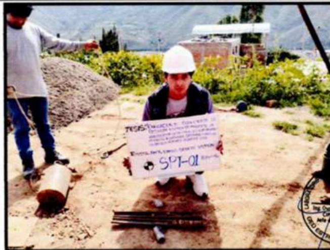
FOTO N°04: Se observa la muestra extraída después del ensayo de 1.50 m a 1.95 m. de profundidad SPT-01.
