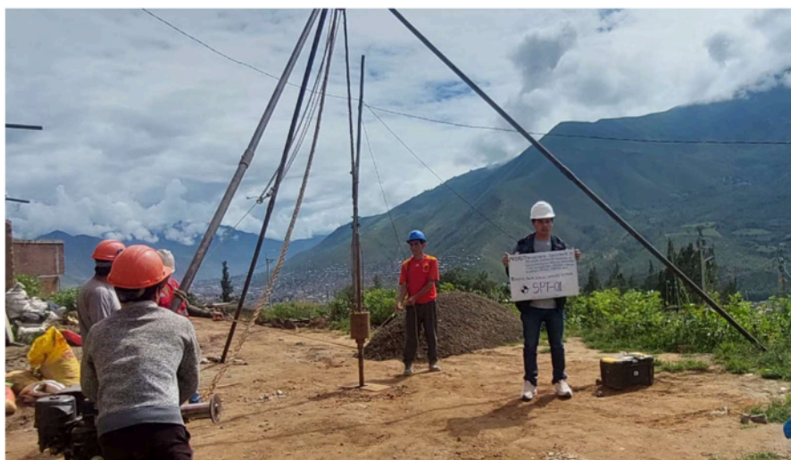
Proceso del ensayo SPT, para la obtención de los parámetros sísmicos
