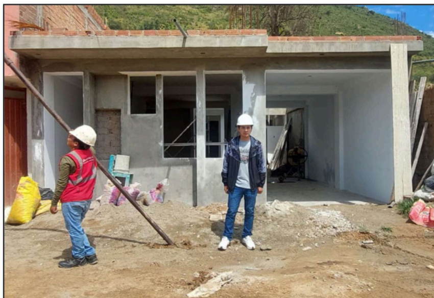
Vivienda N° 02, verificando la estructuración de acuerdo al diseño estructural realizado, en proceso de construcción
