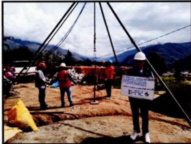
FOTO N°03: Vista panorámica de la exploración a base de ensayo en campo SPT-01.
