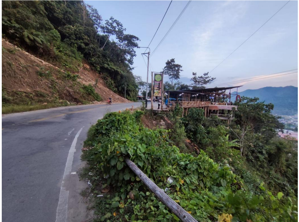
Fotografía 3 Viviendas de alto riesgo
