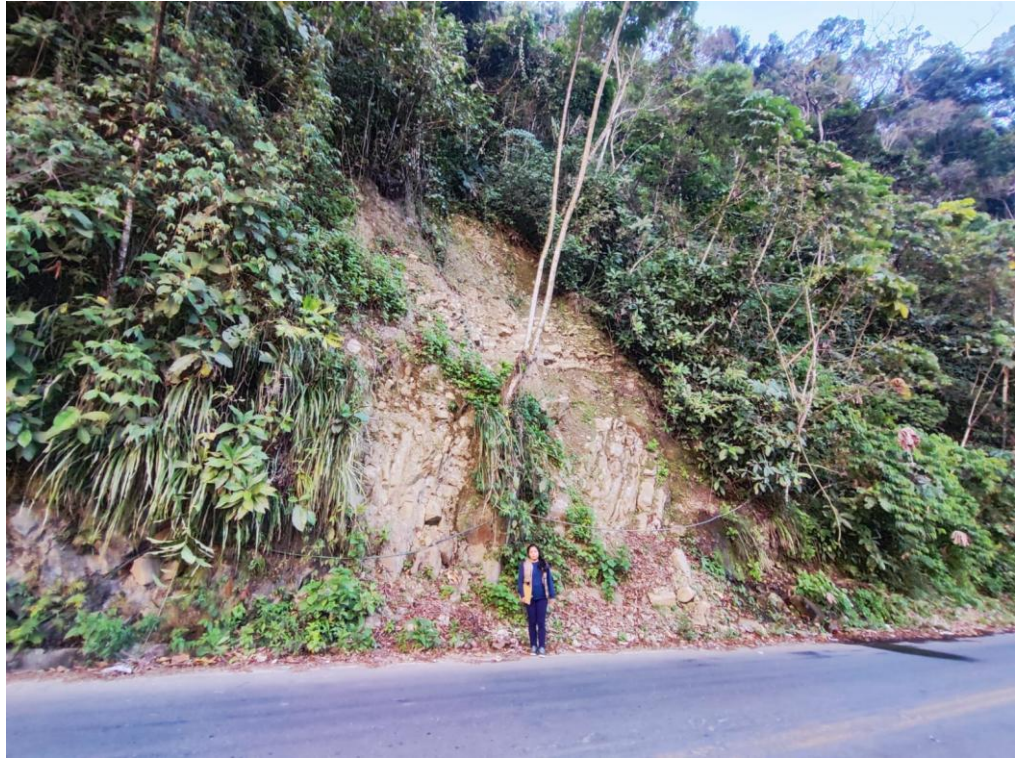
Fotografía 7 Deslizamientos de rocas por lluvias
