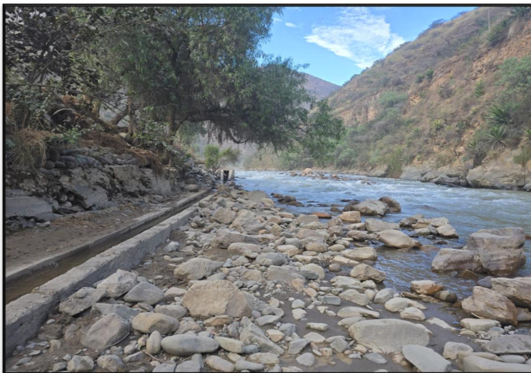
En la vista fotográfica se muestra en encausamiento del rio, menorando la sección del rio
