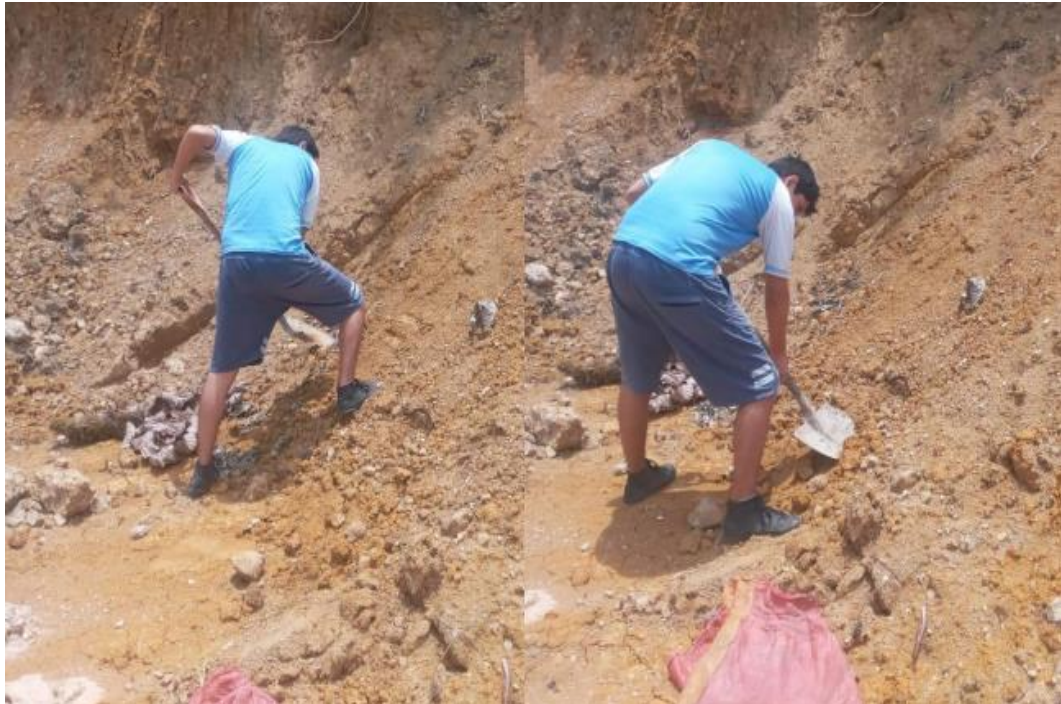
Figura 10 Extracción y almacenado del material (arcilla y limo)
