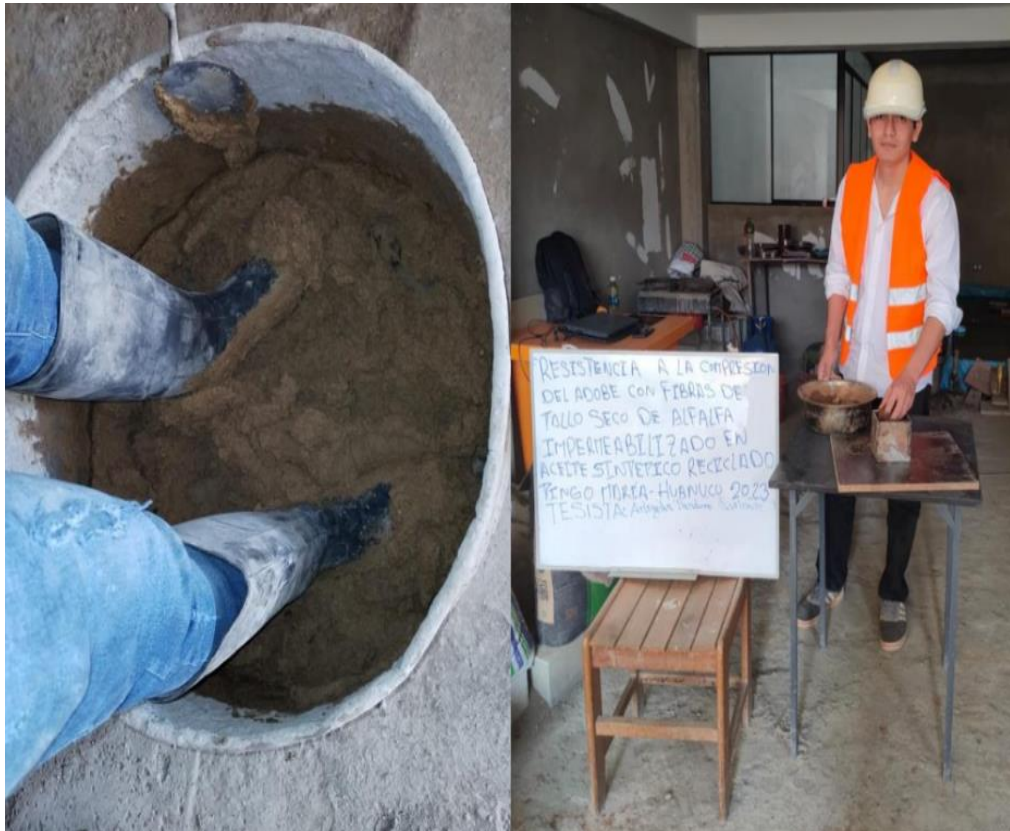
Figura 25 Mezclado en húmedo y elaboración de los bloques
