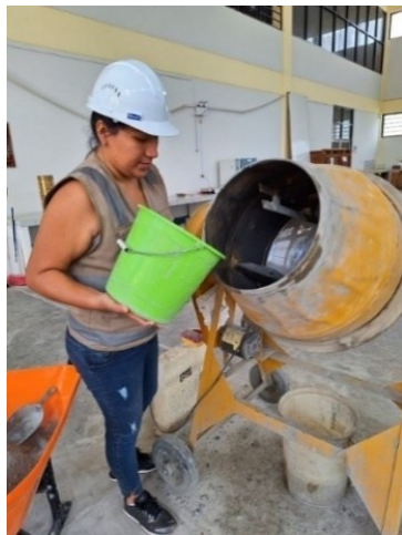
Figura 26 Preparación de la mezcla con el trompito
