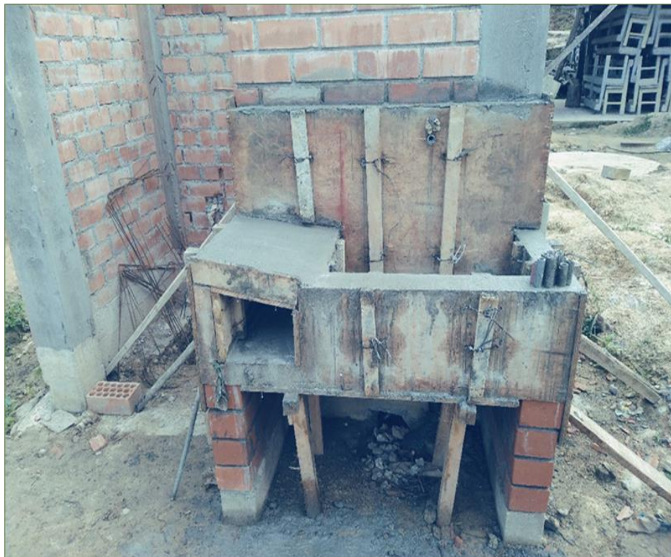
Se observa los trabajos compuestos por mampostería de ladrillo y una losa de concreto colado en sitio con encofrado de madera.
