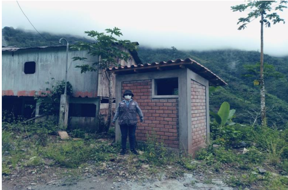
Se observa los trabajos de Muro de Soga Ladrillo KING KONG 18 Huecos Caravista exterior - mezcla 1:5 en lado posterior.
