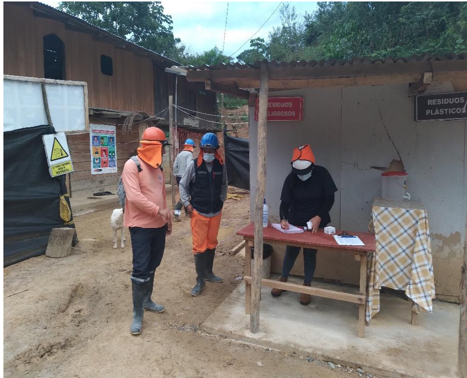
Se observa los trabajos de inicio de Obra Prevención del Covid-19.
