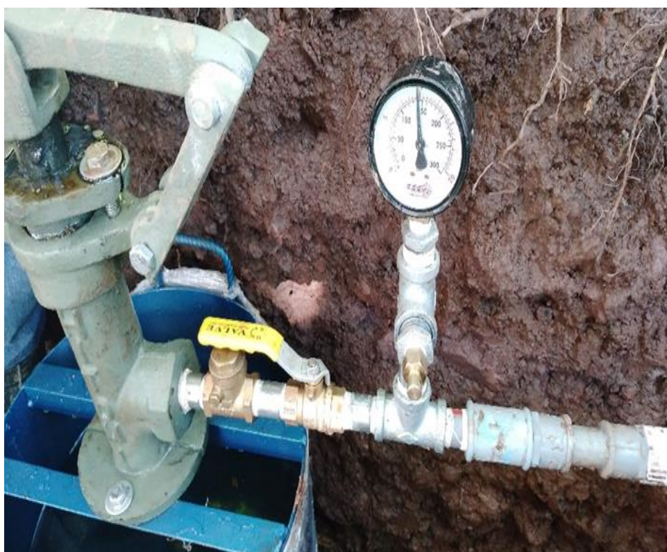
Se observa los trabajos de Cumpliendo La Prueba Hidráulica+ desinfección Tub.25 Mm - 75 Mm. Zanja Tapada.
