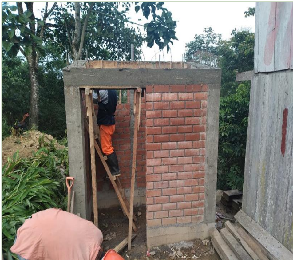
Se observa los trabajos de Encofrado y Desencofrado de Vigas en UBS.
