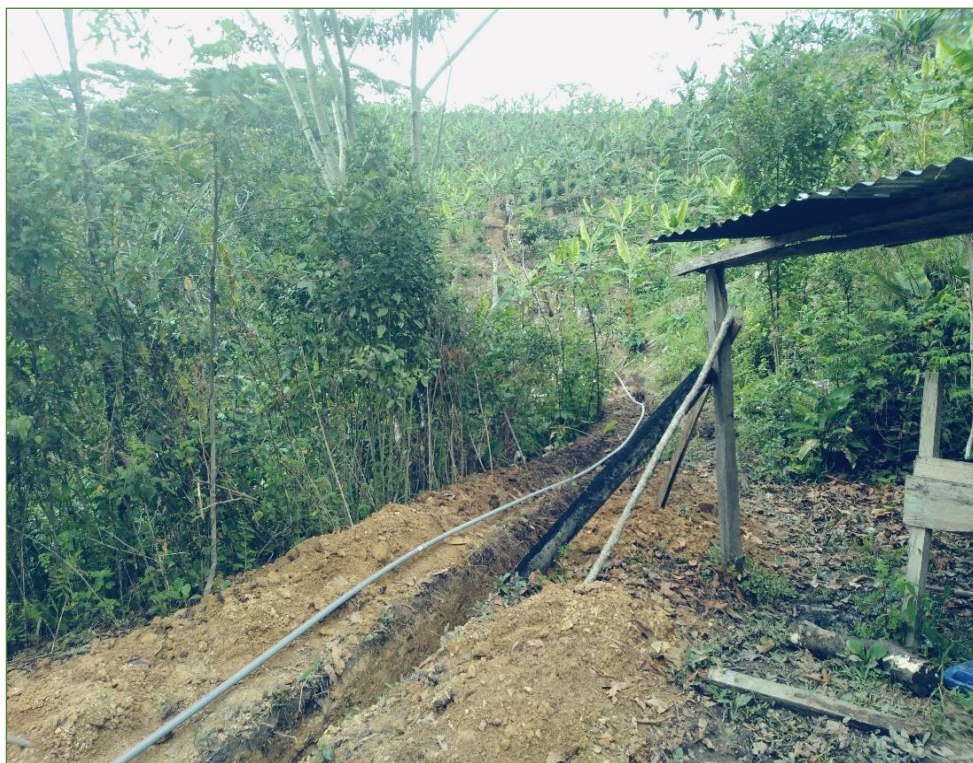
Se observa los trabajos de Excavación y tendido de tubería en el sistema 10.
