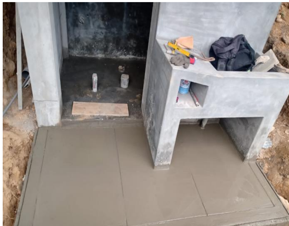
Se observa los trabajos de Concreto en F'C = 140 \text{ KG/CM}^2 en veredas de UBS.
