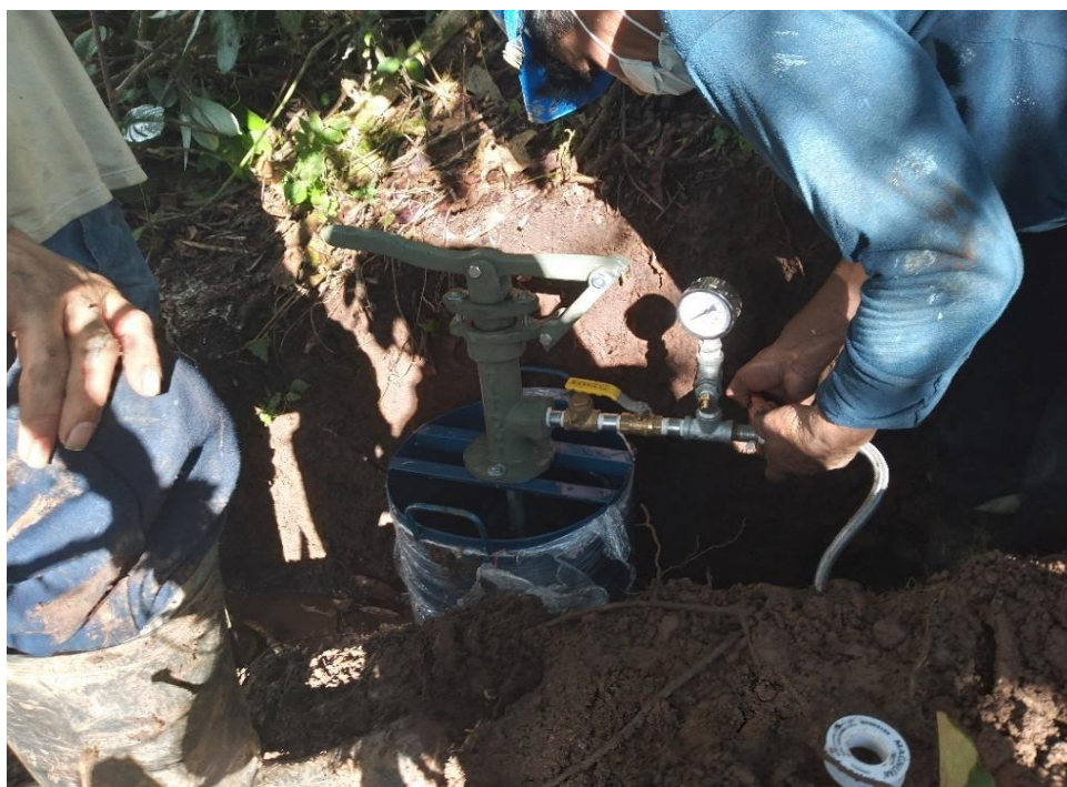
Se observa los trabajos de Instalación del Balde Hidráulico en el Sistema 10.
