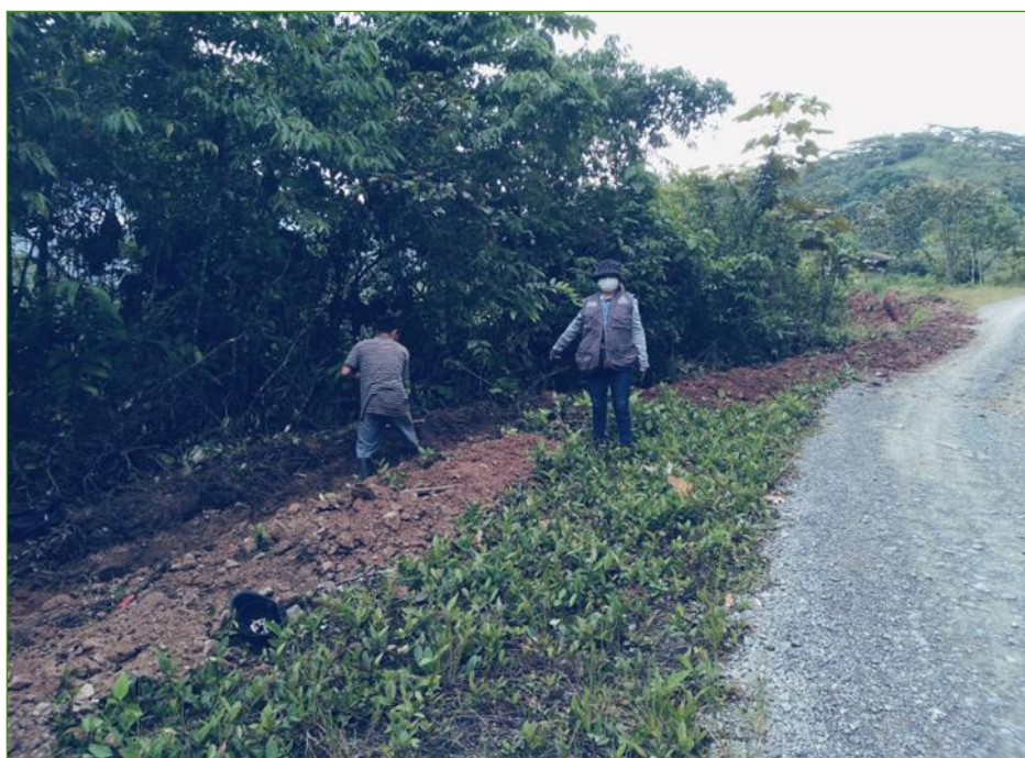
Se observa los trabajos de Zarandeado de material propio, para cama de apoyo en el Sistema número 4.
