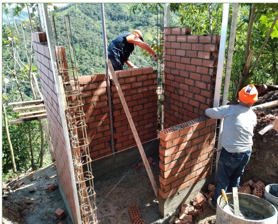
Se observa los Trabajos de asentado de ladrillo en caravista en UBS.
