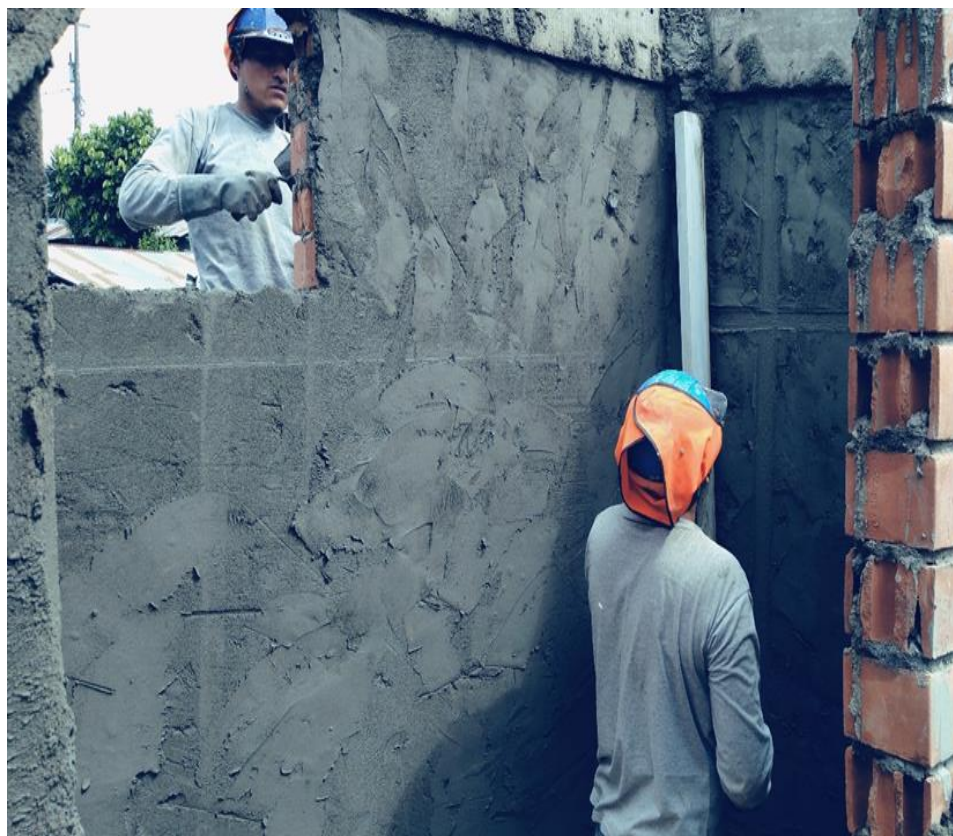
Se observa los trabajos de tarrajeos y vestiduras con Cemento C: A=1:5, e =1.5 cm.
