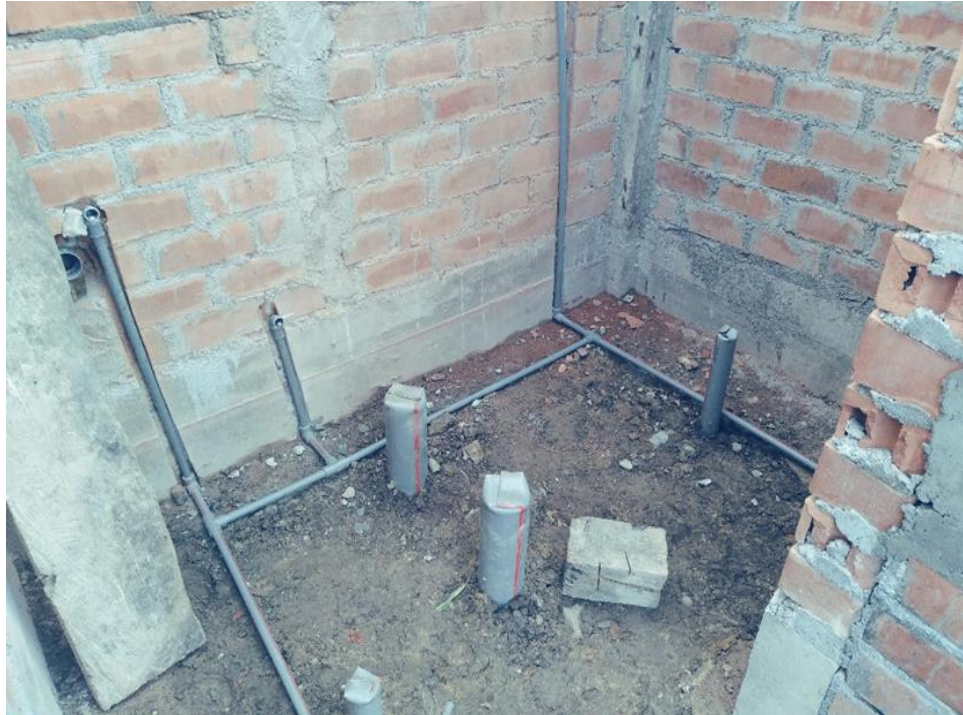
Se observa los trabajos de Suministro e Instalación de Tubería PVC SAP \varnothing 1/2" CL-10.
