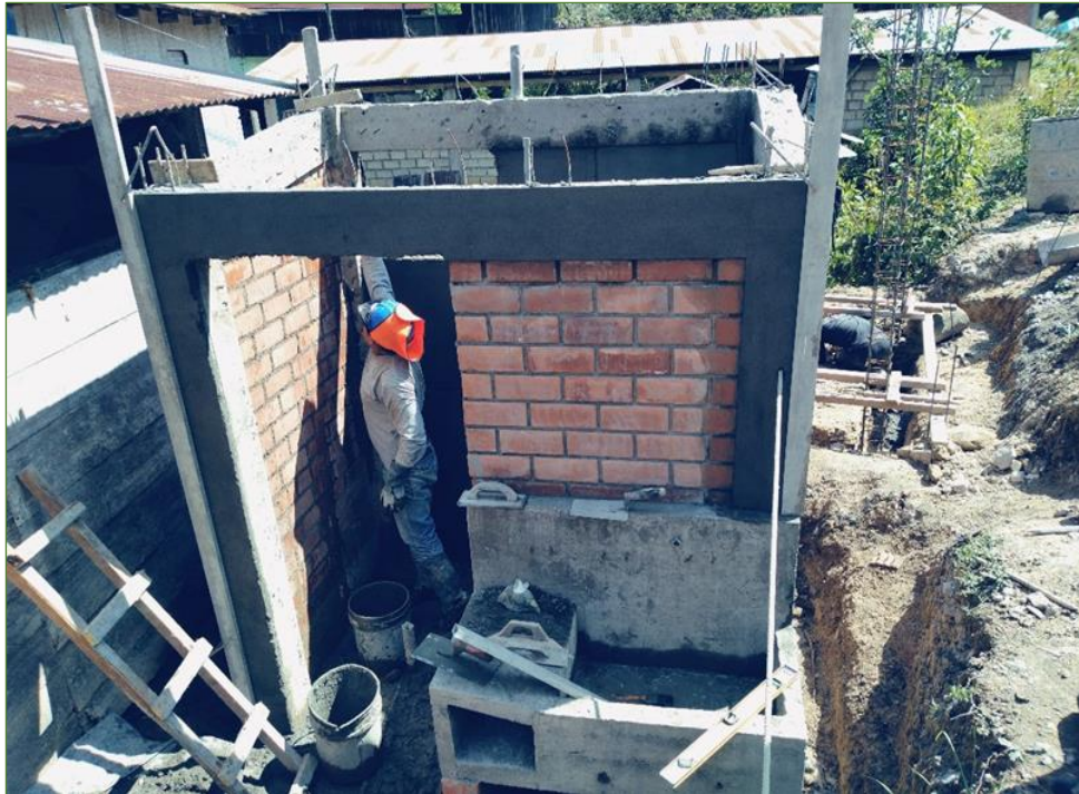
Se observa los trabajos de vestidura y derrame en vigas.
