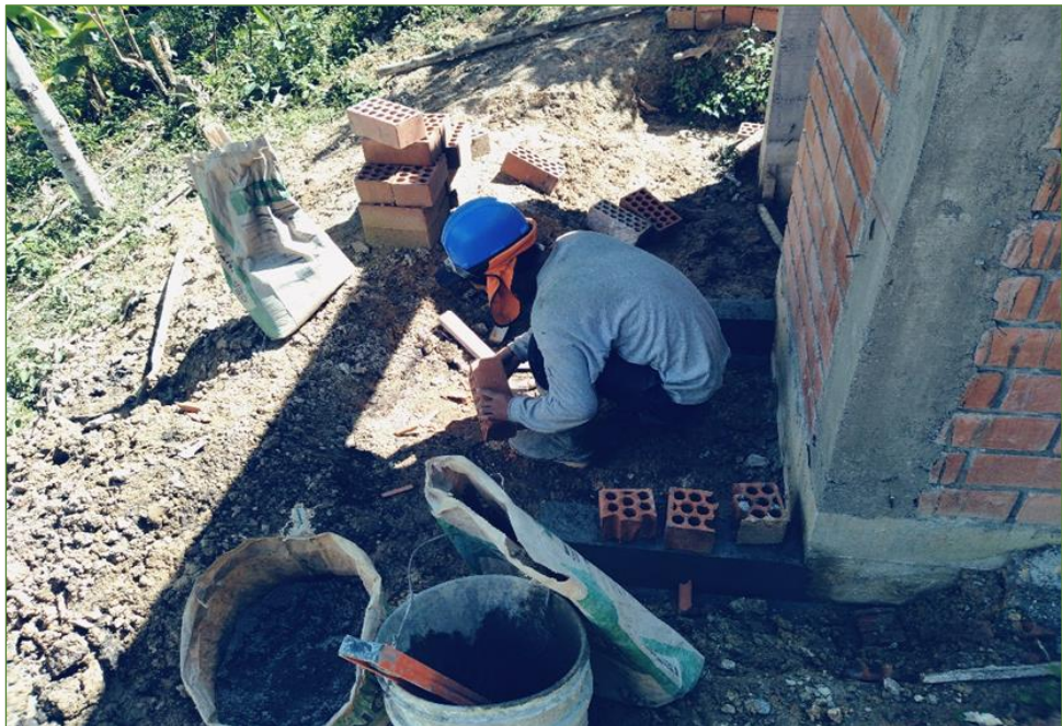
Se observa los trabajos de Muro de saga ladrillo KING KONG 18 huecos caravista exterior - mezcla 1:5 para lavadero.
