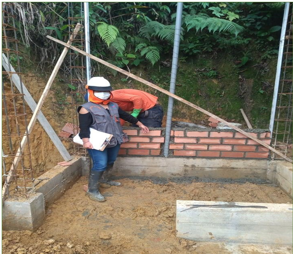
Se observa los trabajos asentados en Muro de Soga Ladrillo King Kong 18 Huecos Caravista Exterior - Mezcla 1:5 para Muro de UBS.
