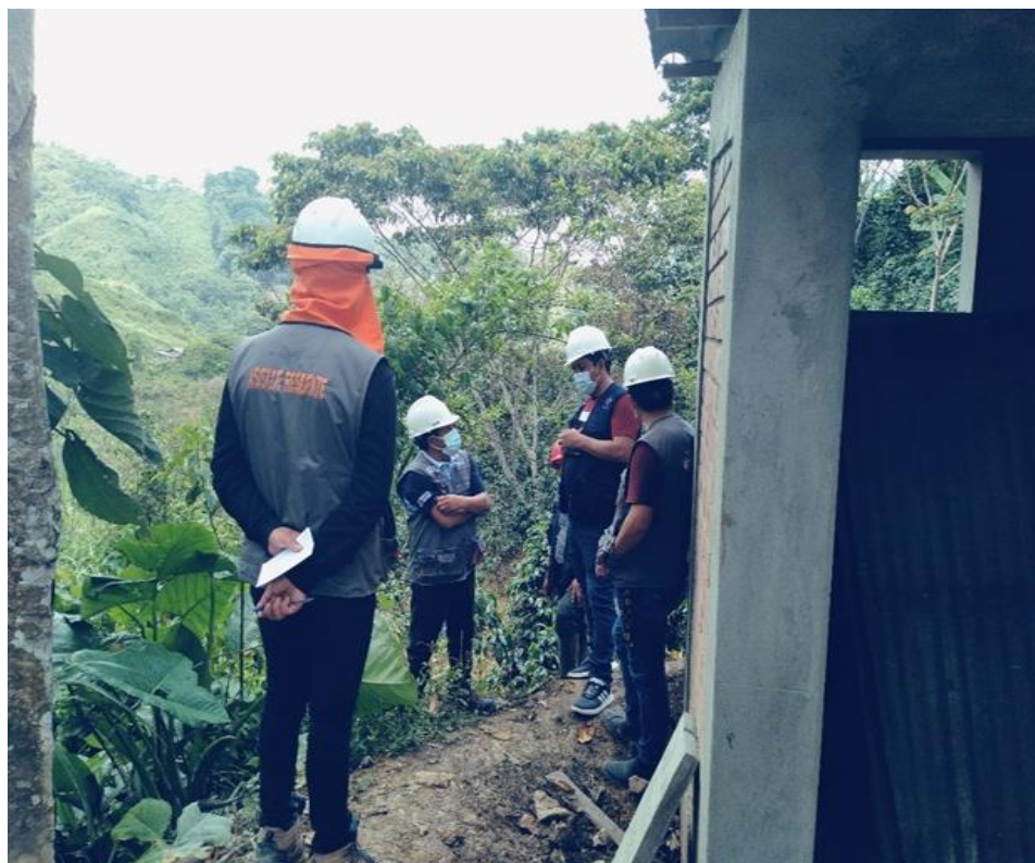
Se observa los trabajos de Inspección y coordinación con los responsables con el plan técnico.
