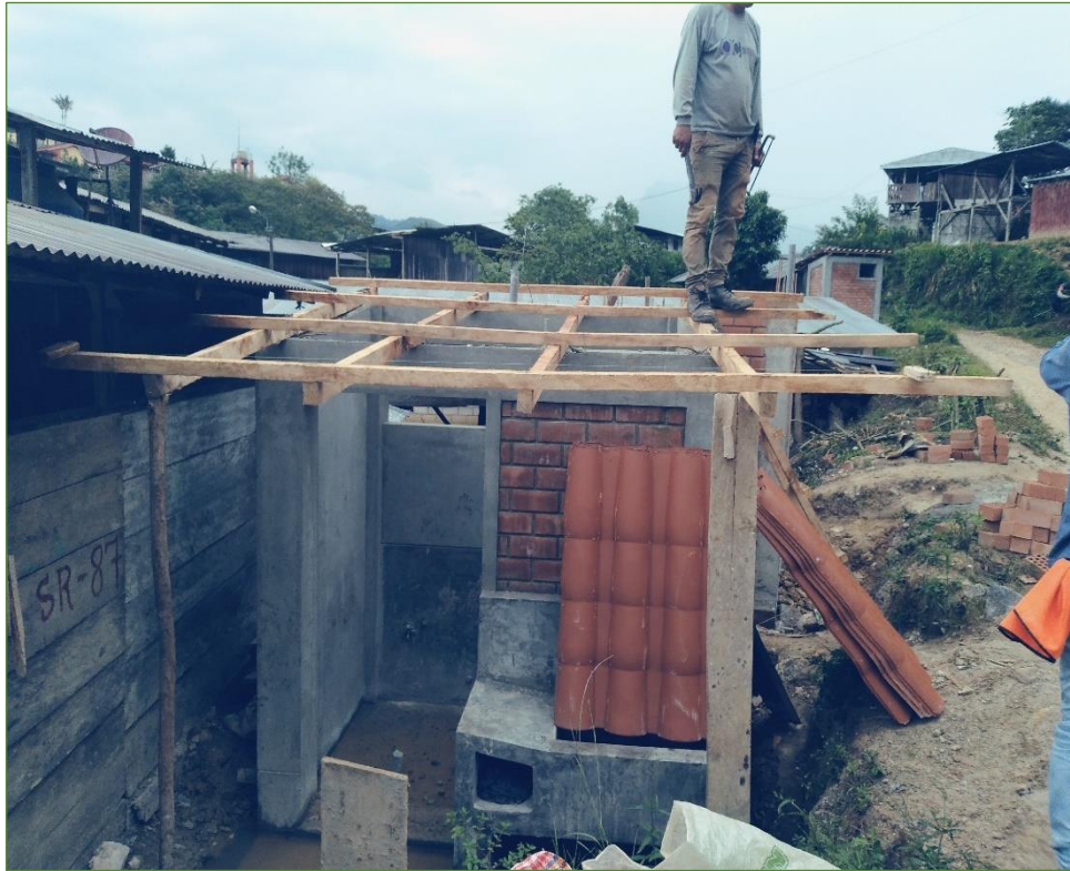
Se observa los trabajos de Colocación de Correas de Madera en la Zona 2"X2"X10'De UBS.
