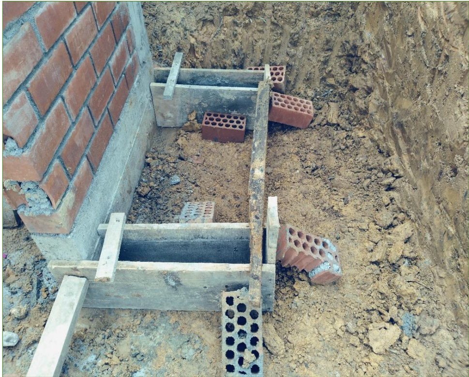
Se observa los trabajos de Encofrado y Desencofrado de Sobrecimientos de los Lavaderos.
