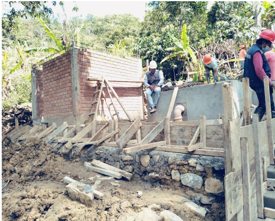
Se observa los trabajos de Concreto F'C = 210 \text{ Kg/Cm}^2 en Vigas Para Caseta de Guardianía.
