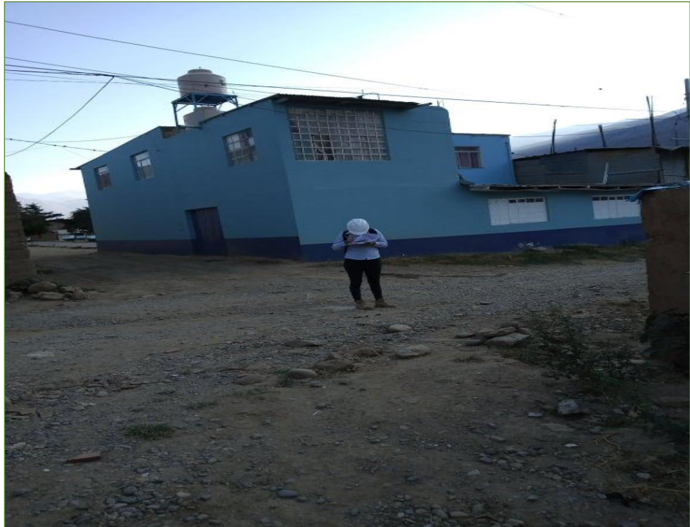
Se observa los trabajos de Patrón de Registro en Conexiones Domiciliarias A los Beneficiarios.
