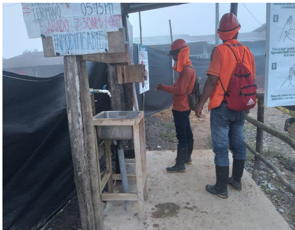
Se observa los trabajos de lavado de manos para el Plan COVID-19 a inicio de jornada.
