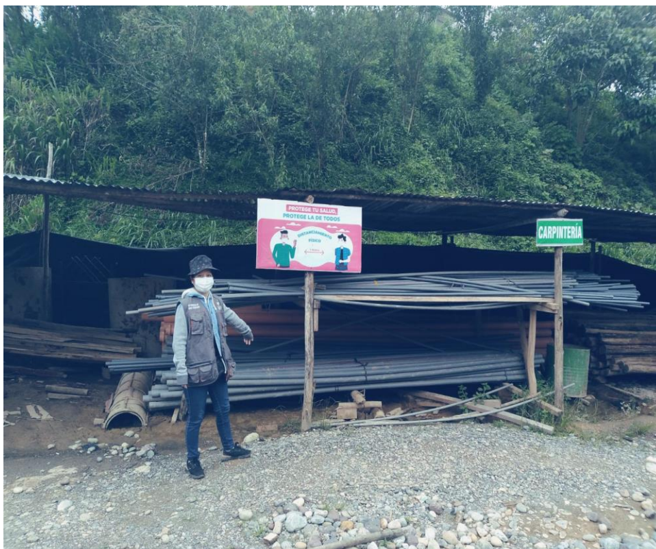
Se observa trabajos de Almacenamiento para ferrería para trabajos de acero.
