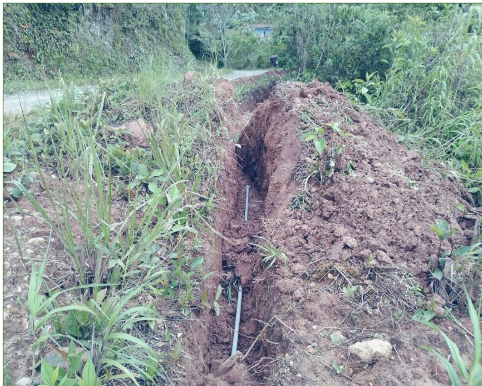
Se observa los trabajos de Excavación y tendido de tubería en el sistema Nº11.
