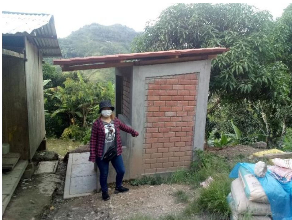
Se observa los trabajos asentados en Muro de Soga Ladrillo King Kong 18 Huecos Caravista Exterior - Mezcla 1:5 para Muro de UBS 20.
