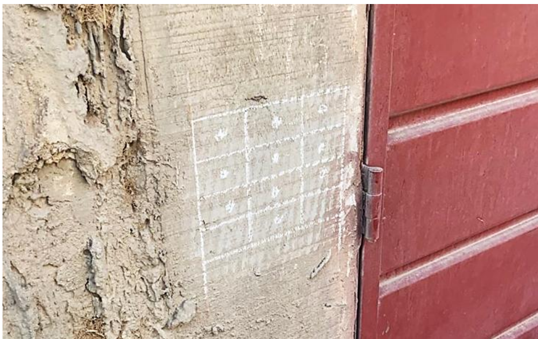
FOTOGRAFÍA N° 07: Trazo de cuadrícula en columna para tomas de datos, perteneciente a la vivienda ubicado en el Jirón Ricardo Palma N° 266.
