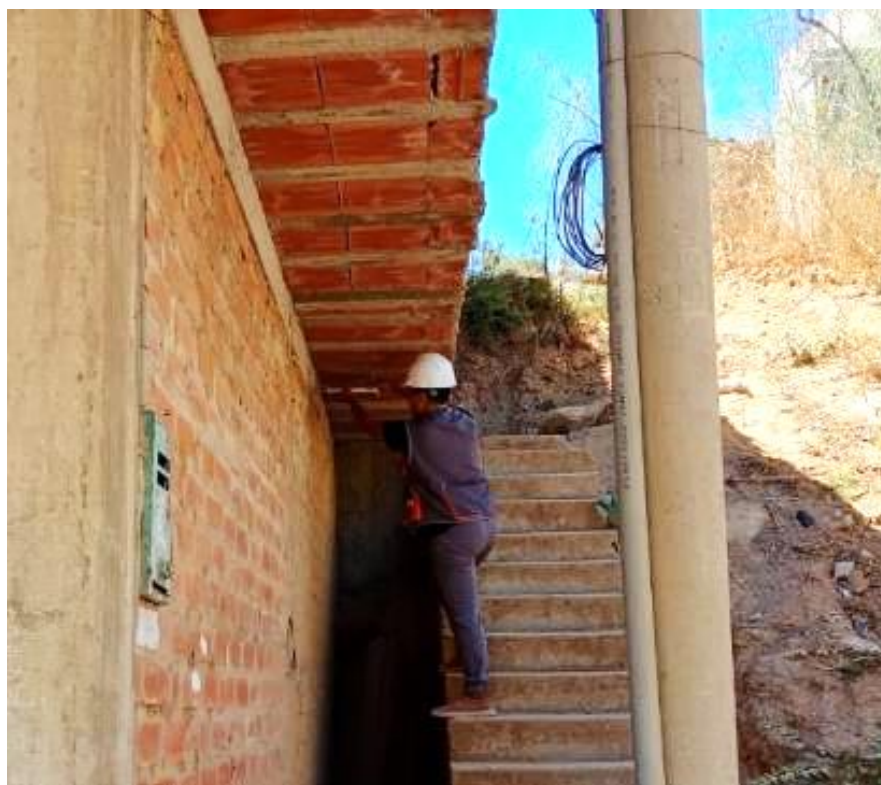
FOTOGRAFÍA N° 12: Ensayo de esclerometría en viga, perteneciente a la vivienda ubicado en el Jirón Ricardo Palma N° 454.
