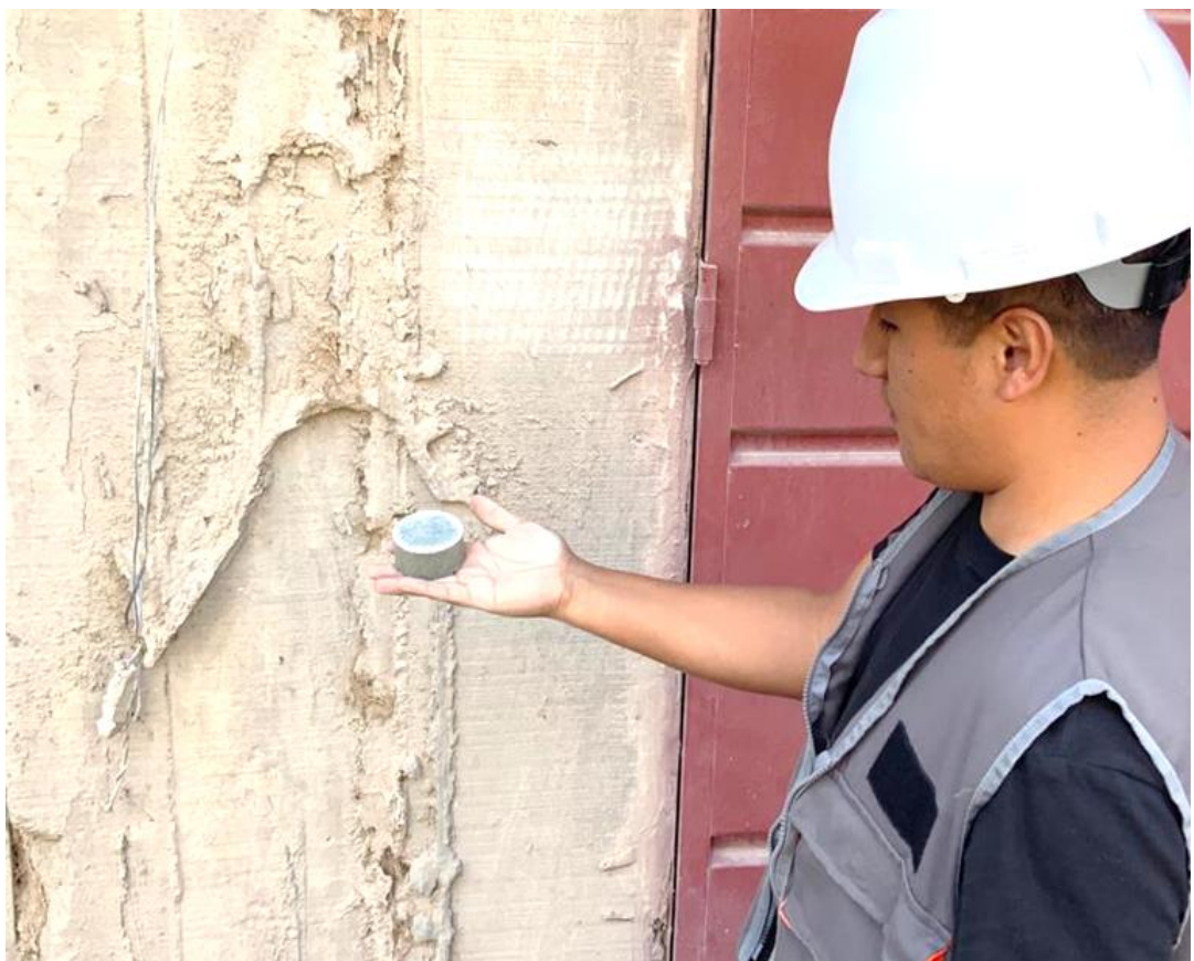
FOTOGRAFÍA N° 06: Pulido del área a intervenir con piedra abrasiva. perteneciente a la vivienda ubicado en el Jirón Ricardo Palma N° 266.
