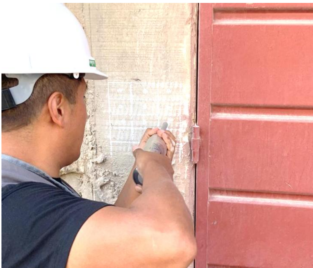
FOTOGRAFÍA N° 08: Ensayo de esclerometría en columna, perteneciente a la vivienda ubicado en el Jirón Ricardo Palma N° 266.
