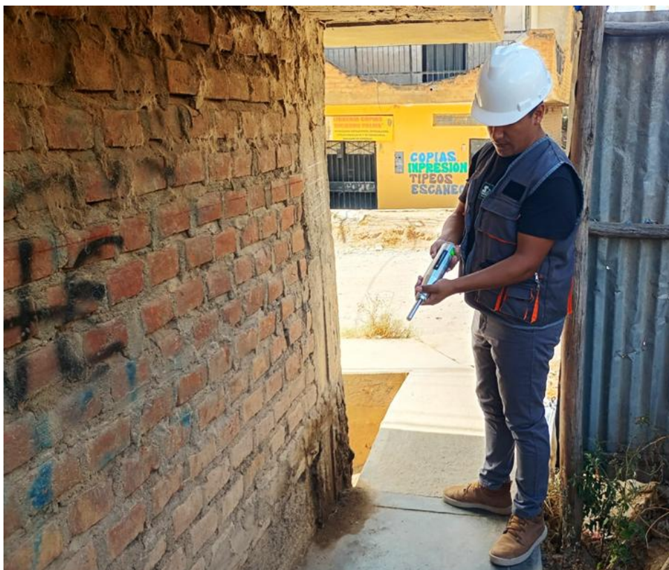
FOTOGRAFÍA N° 13: Ensayo de esclerometría en columna, perteneciente a la vivienda ubicado en el Jirón Ricardo Palma N° 286.
