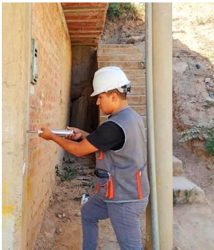
FOTOGRAFÍA N° 11: Ensayo de esclerometría en columna, perteneciente a la vivienda ubicado en el Jirón Ricardo Palma N° 454.
