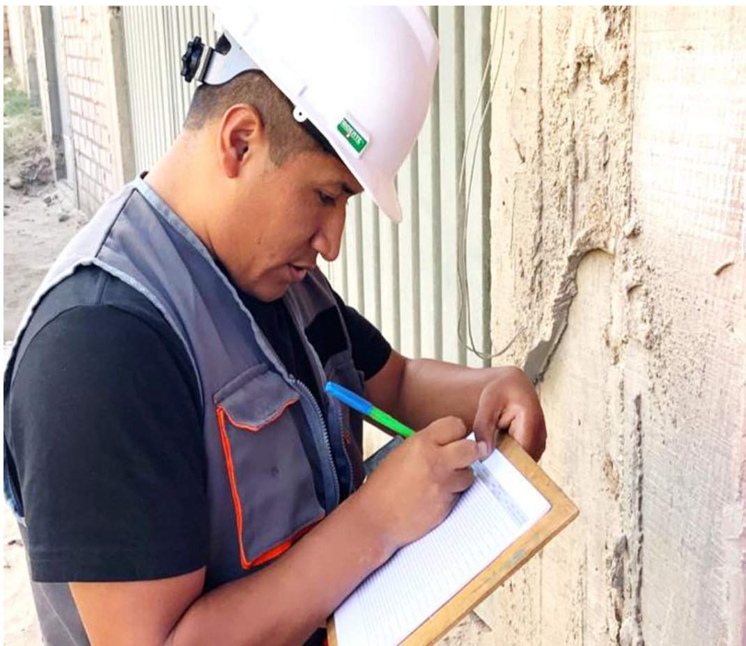
FOTOGRAFÍA N° 09: toma de lectura del equipo esclerómetro, perteneciente a la vivienda ubicado en el Jirón Ricardo Palma N° 266.
