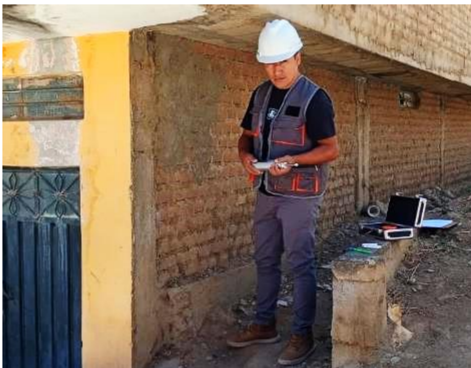
FOTOGRAFÍA N° 14: Ensayo de esclerometría en columna, perteneciente a la vivienda ubicado en el Jirón Ricardo Palma N° 296.
