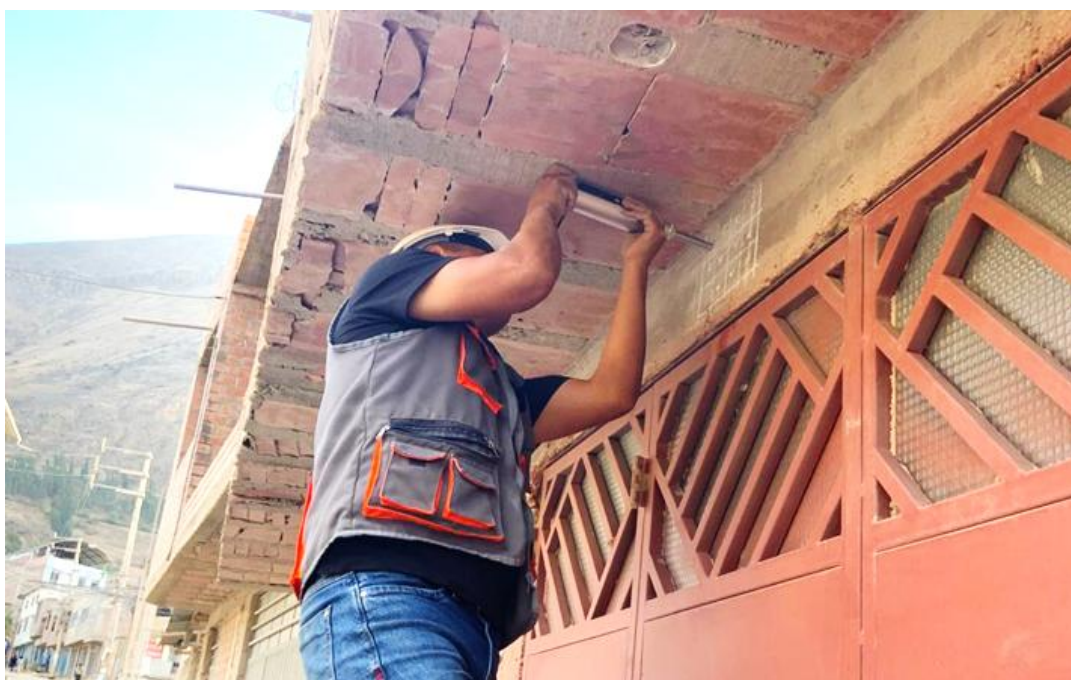
FOTOGRAFÍA N° 10: Ensayo de esclerometría en viga, perteneciente a la vivienda ubicado en el Jirón Ricardo Palma N° 266.
