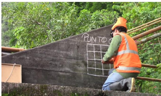
FOTO : Cámara de Anclaje del Estribo Derecho Aguas Abajo
