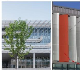
Louvres (laminas unicamente verticales)
