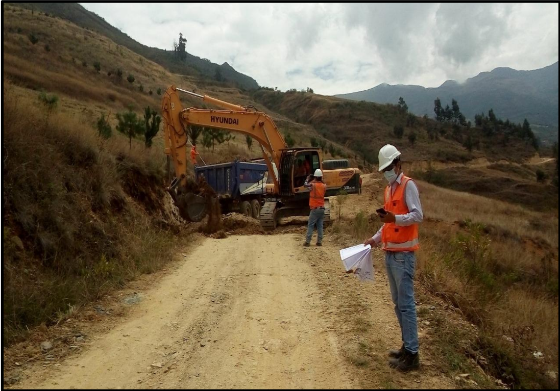
INICIOS DE TRABAJOS DE CORTE
