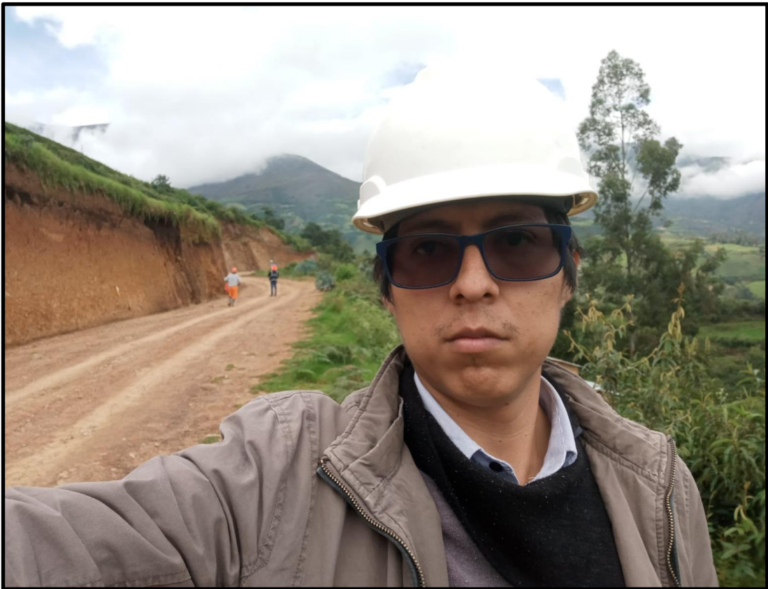
VERIFICACIÓN DE EJE, ANCHO DE VÍA Y CUNETAS
