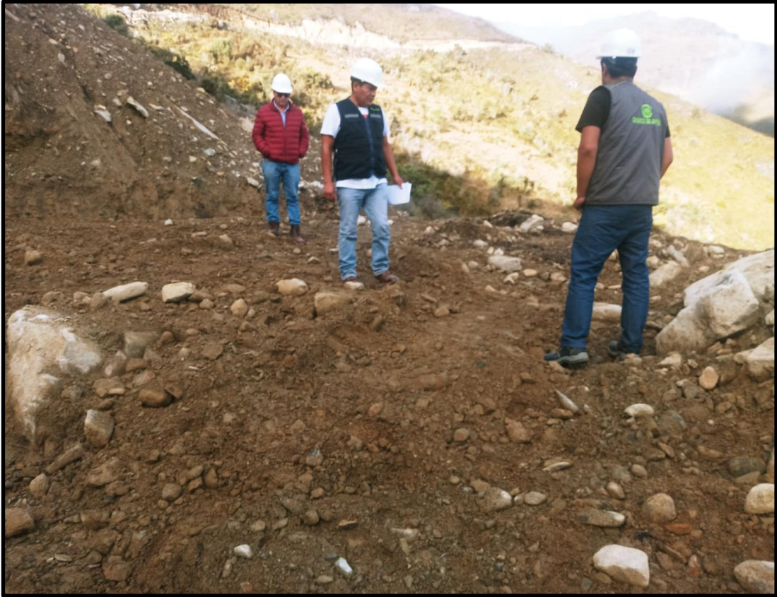
VISITA A CAMPO PARA UBICACIÓN DE MUROS DE CONTENCIÓN
