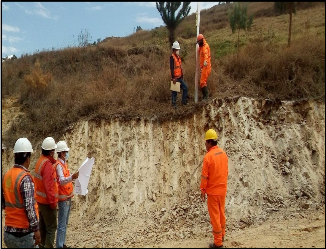
VERIFICACIÓN DE TALUDES SUPERIORES
