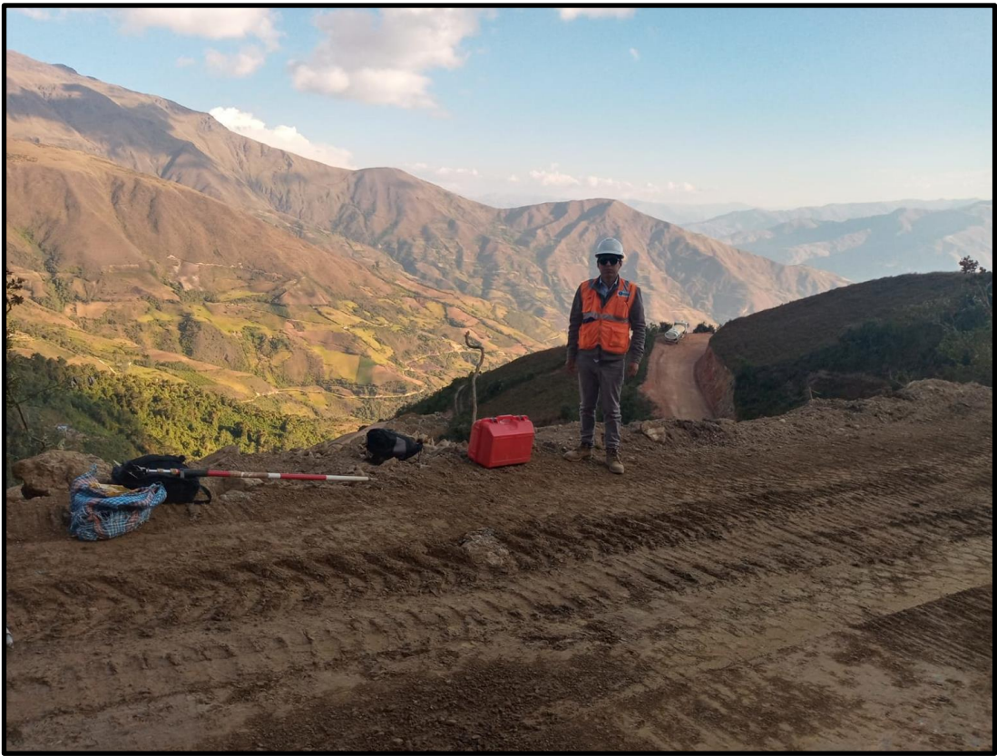
VISITA A CAMPO PARA VERIFICACIÓN DE NIVEL DE SUB RASANTE
