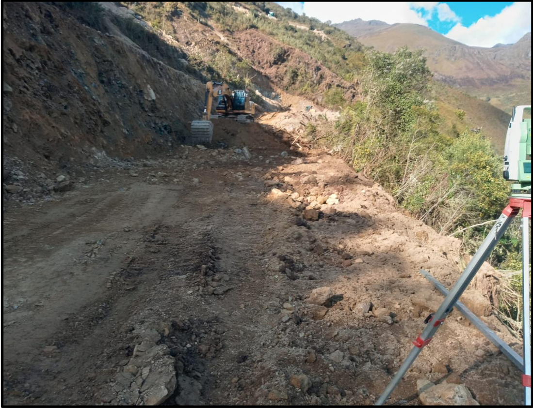
VERIFICACIÓN DE LOS TRABAJOS DE REPLANTEO PARA CORTE EN TALUD
