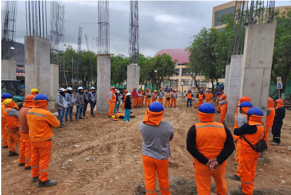
Imagen 47 Se aprecia la charlas de seguridad en campo.
