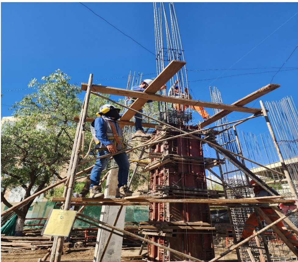
Imagen 48 Se aprecia la liberación de partidas de encofrado de columnas.
