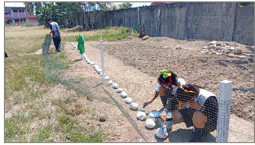
Instalación de cerco de piedras, mallas, calaminas y pintado.
