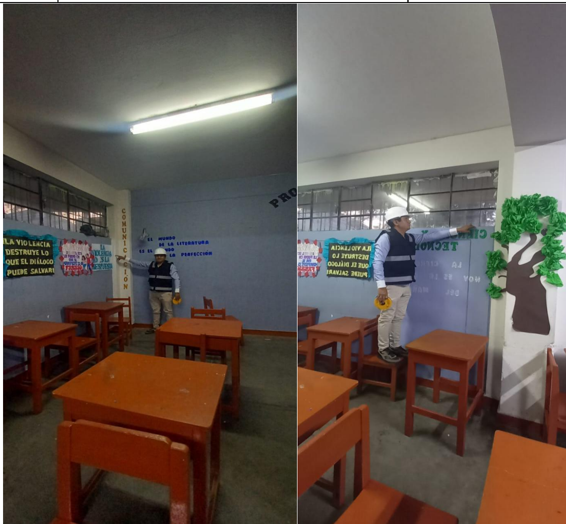
Fotografía 5 Vista interna del aula, procedemos a realizar una inspeccion visual de como se encuentra la estructura para ver si presenta daños como fisuras, desprendimientos, deformaciones o indicios de deterioro que puedan comprometer el desempeño estructural del portico ante acciones sismicas. Asi mismo se verifica el vano alto de ventana y su interracion con los elementos de concreto armado, debido a su incidencia en el efecto de columna corta.
