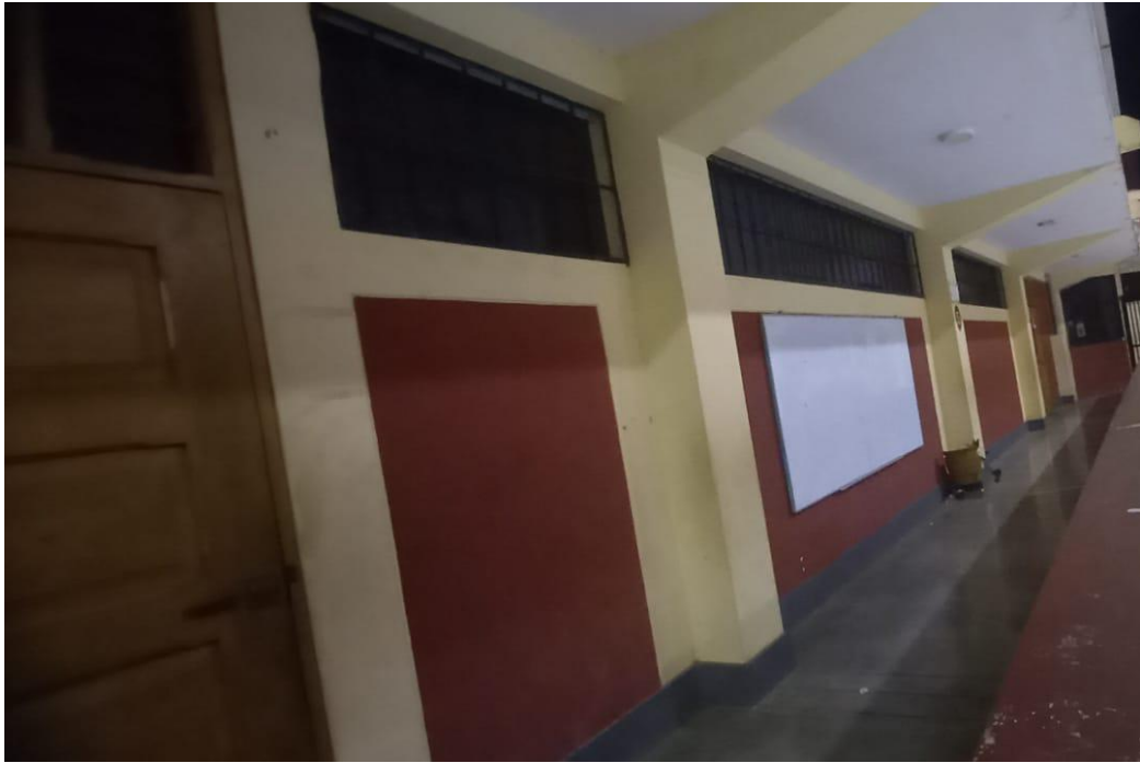
Fotografía 13 Vista del segundo nivel del pabellon A, se aprecia como esta conformado el portico con el prototipo 780-PRE.
