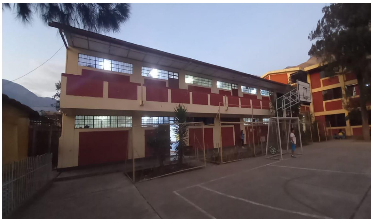
Fotografía 2 Vista de frontal del pabellon 4, se aprecia el modelo de portico escolar tipo 780-PRE, estandarizado con un modelo repetitivo.
