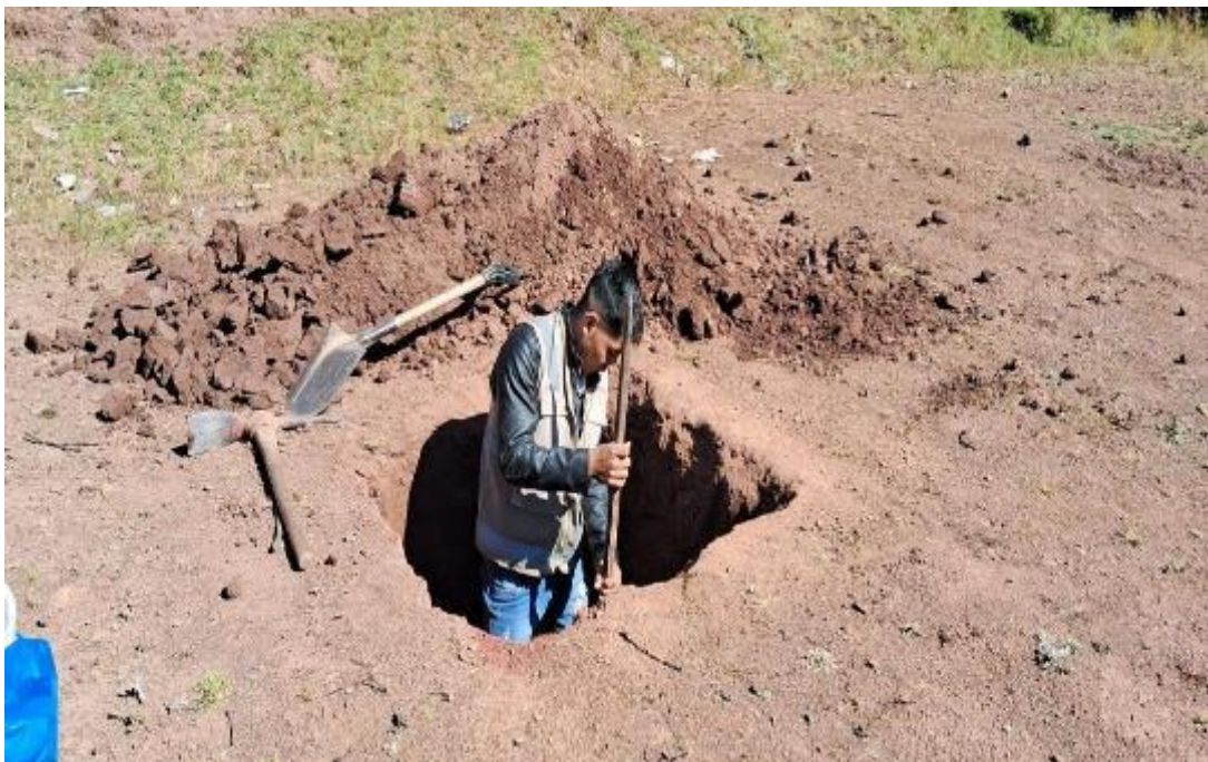
Excavación de la calicata N° 02 hasta una profundidad de 2.00 m
