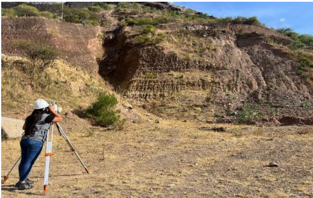
Levantamiento topográfico y/o toma de datos con Estación Total del talud en el kilómetro 352 de la carretera Cerro de Pasco – Huánuco.
