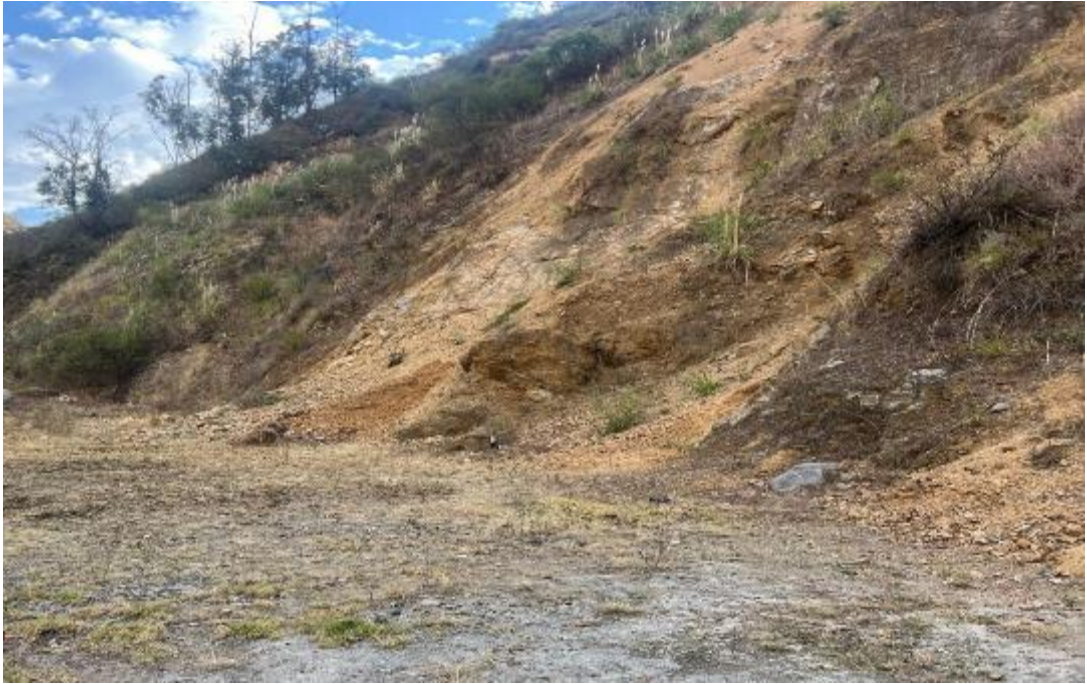
Vista panorámica del talud en el kilómetro 347 de la carretera Cerro de Pasco – Huánuco.
