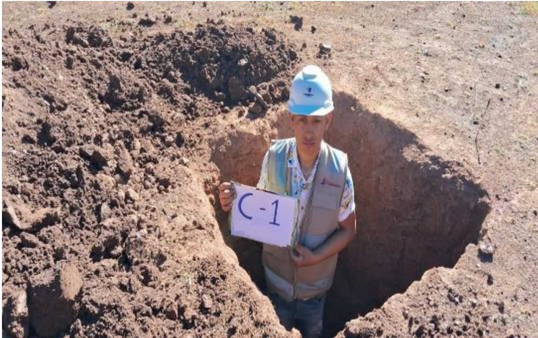
Calicata N° 01 en el kilómetro 347 de la carretera Cerro de Pasco – Huánuco.
