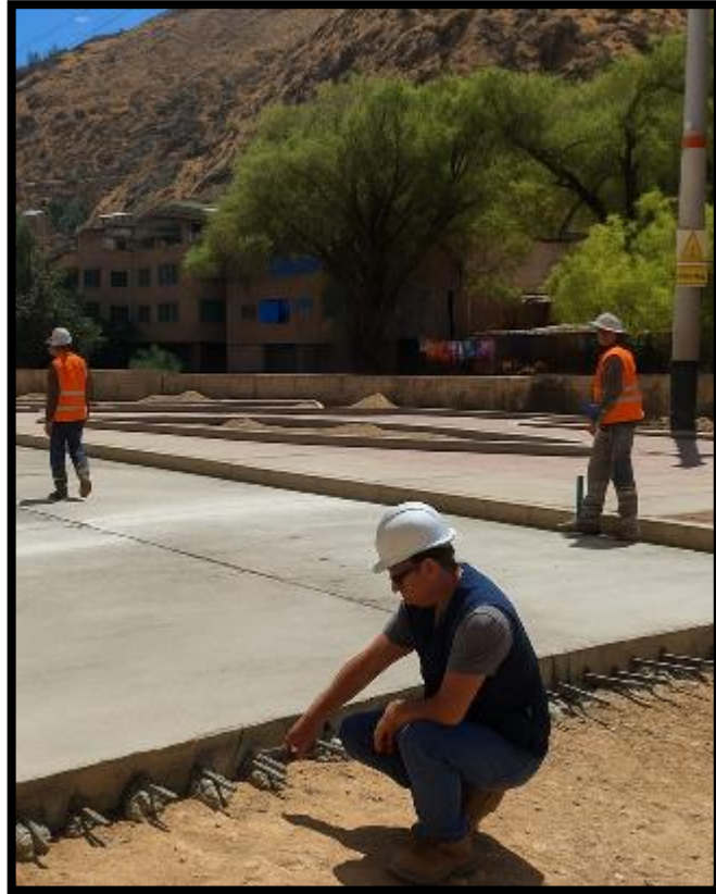
Desenfofrado del pavimento rívido y se aprecia también los dowells en la junta transversal.
