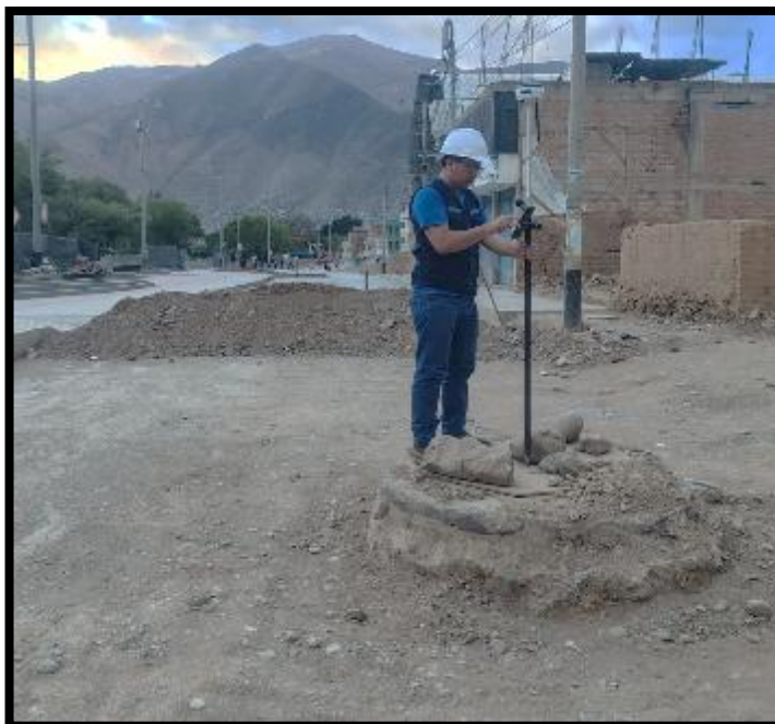
Levantamiento topográfico de buzones dentro del proyecto para subsanar errores u omisiones.
