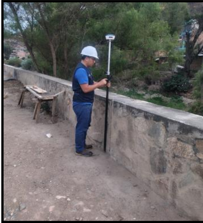
Levantamiento topográfico del Malecón Higueras con el GPS Diferencial para la corroboración con los planos existentes.
