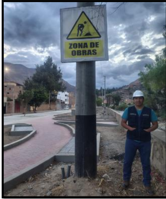
Vista de avances de los trabajos realizados al final del día con avance al 43%.
