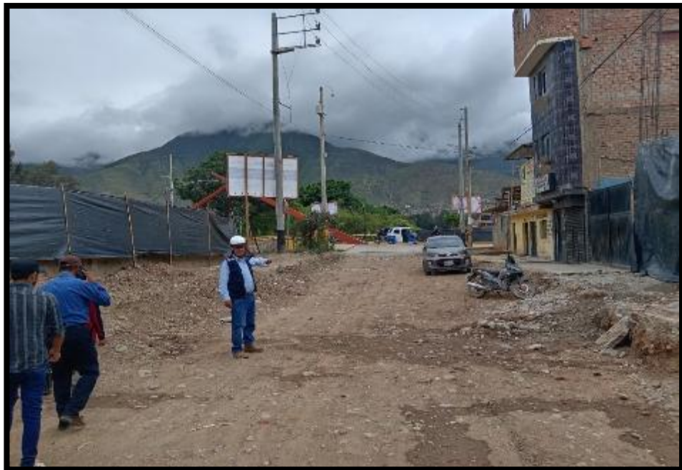
Se aprecia en la fotografía la obstrucción de las Cajas de inspección de drenaje de aguas de lluvia existentes.
