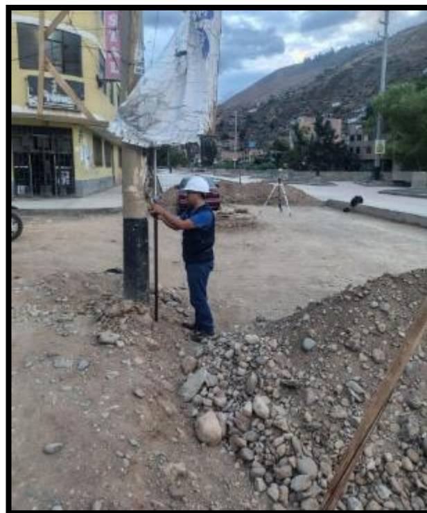
Asistencia de residencia tomando puntos durante la ejecución del proyecto mediante la Base y el Rover.
