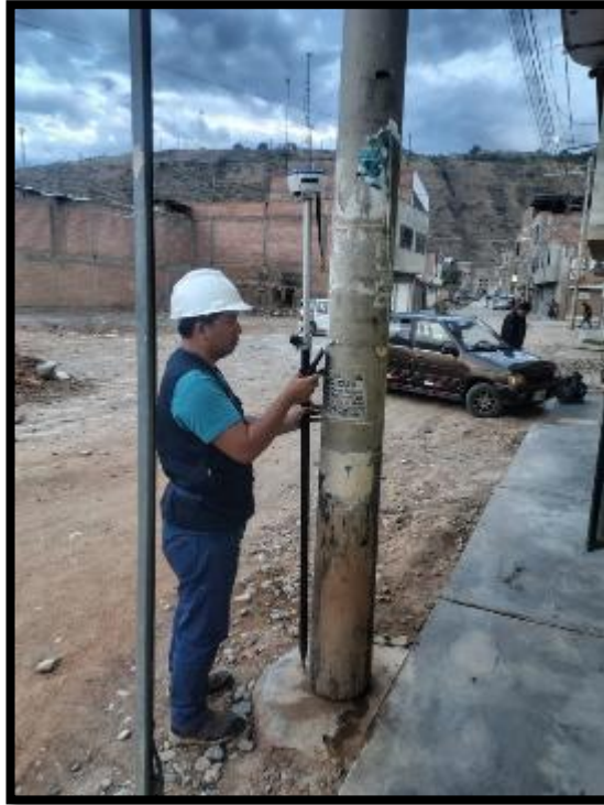
Lecturando postes de luz, que invade la cuneta proyectada.
