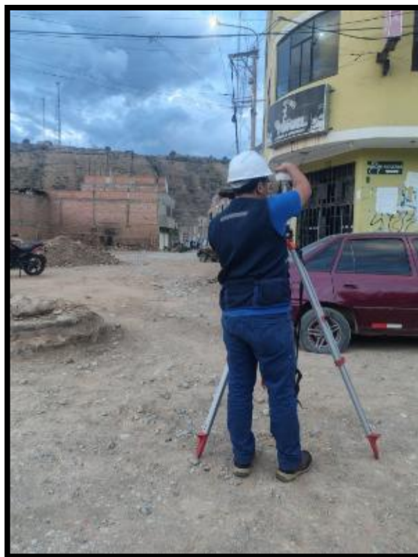
Verificación de planos y área de afectados en obra con el asistente de supervisión en la Cdra 9 del Malecón Higueras.
