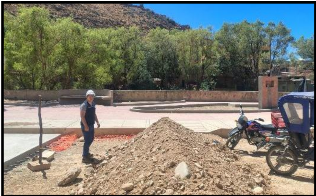
Vista de la eliminación de material excedente y desenfofrado de pavimento rívido.
