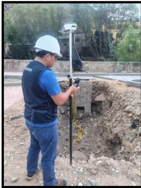
Toma de puntos topográficos a una altura de 1.80 m para las pendientes de desagüe de caja de registro a buzón.
