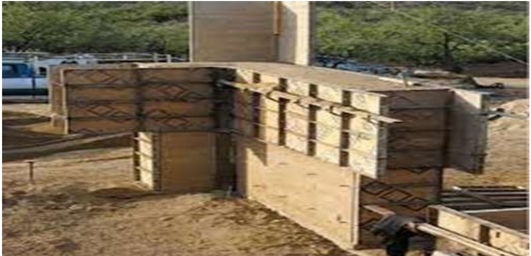
Figura 1 Muros de tapial levantados con tierra arcillosa compactada
