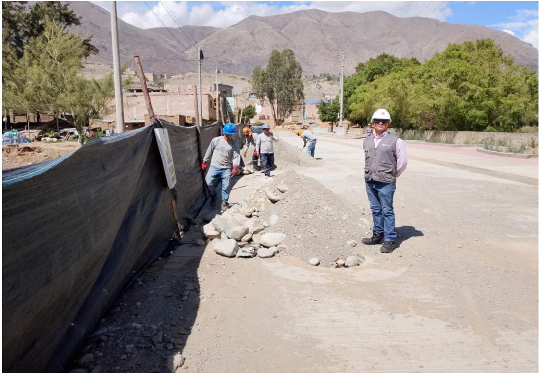
Figura A1 Vista general del área de intervención del proyecto Malecón Higueras
