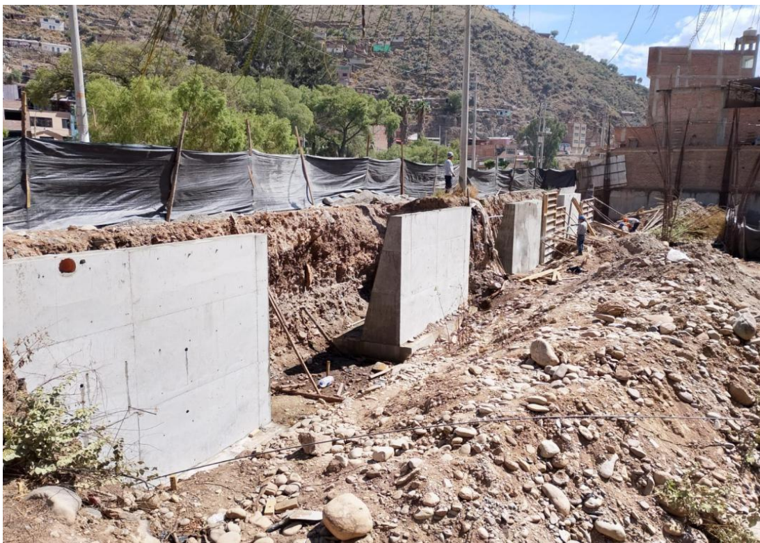
Figura A3 Vista general del área de intervención del proyecto Malecón Higueras
