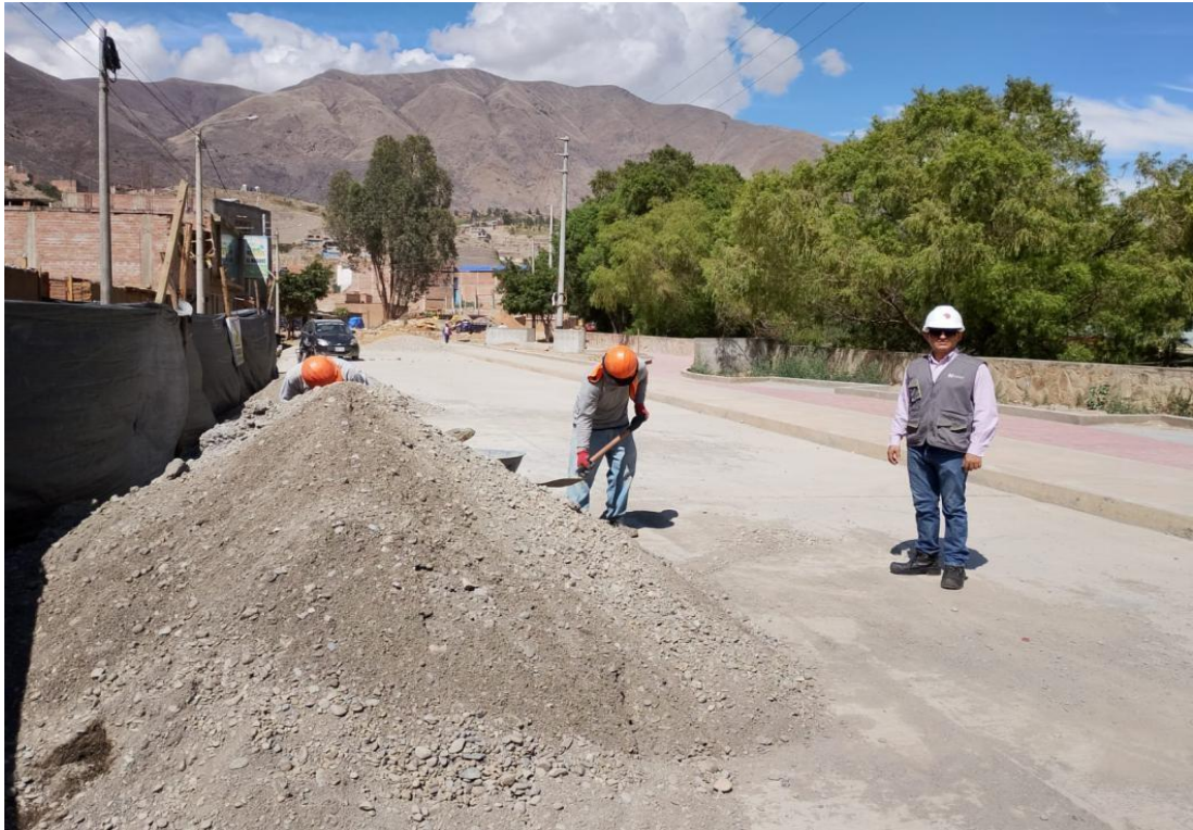
Figura A2 Vista general del área de intervención del proyecto Malecón Higueras
