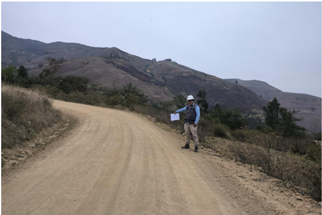
Tesista haciendo las verificaciones en el subtramo 19 progresiva 01+800 al 01+900
