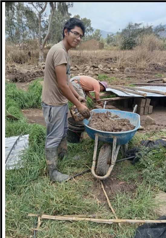
Preparación para el moldeo del adobe
