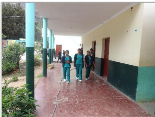
Imagen 06 Institución Educativa de Micaela Bastidas (Pasillo de circulación 2). Fuente: Fotografía Propia
