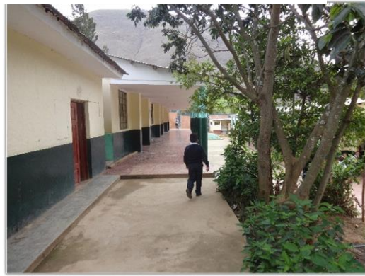
Imagen 03 Institución Educativa de Micaela Bastidas (Pasillo de circulación 1). Fuente: Fotografía Propia
