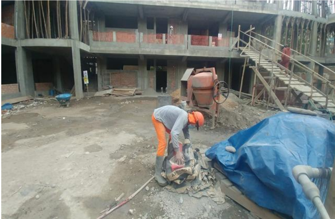
Traslado de residuos de la construcción, durante el periodo de ejecución de la obra.
