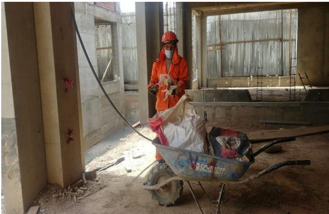
Recolección y traslado de residuos de la construcción, durante el periodo de ejecución de la obra.
