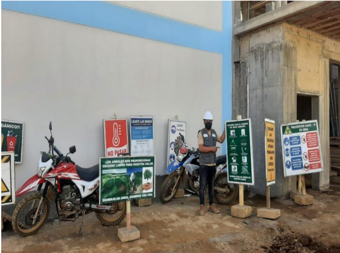
Identificación de señalizaciones para los residuos de la construcciones, durante el periodo de ejecución de la obra.
