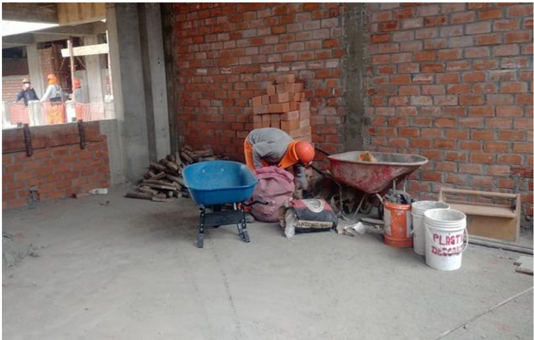
Selección de residuos de la construcción de acuerdo a su clasificación, durante el periodo de ejecución de la obra.
