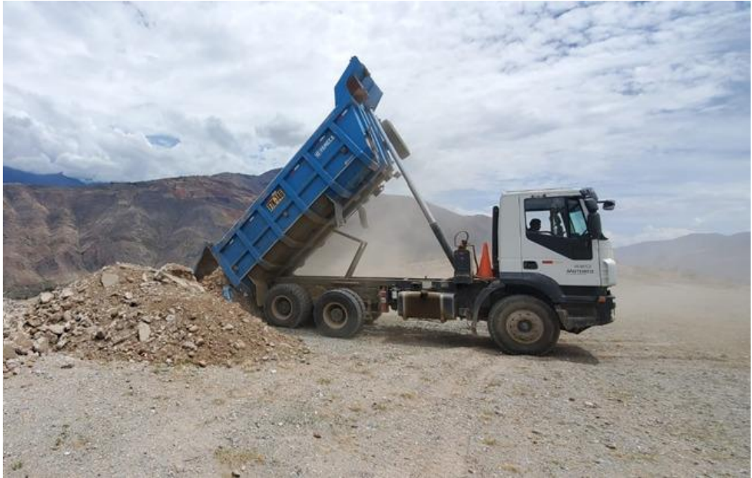
Eliminación de residuos de la construcción, durante el periodo de ejecución de la obra.
