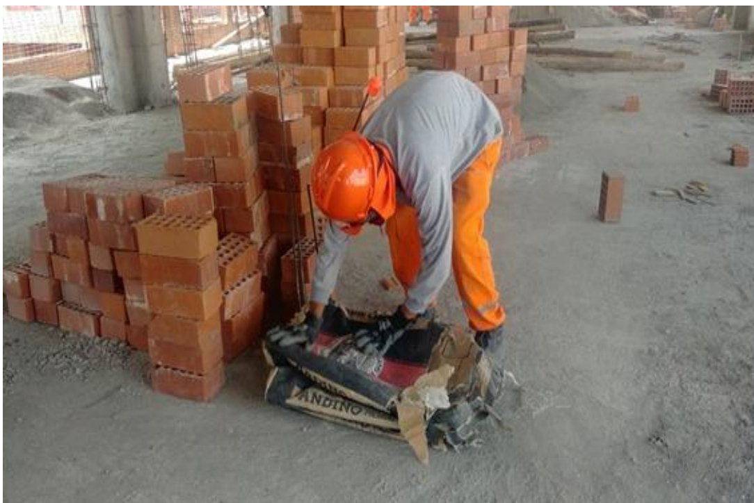
Clasificación de los residuos de la construcción, durante el periodo de ejecución de la obra.
