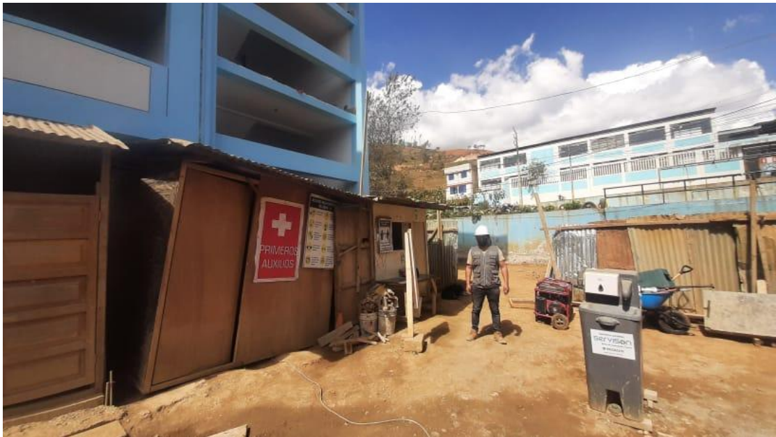
Ubicación de contenedores para la selección de los residuos de la construcción, durante el periodo de ejecución de la obra.
