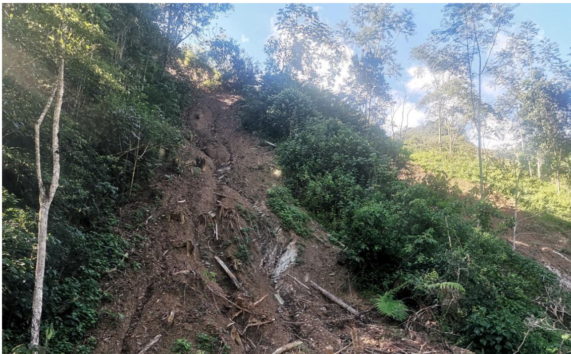
Figura 12 Zonas de deslizamiento en la parte alta del caserío
