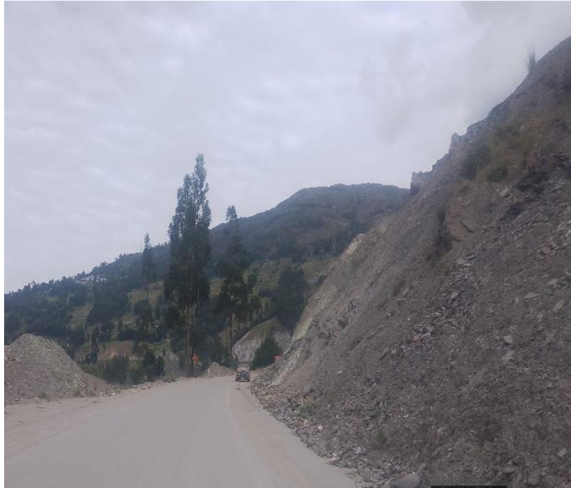
panoramica longitudinal del talud del tramo II de Huánuco a La union.
