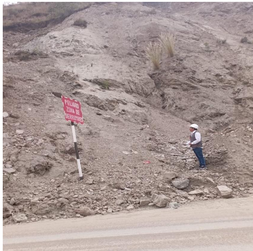
Personal realizando la inspeccion visual del punto critico con libreta.
