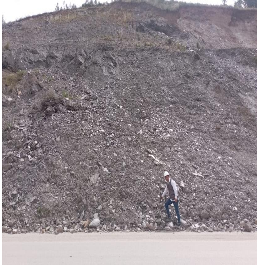
Proceso de medicion sobre el talud (mirando hacia el ladera).
