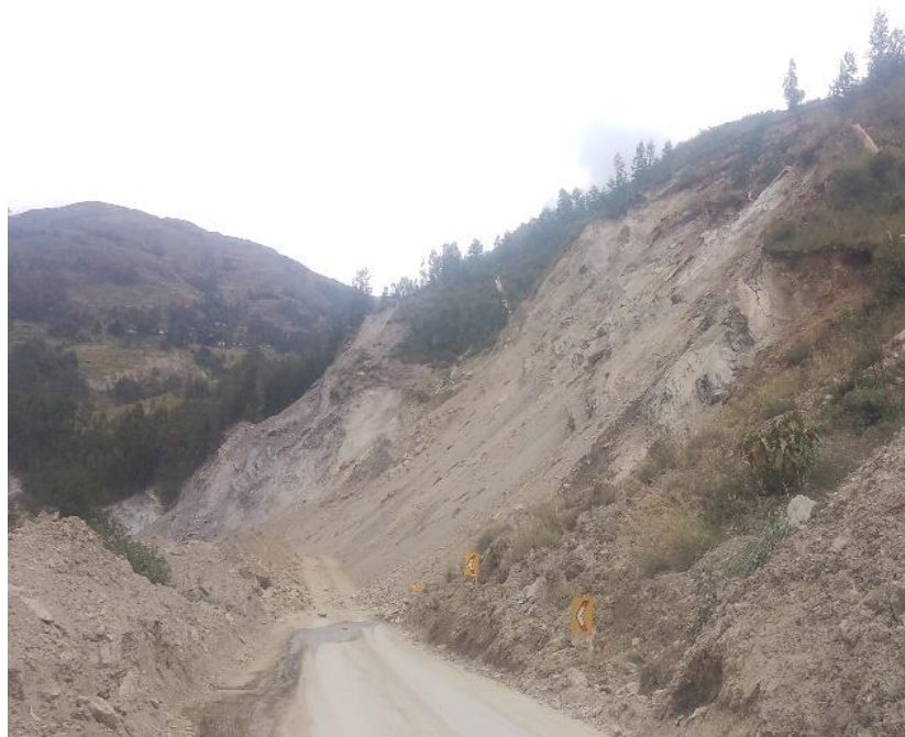
Zonas intervenidas (limpieza) del tramo II de Huánuco a La union.
