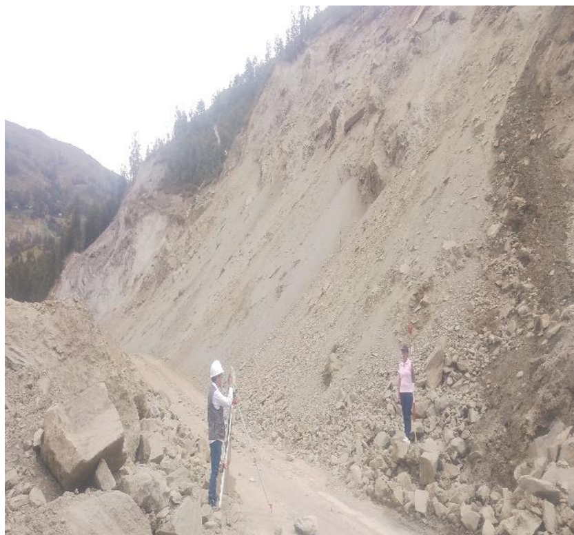
Levantamiento topografico en la zona itervenida (limpieza) del tramo II de Huánuco a La union.
