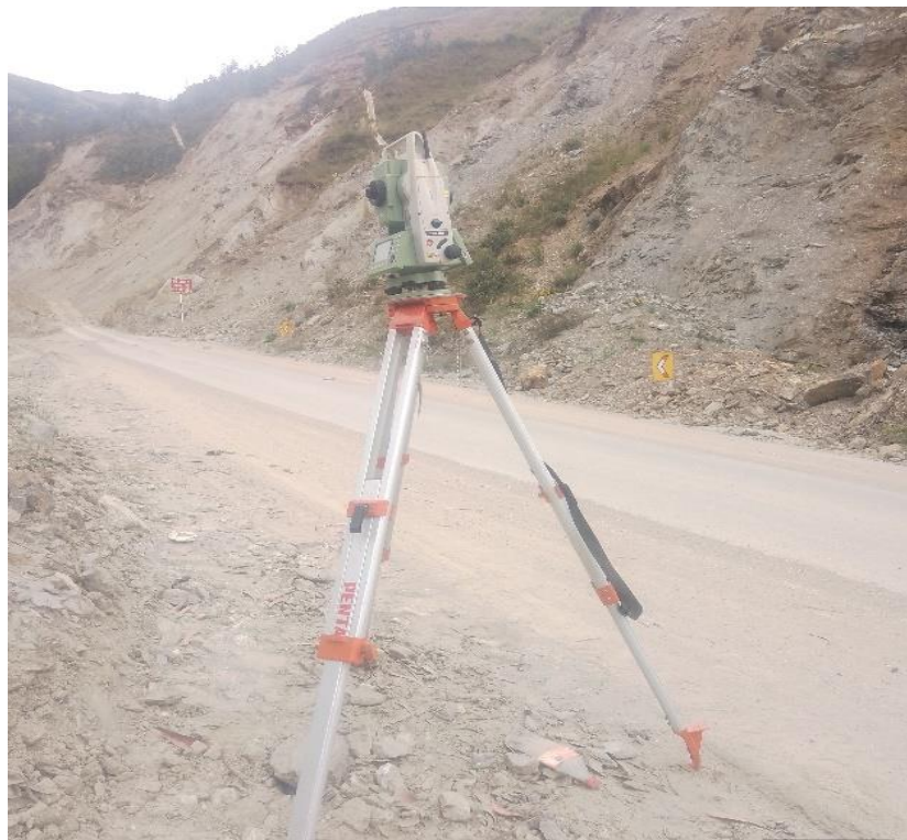
Equipo topografico posicionado en el terreno.
