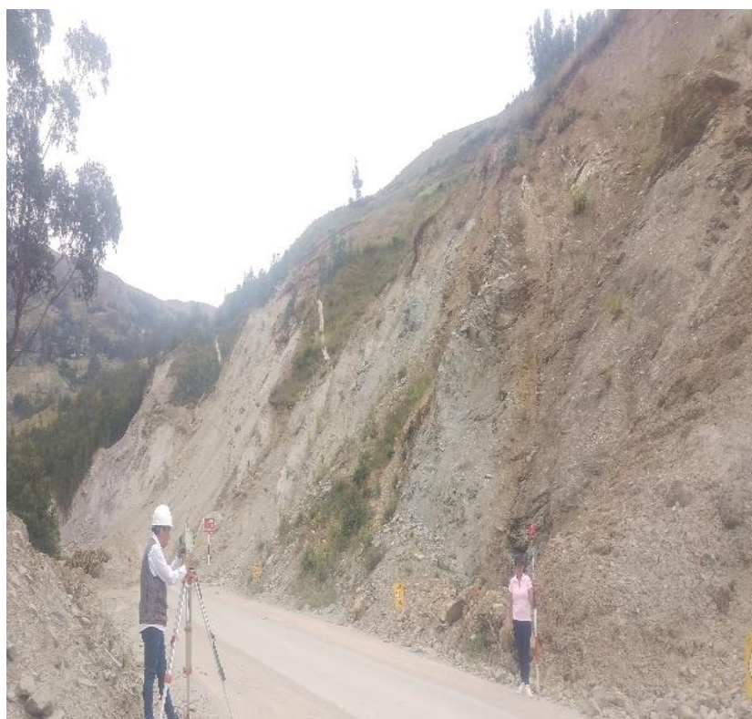
Levantamiento topografico en el punto critico con mayor inestabilidad del tramo II de Huánuco a La union.
