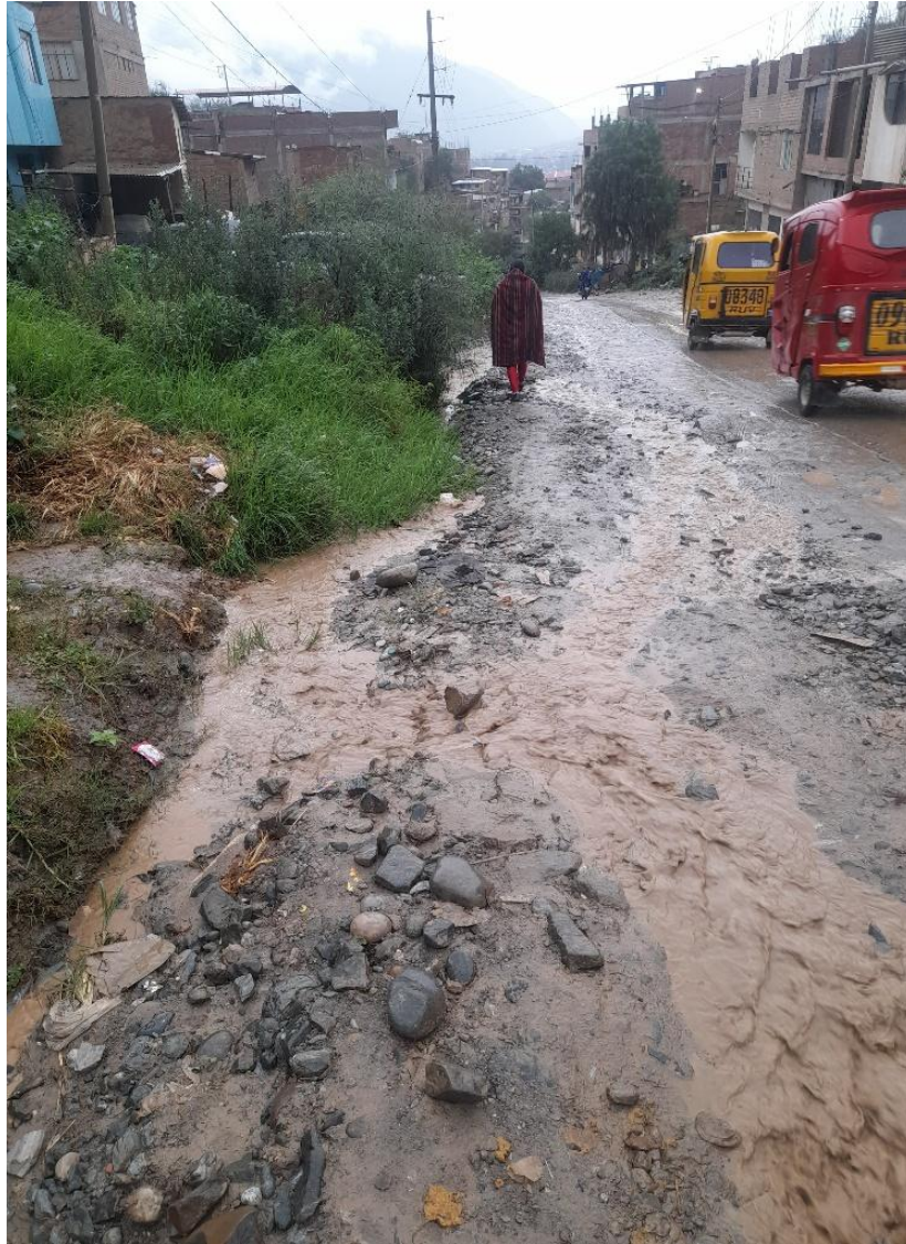
Abril 2025: vía urbana erosionada con escorrentía superficial y arrastre de sedimentos en el AA. HH Aparicio pomares, Huánuco (2025).
