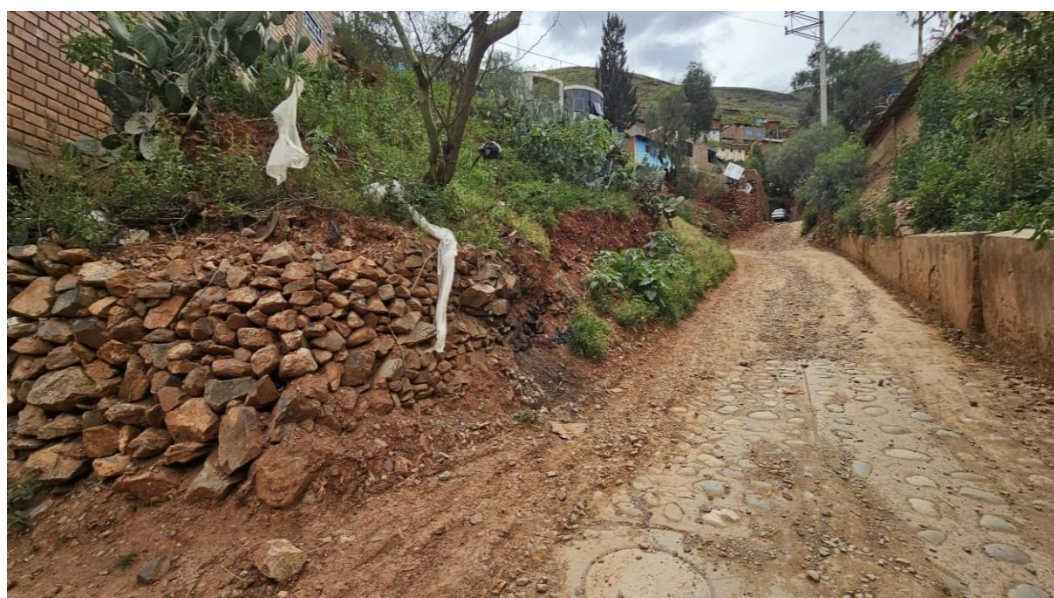
Junio 2025: escalinata afectada por acumulación de material y restos de vegetación tras proceso de inestabilidad en el AA. HH Aparicio pomares, Huánuco (2025).
