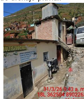
Vivienda mal ubicada en ladera, con acumulación de aguas pluviales y ausencia de drenaje.
