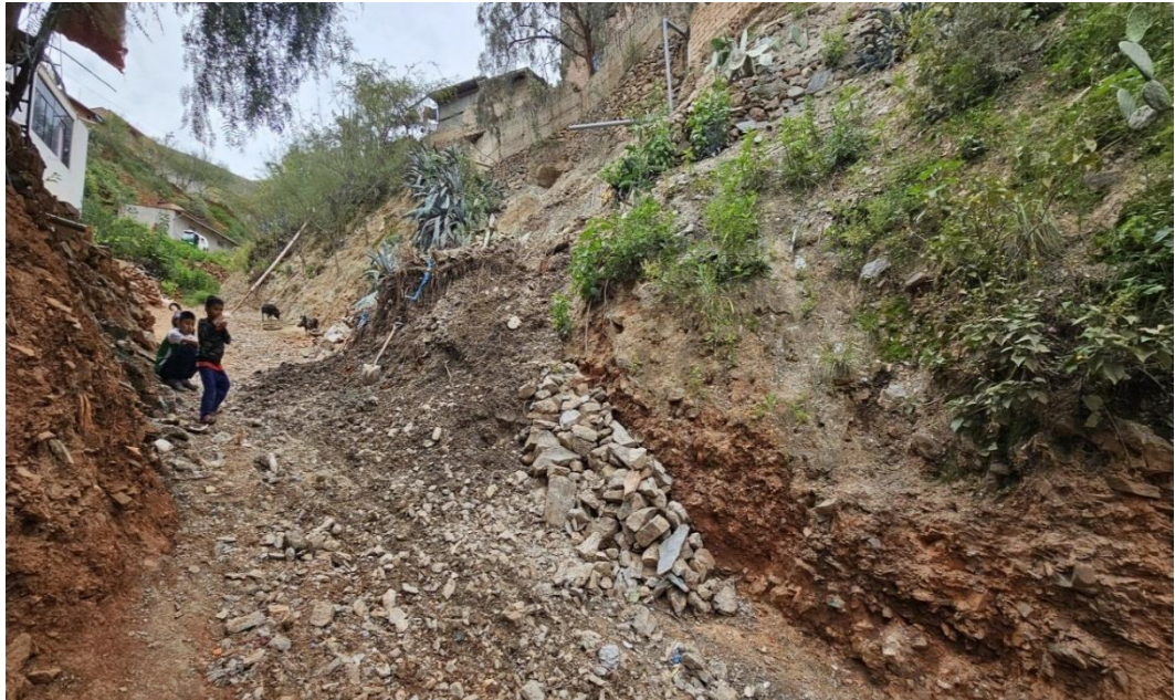
Enero 2025: se aprecia deslizamiento de masa con acumulacion de rocas, piedras y suelo suelto en el AA. HH Aparicio pomares, Huánuco (2025).
