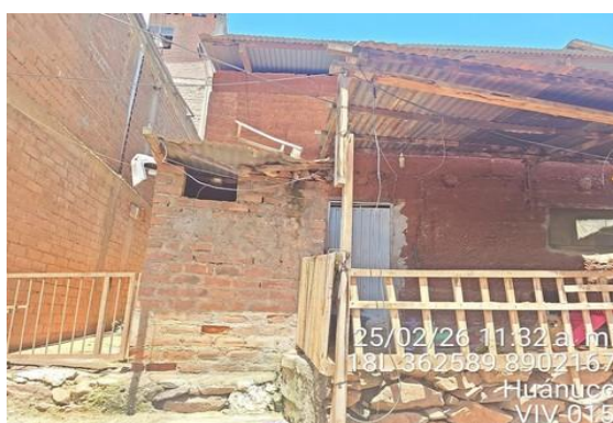
Vivienda de tapial con daño y humedad en paramentos y base por escurrimiento pluvial sin drenaje
