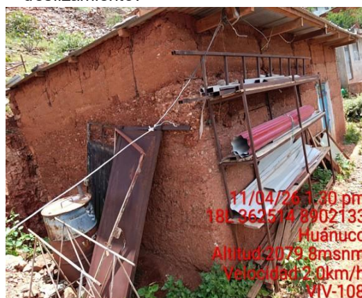
Vivienda de tapial en estado crítico, ubicada en ladera, con cimentación susceptible a humedad, fisuras en muros y ausencia de drenaje pluvial.
