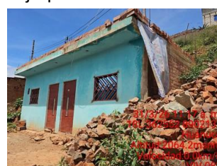
Vivienda de tapial en estado crítico, ubicada en ladera, con cimentación susceptible a humedad, fisuras en muros y ausencia de drenaje pluvial.
