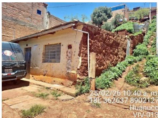
Vivienda de tapial con daño y humedad en paramentos y base por escurrimiento pluvial sin drenaje
