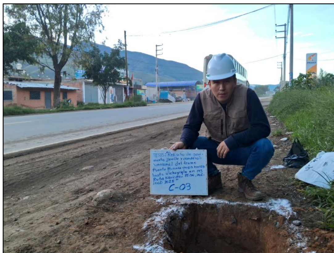
Registro visual de la calicata C-03, ubicada en el Km 170+000 de la Ruta Nacional PE-3N como parte de los trabajos iniciales del estudio de suelos.
