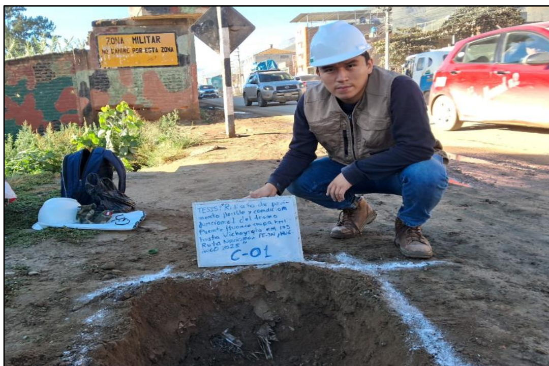
Registro visual de la calicata C-01, ubicada en el Km 168+000 de la Ruta Nacional PE-3N como parte de los trabajos iniciales del estudio de suelos.
