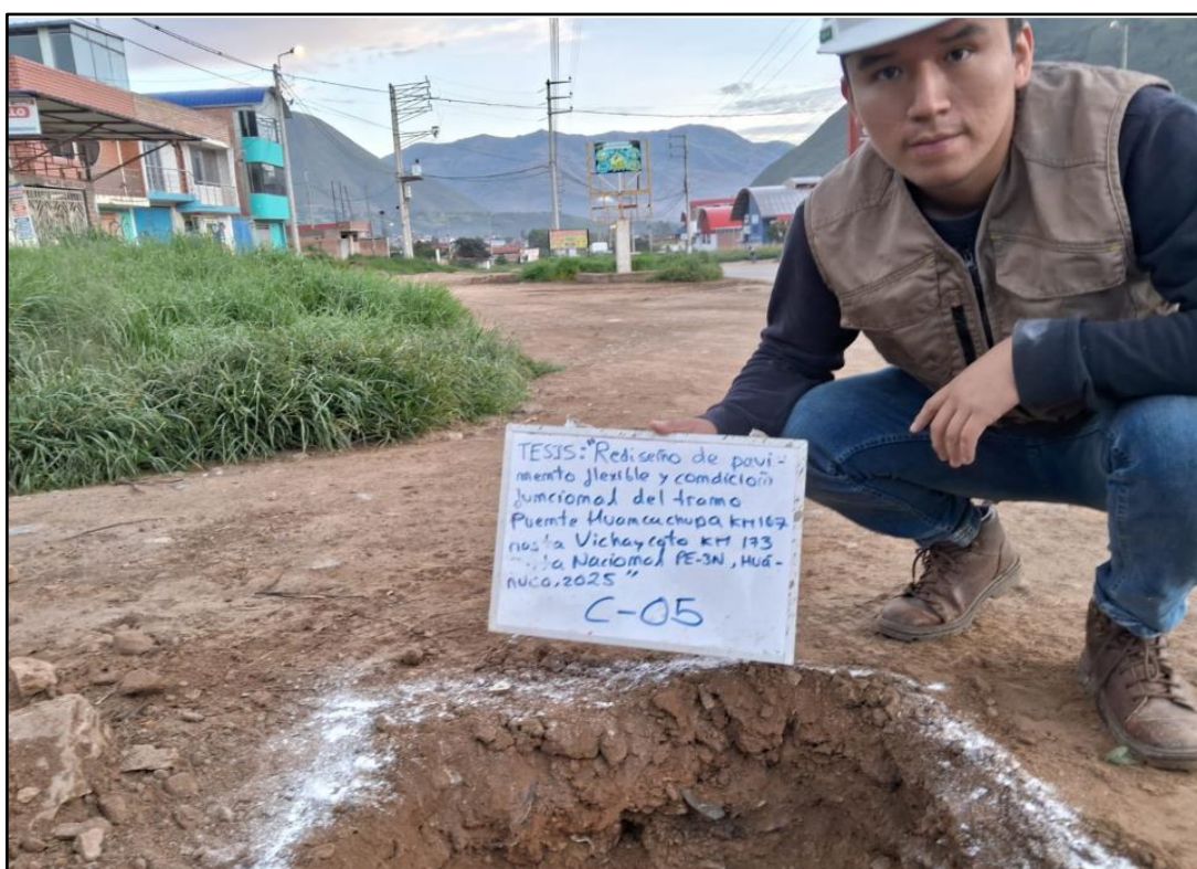
Registro visual de la calicata C-05, ubicada en el Km 172+000 de la Ruta Nacional PE-3N como parte de los trabajos iniciales del estudio de suelos.
