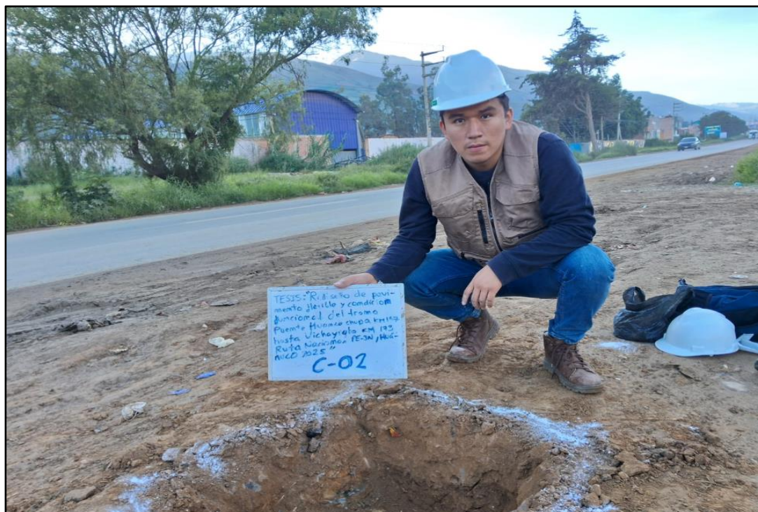
Registro visual de la calicata C-02, ubicada en el Km 169+000 de la Ruta Nacional PE-3N como parte de los trabajos iniciales del estudio de suelos.
