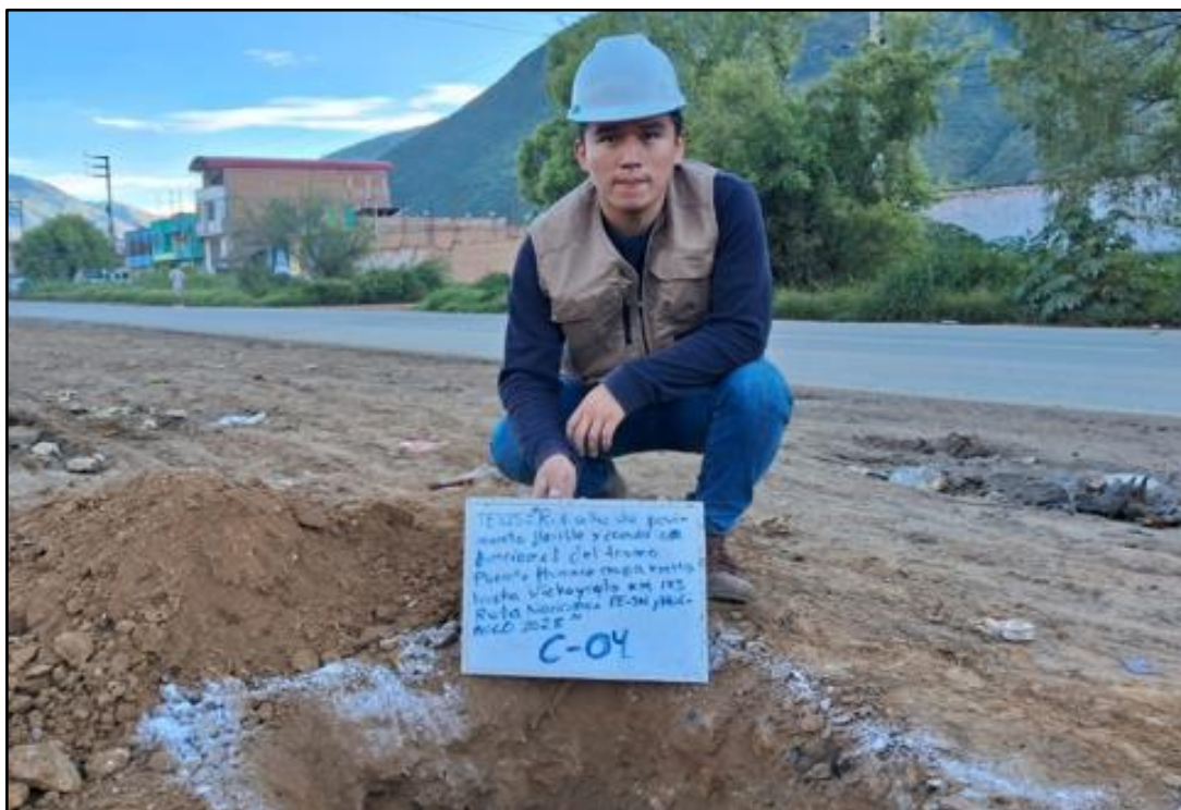
Registro visual de la calicata C-04, ubicada en el Km 171+000 de la Ruta Nacional PE-3N como parte de los trabajos iniciales del estudio de suelos.
