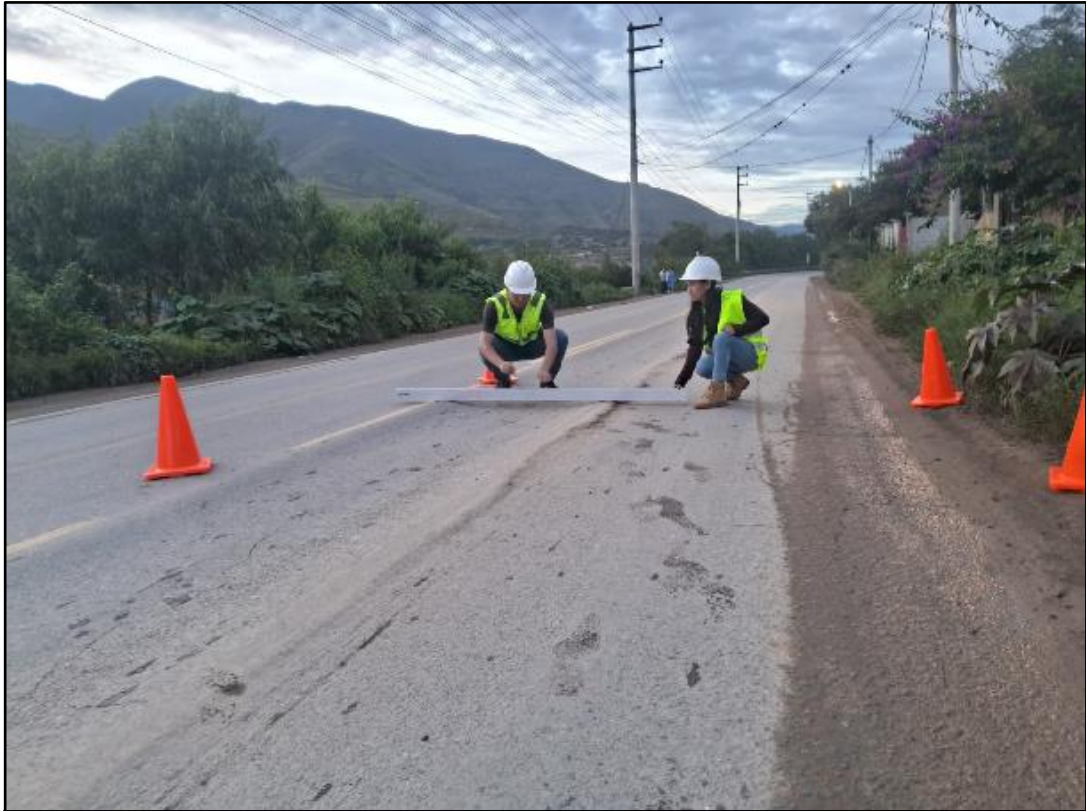
Registro visual de la medición de la profundidad de ahuellamiento, como parte de los trabajos para conocer el estado actual de la vía.
