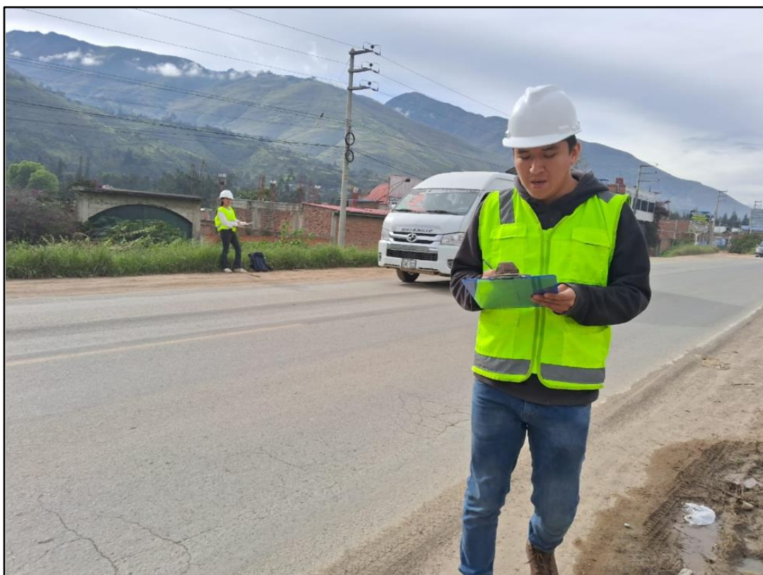
Registro visual del aforo vehicular, como parte de las actividades de estudio de tráfico.
