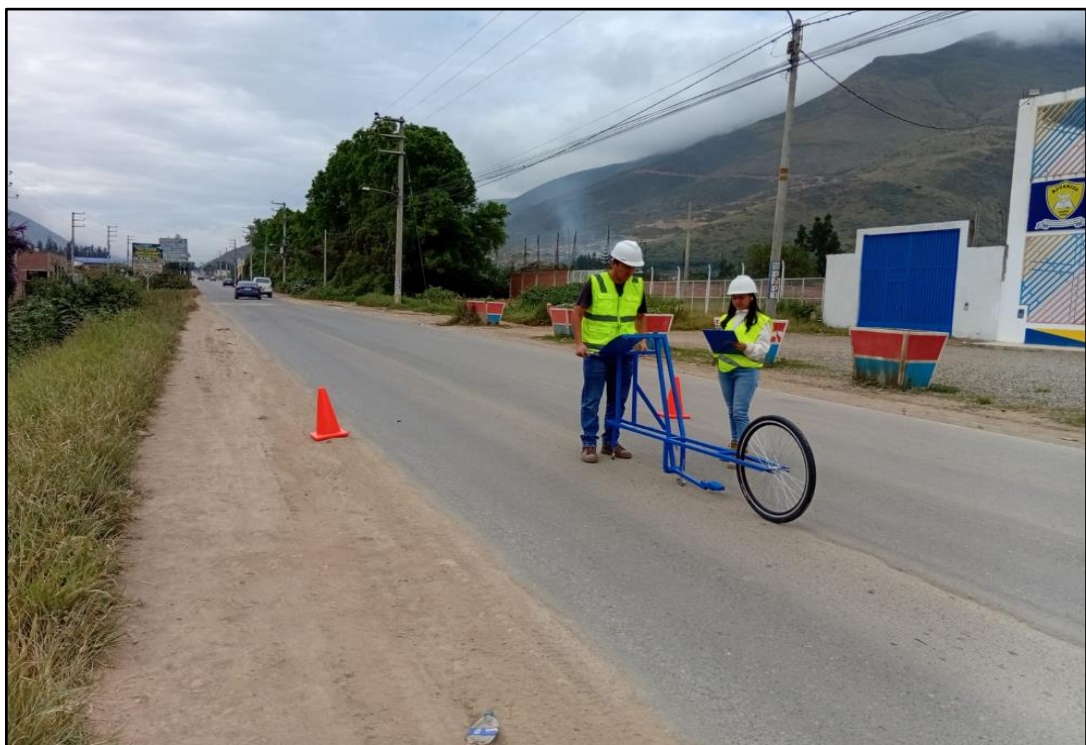
Figura 123. Registro visual de la medición del Índice de Regularidad Internacional, mediante el Equipo Merlin previamente calibrado, como parte de los trabajos para conocer el estado actual de la vía.
