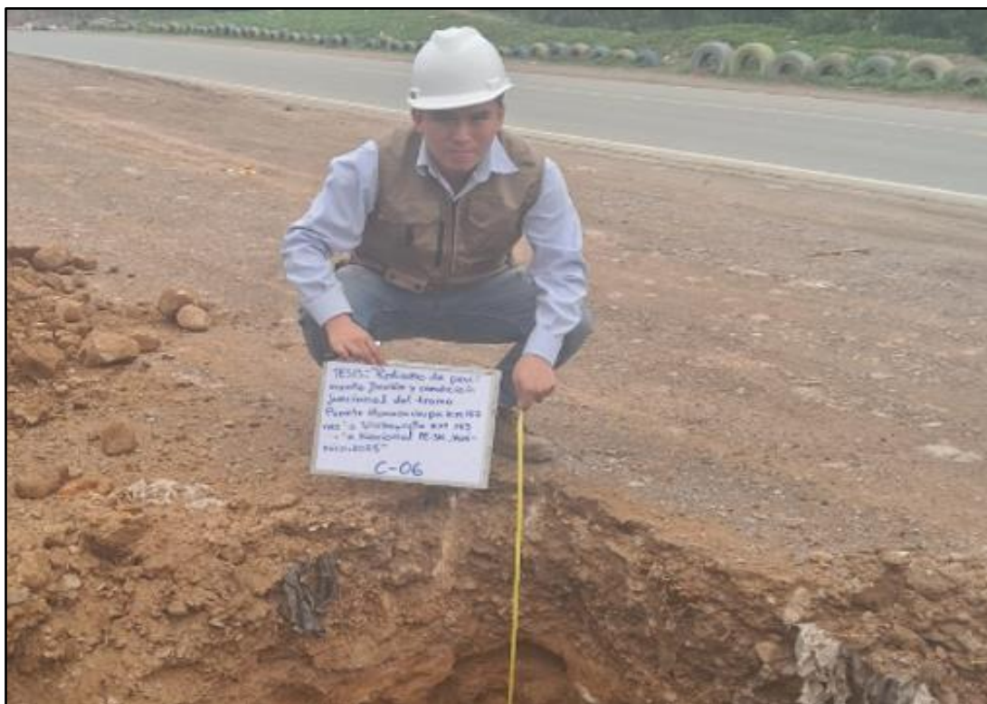
Registro visual de la calicata C-06, ubicada en el Km 173+000 de la Ruta Nacional PE-3N como parte de los trabajos iniciales del estudio de suelos.
