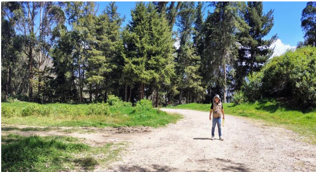
Recorrido de inspección efectuado para constatar el nivel de deterioro existente en la carretera objeto de estudio.
