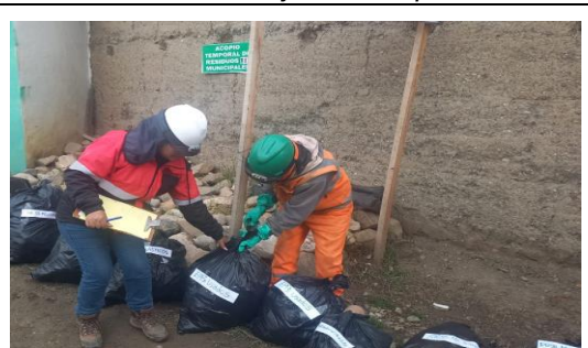
Revisión y acondicionamiento de bolsas de residuos segregados en el área de acopio.
