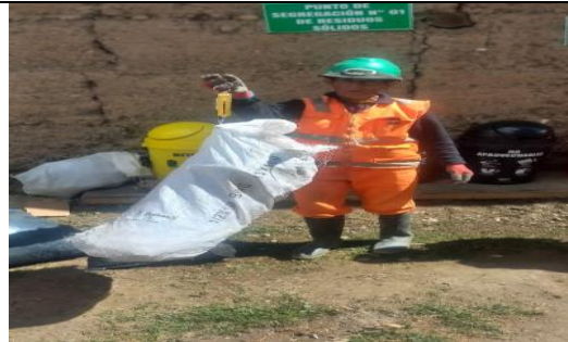
Personal encargado del manejo de residuos correctamente segregados en obra.
