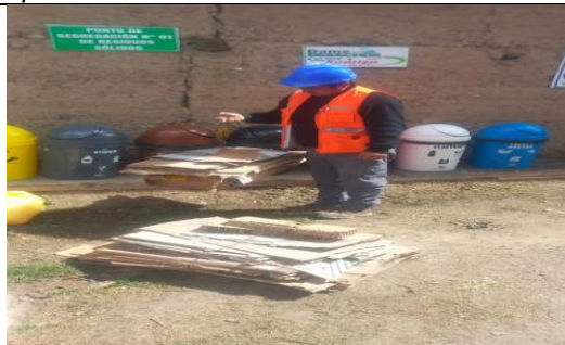
Evidencia de residuos clasificados y disposición diferenciada en recipientes de obra.
