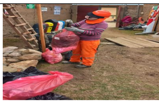
Manipulación manual de residuos recolectados durante la fase operativa de la obra.
