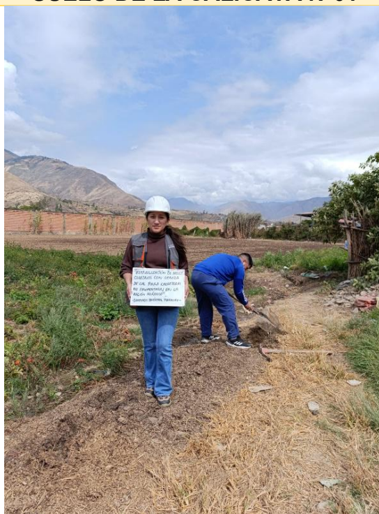
IMAGEN 02: APRECIAMOS LA EXTRACCIÓN DE MUESTRA DE SUELO DE LA CALICATA N°02
