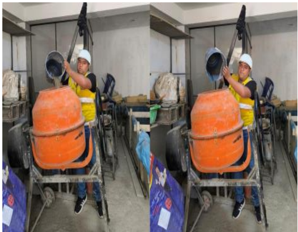
Adición del agua al trompo
