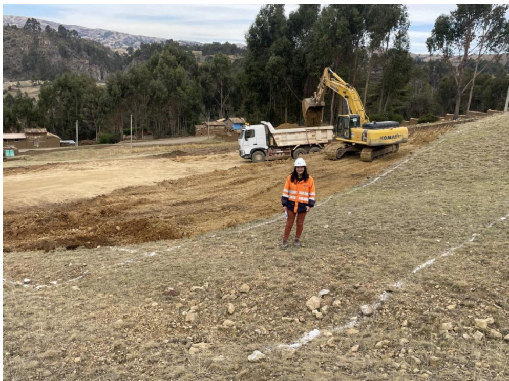
Trabajos de Transporte de material excedente
