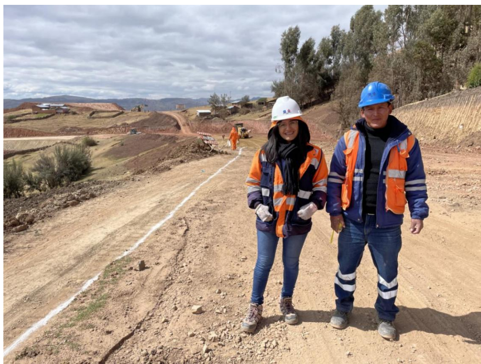
Trabajos realizados por la Motoniveladora, junto al equipo técnico.
