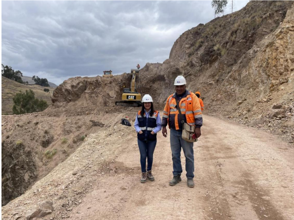
Trabajos realizados por la Excavadora, junto al maestro de obra.
