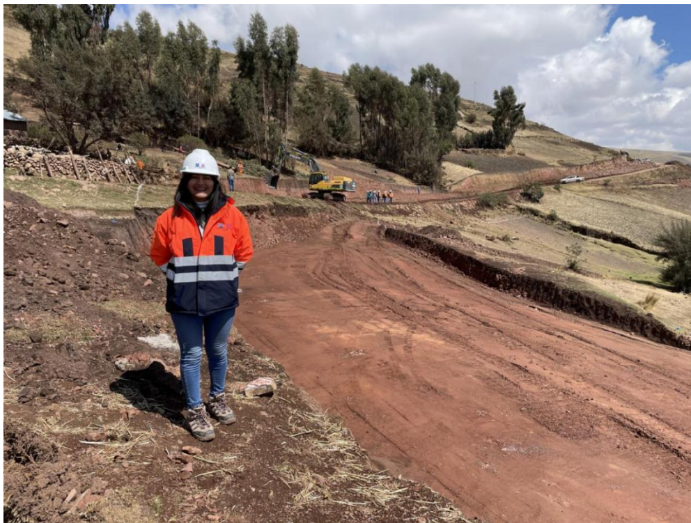
Trabajos realizados la Excavadora.
