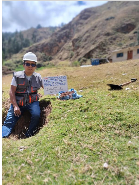
FOTOGRAFÍA N°12: Extracción de muestra de la calicata N° 01.
