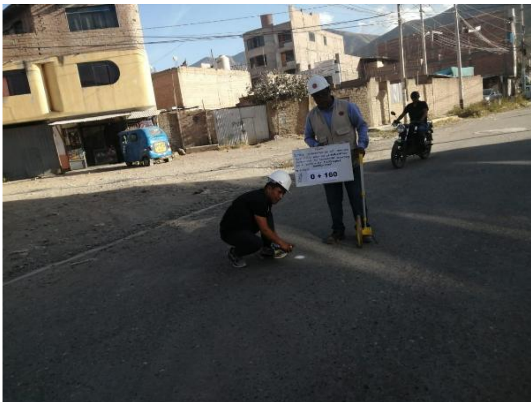
Fotografía 17 Vista de la progresiva 0+160 del Jr. Los Vilcos
