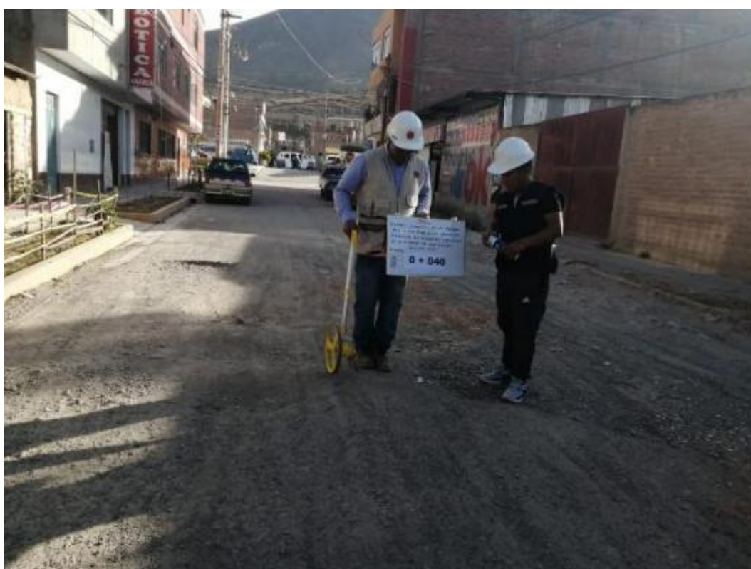
Fotografía 14 Vista de la progresiva 0+040 del Jr. Los Vilcos
