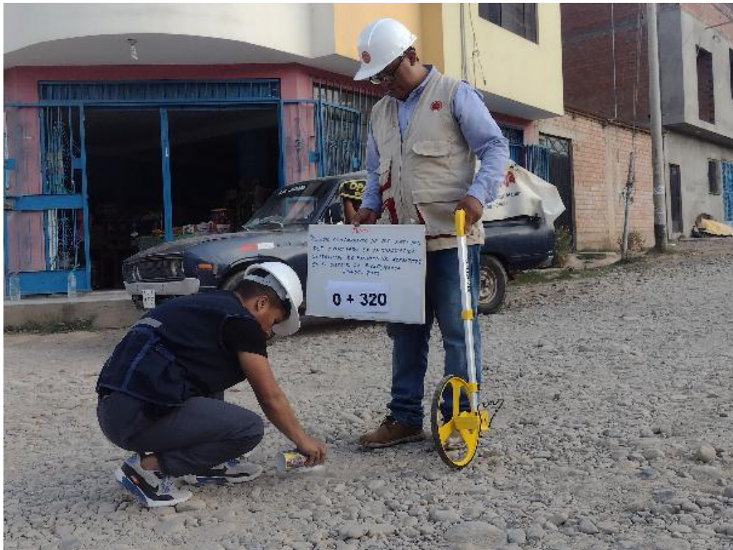
Fotografía 9 Vista de la progresiva 0+320 del Jr. Los Alisos
