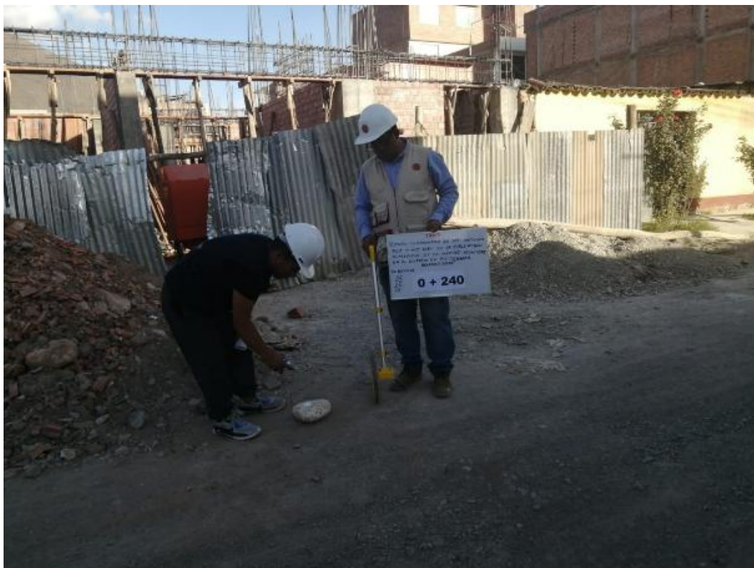
Fotografía 19 Vista de la progresiva 0+240 del Jr. Los Vilcos
