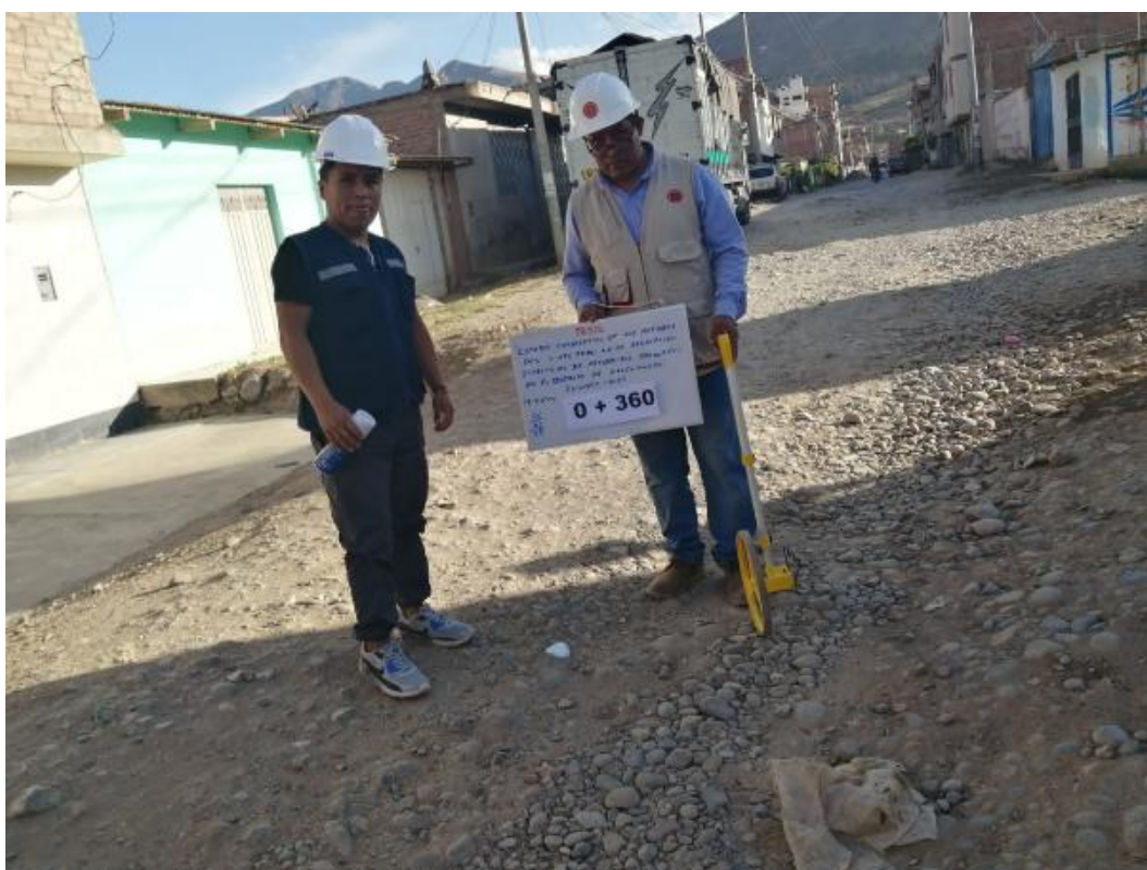
Fotografía 22 Vista de la progresiva 0+360 del Jr. Los Vilcos
