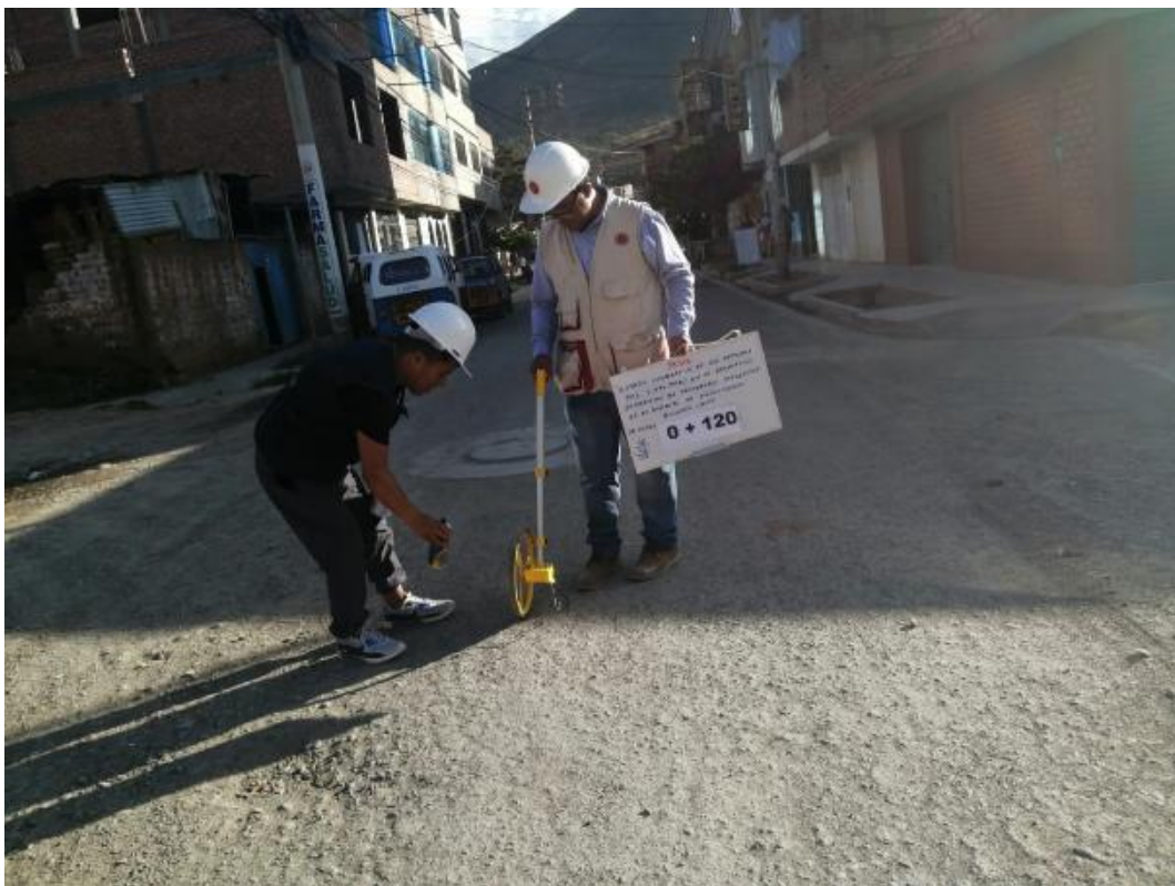
Fotografía 16 Vista de la progresiva 0+120 del Jr. Los Vilcos
