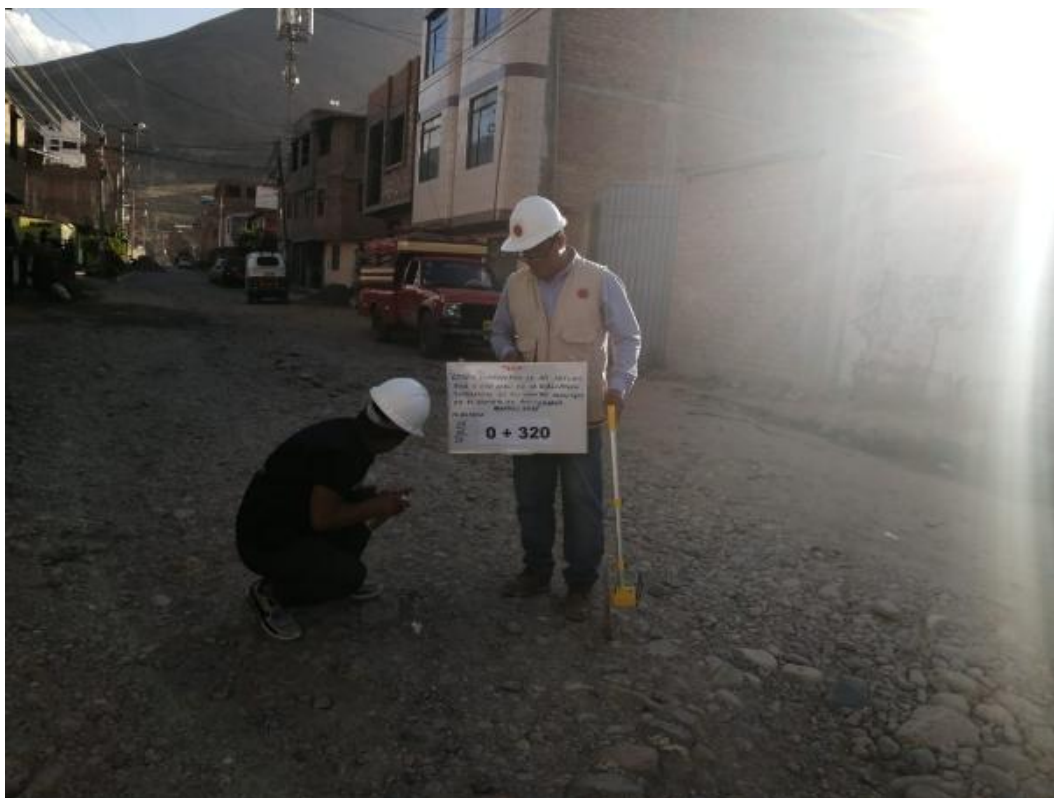
Fotografía 21 Vista de la progresiva 0+320 del Jr. Los Vilcos
