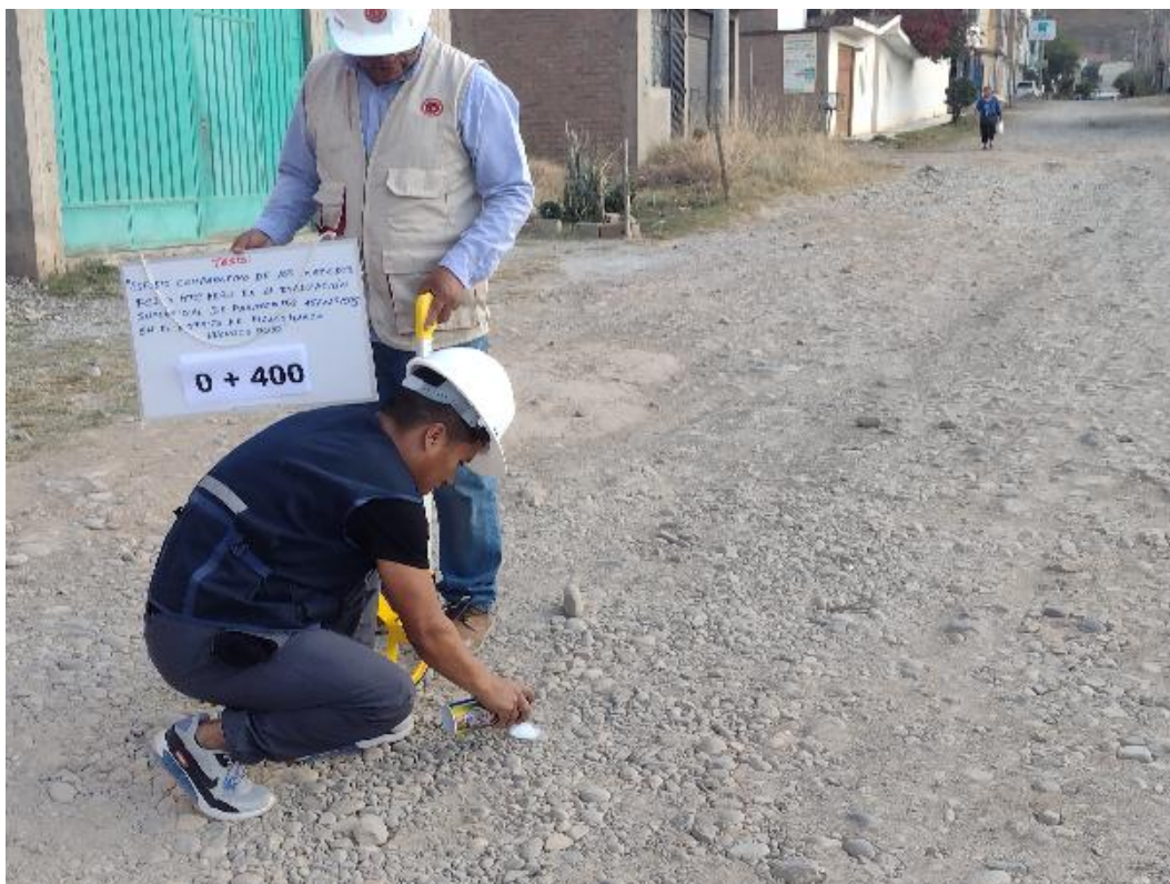
Fotografía 11 Vista de la progresiva 0+400 del Jr. Los Alisos
