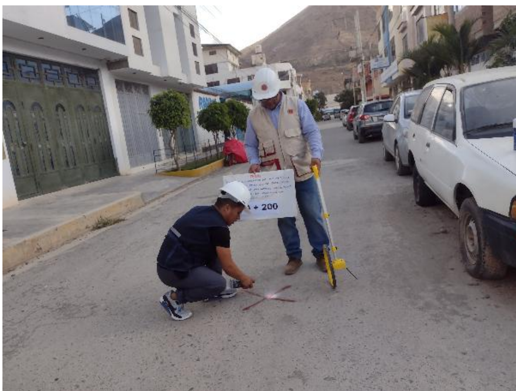
Fotografía 6 Vista de la progresiva 0+200 del Jr. Los Alisos
