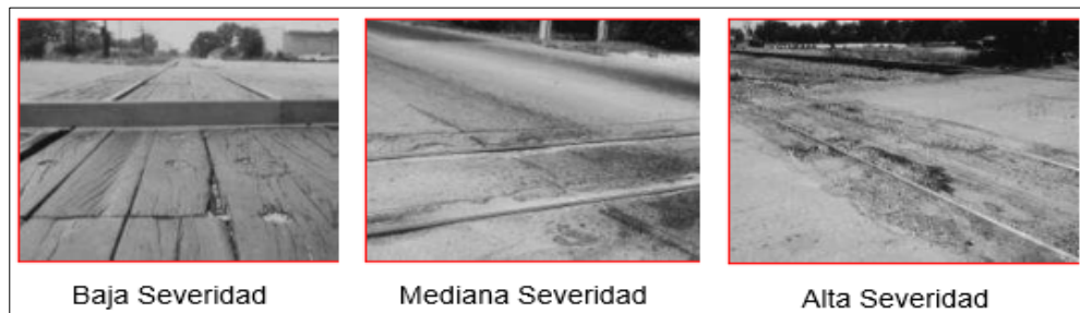
Figura 18 Cruce de vía férrea
