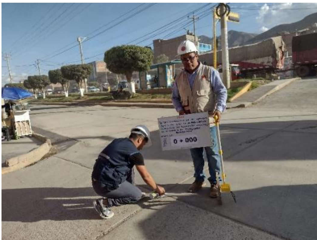
Fotografía 13 Vista de la progresiva 0+000 del Jr. Los Vilcos
