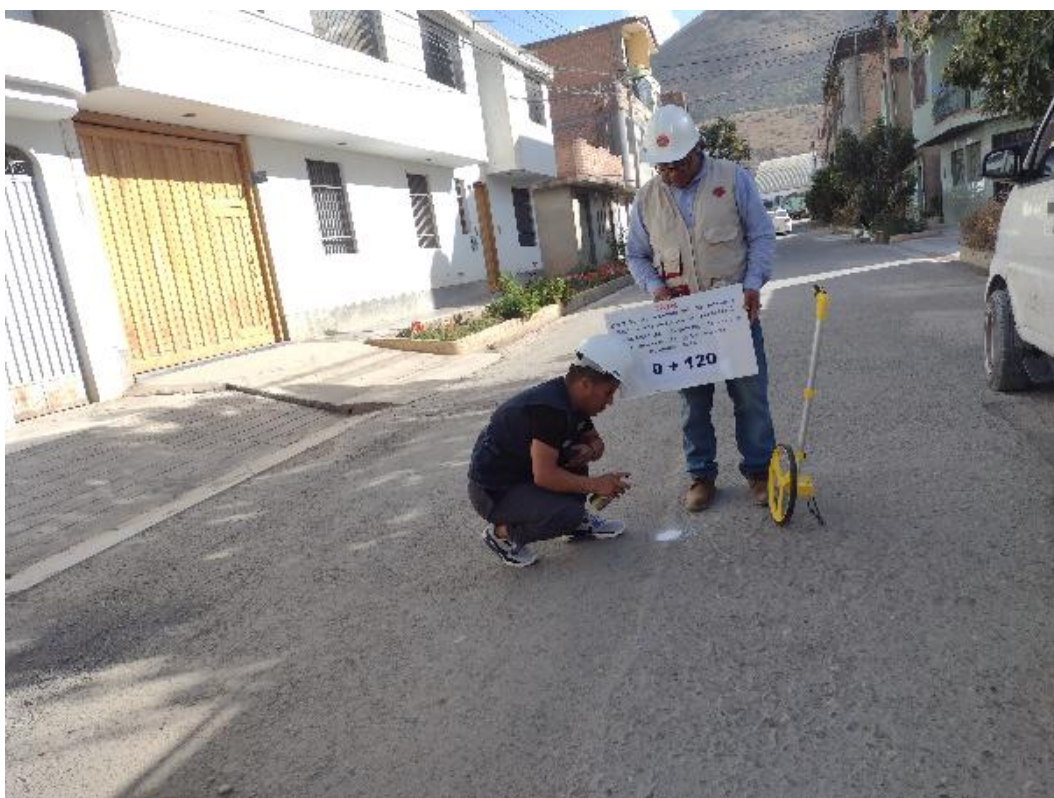
Fotografía 4 Vista de la progresiva 0+120 del Jr. Los Alisos
