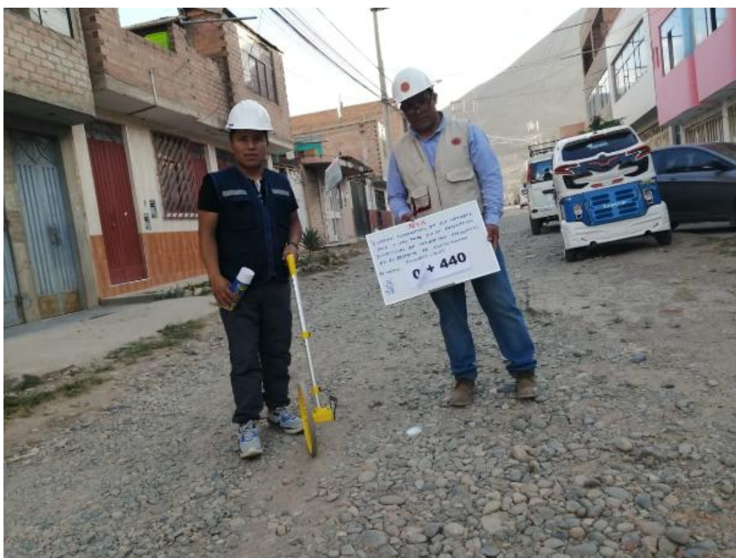
Fotografía24 Vista de la progresiva 0+440 del Jr. Los Vilcos
