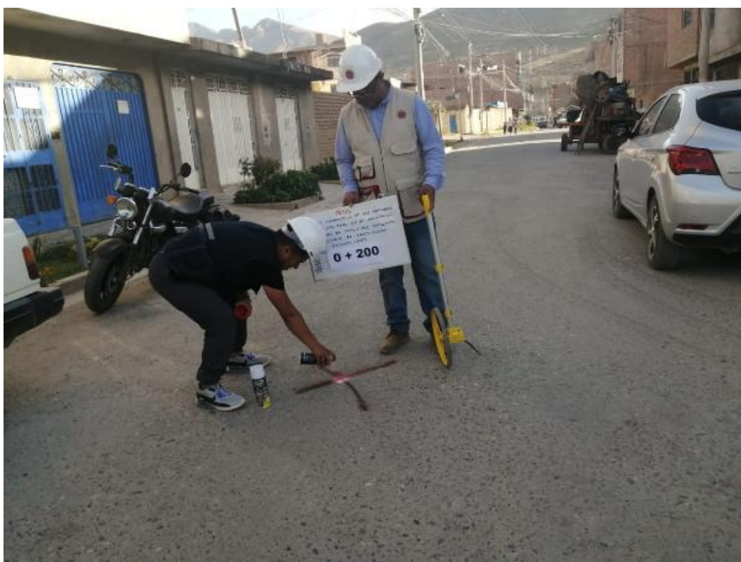
Fotografía 18 Vista de la progresiva 0+200 del Jr. Los Vilcos
