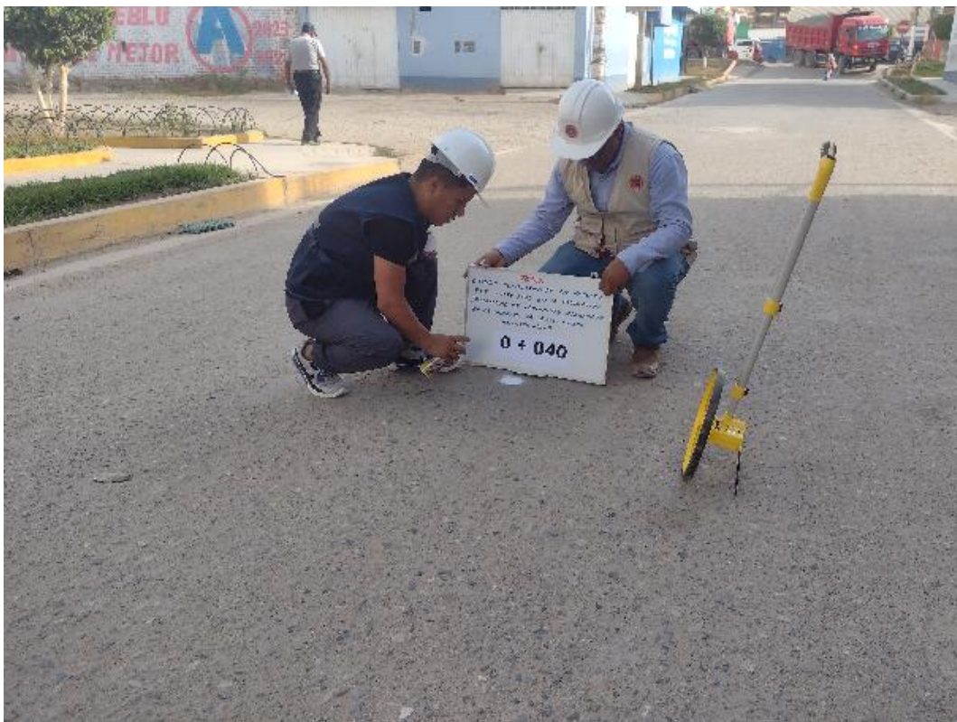
Fotografía 2 Vista de la progresiva 0+040 del Jr. Los Alisos
