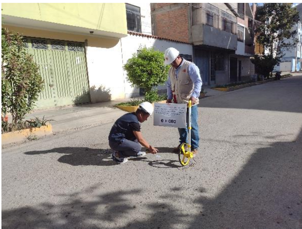
Fotografía 3 Vista de la progresiva 0+080 del Jr. Los Alisos
