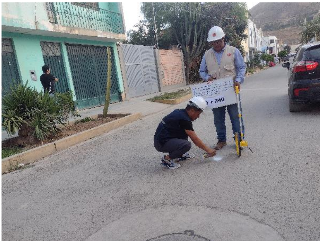
Fotografía 7 Vista de la progresiva 0+240 del Jr. Los Alisos
