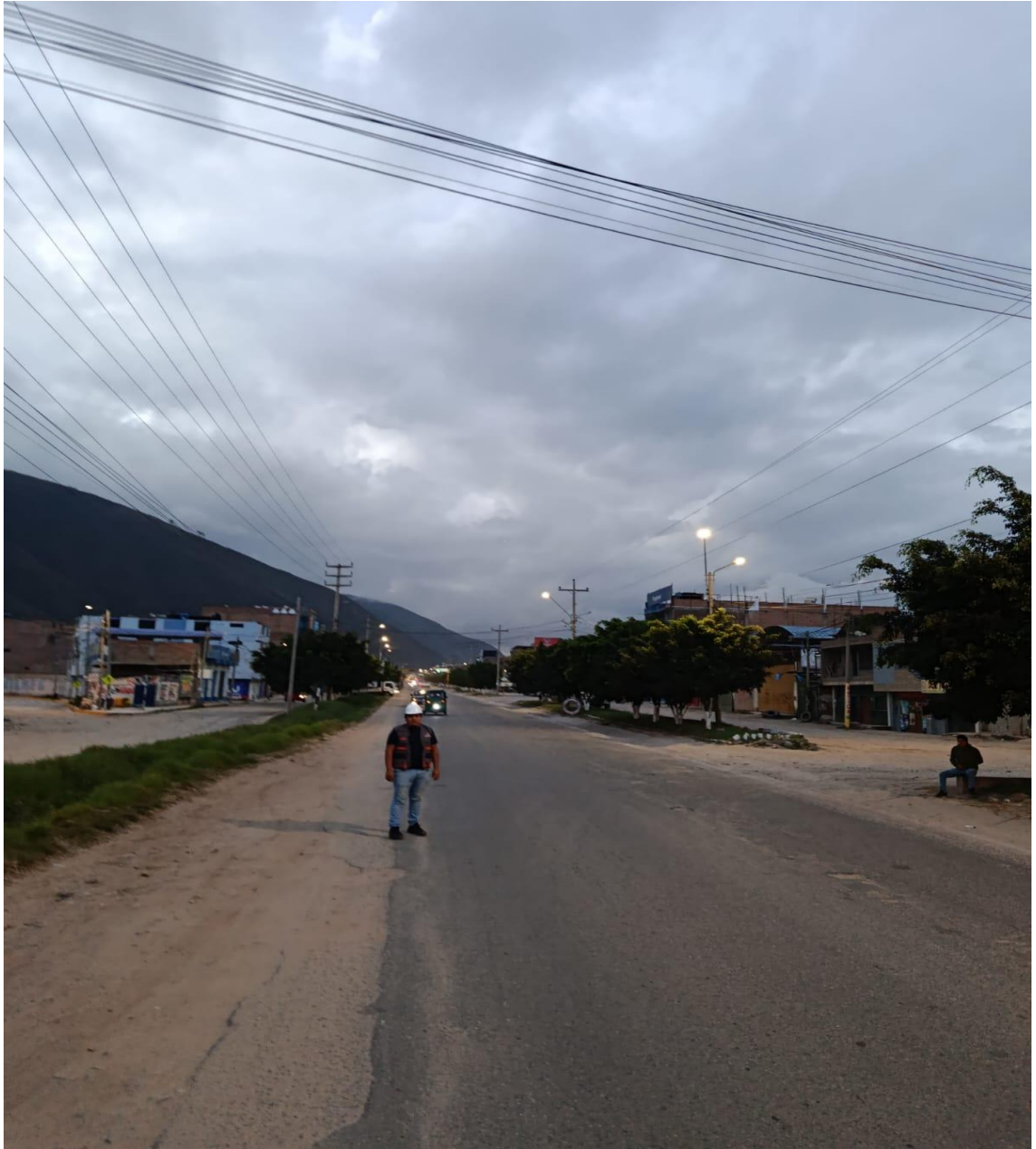
Foto panorámica longitudinal del eje vial
