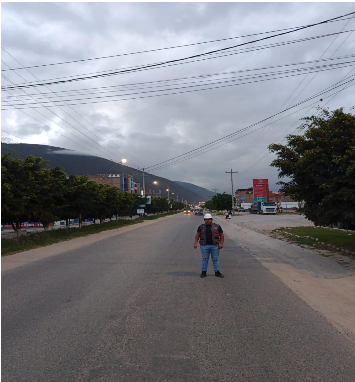
Foto panorámica longitudinal del eje vial
