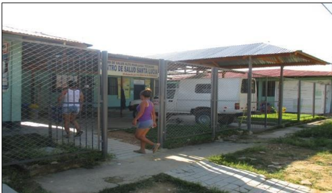
Ilustración 28: Posta Medica ESSALUD, Fuente: Autor de Tesis
