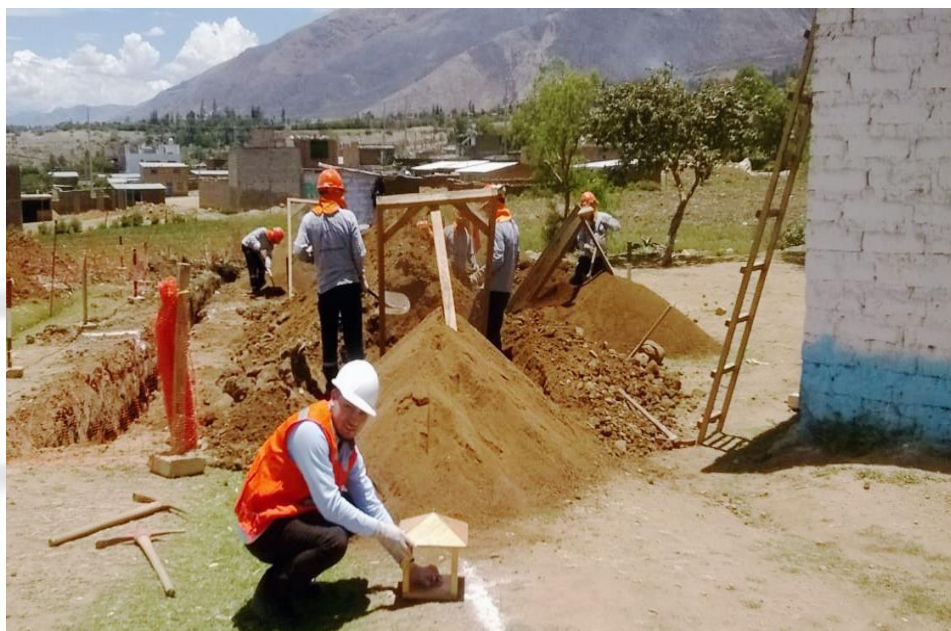
IMAGEN 08: INSTALANDO LA CASITA EN EL PUNTO DE MUESTREO EPM – 006 DE LA ZONA 3
