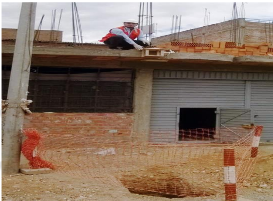
IMAGEN 04: INSTALANDO LA CASITA EN EL PUNTO DE MUESTREO EPM – 003 DE LA ZONA 1
